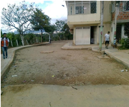
Figura 70. Base compactada y pozos nivelados.
