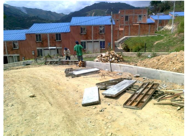
Figura 29. Sardinel construido en predio
