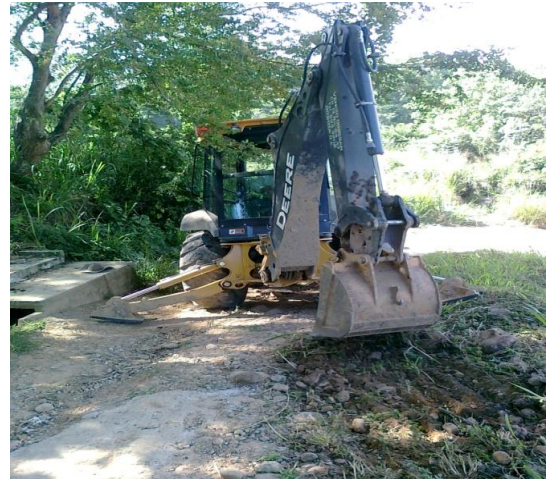
Figura 4. Inicios de Obra
