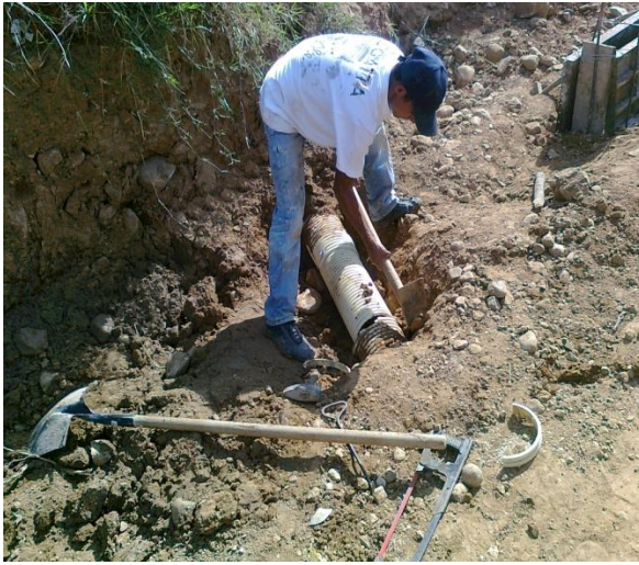
Figura 12. Arreglo de tubería
