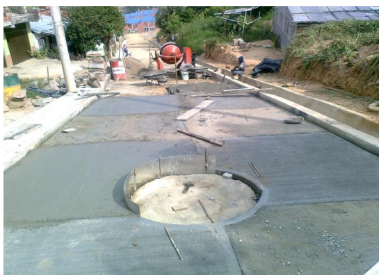
Figura 56 . Pozo listo para arreglar
