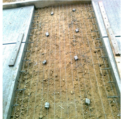
Figura 53. Cuadros de mortero
