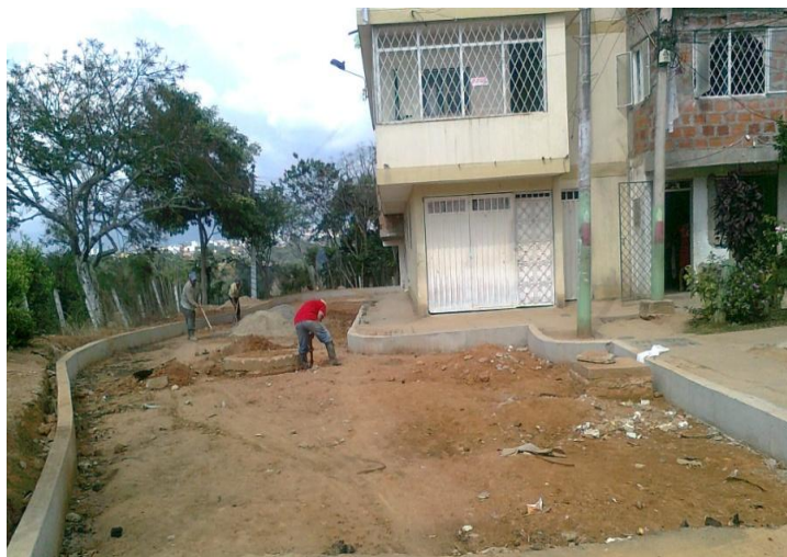
Figura 65. Movimiento de tierras con mano de obra
