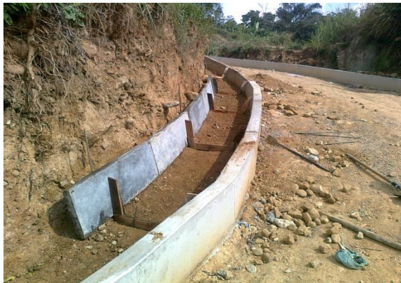
Figura 39. Construcción cuneta
