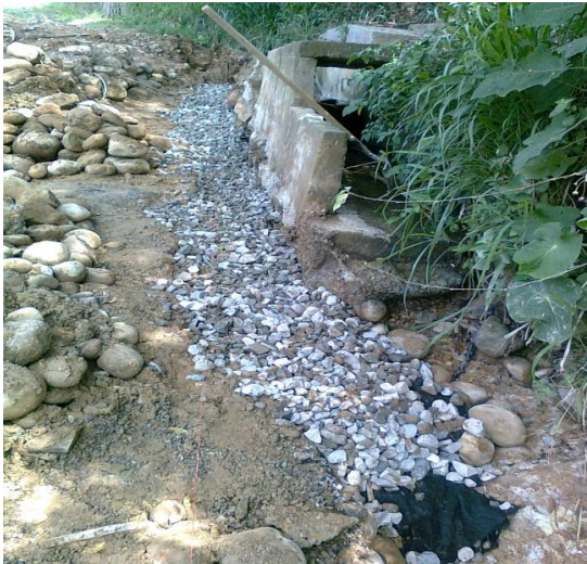
Figura 34. Filtro finalizado
