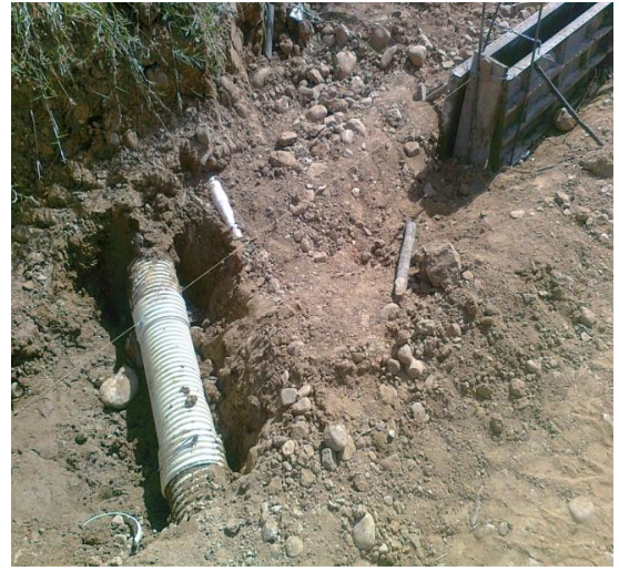
Figura 13. Tubería arreglada
