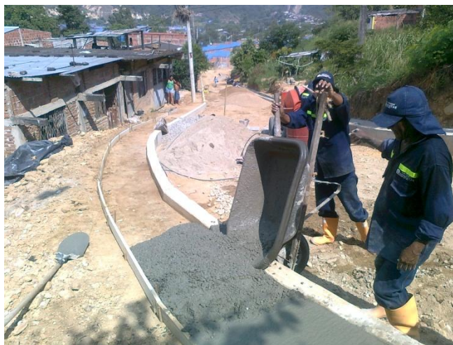
Figura 42. Inicios mezcla andén.
