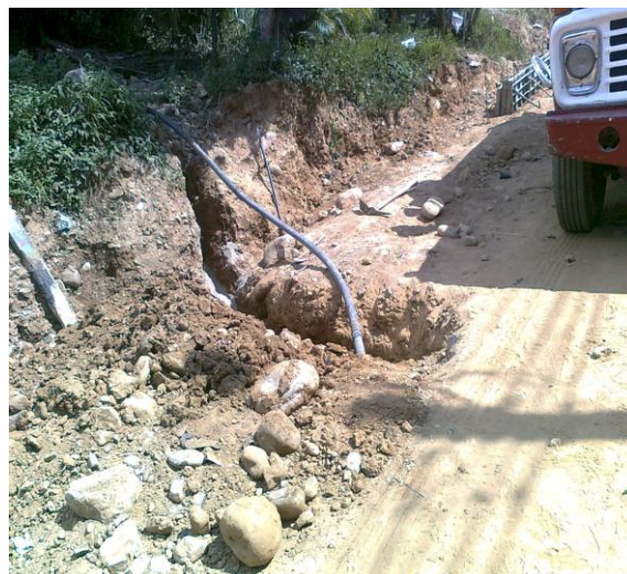
Figura 15. Excavación hueco tubería gas
