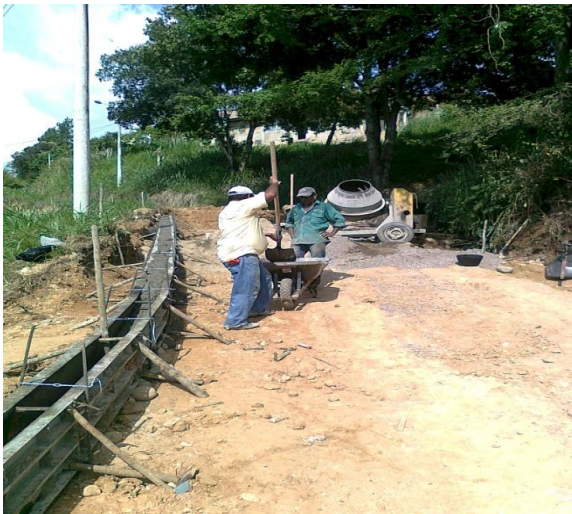
Figura 22. Elaboración mezcla
