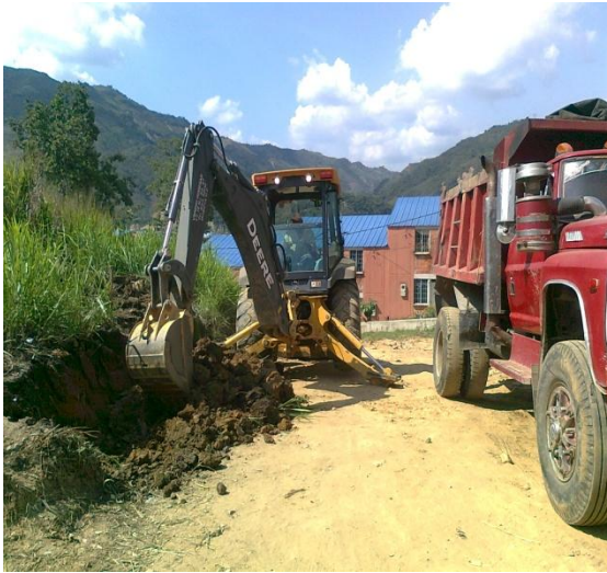
Figura 7. Inicio corte de Talud
