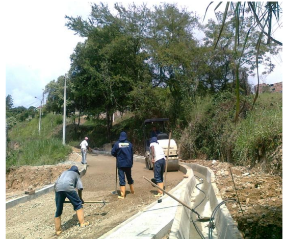
Figura 48. Nivelación y compactación
