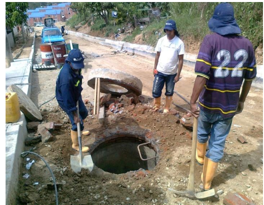
Figura 59. Remoción de material pozo
