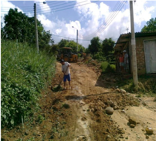
Figura 3. Inicios de Obra
