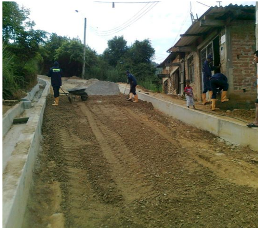
Figura 47. Nivelación de Base
