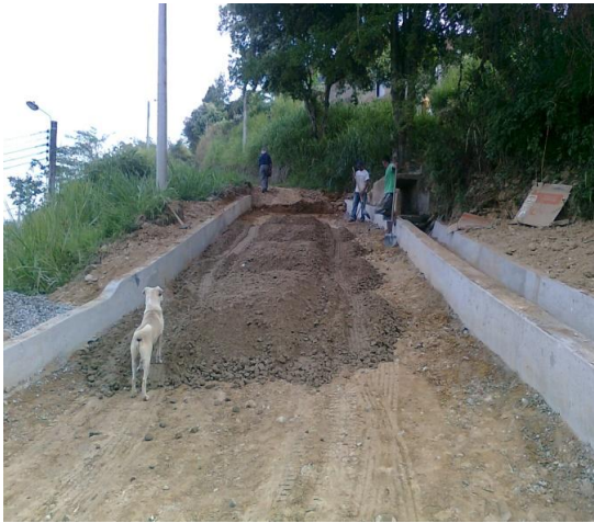
Figura 45. Aplicación Base
