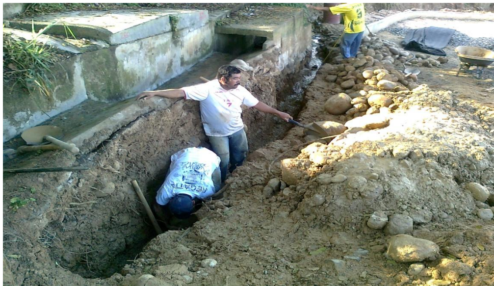
Figura 31. Elaboración de Filtro
