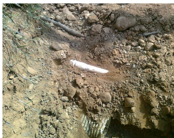
Figura 11. Tubería intacta acueducto
