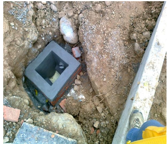
Figura 18.Caja de inspección finalizada
