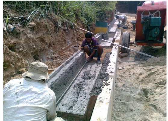
Figura 40. Regla para conformar superficie
