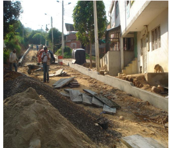
Figura 25. Desarmado de formaleta
