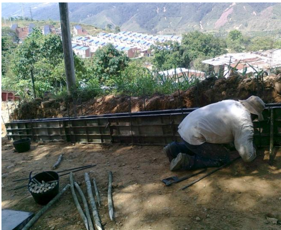
Figura 19. Armado de formaleta.
