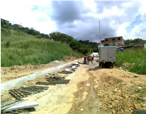
Figura 28. Sardinel construido en predio
