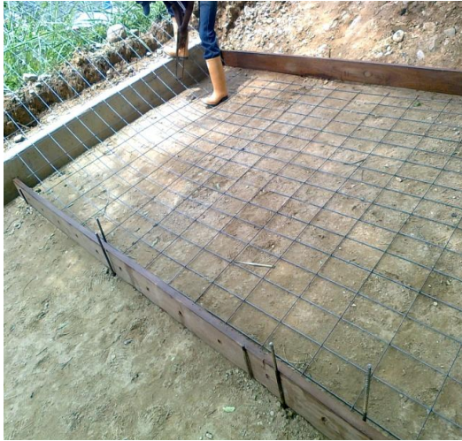
Figura 52. Malla electrosoldada
