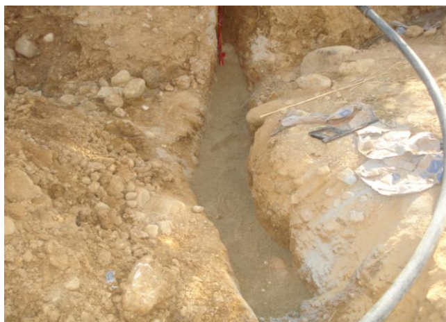
Figura 16. Tubería de gas ubicada y profundizada
