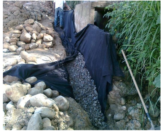
Figura 33. Tapando el filtro
