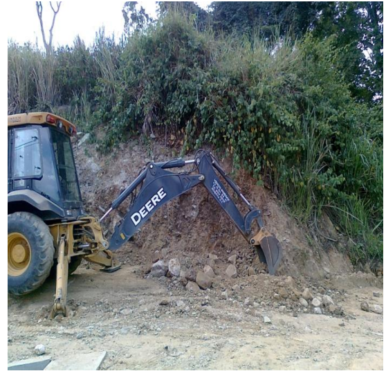
Figura 8. Corte de talud
