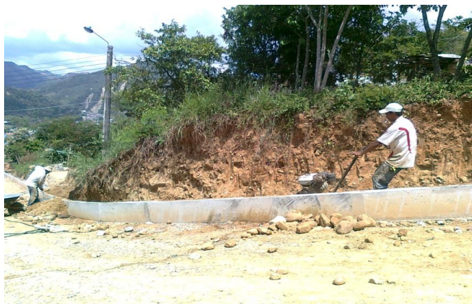
Figura 36. Compactación área de cuneta
