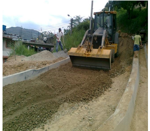
Figura 46. Aplicación Base
