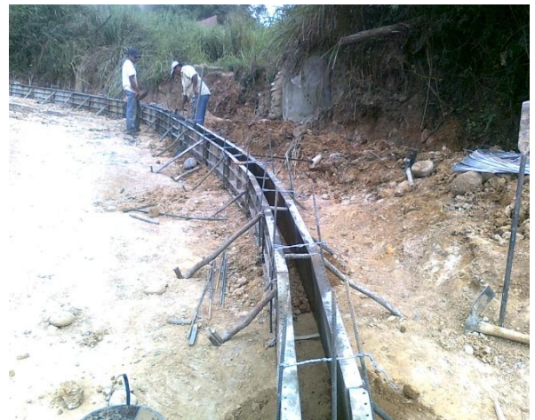
Figura 20. Armado de formaleta.
