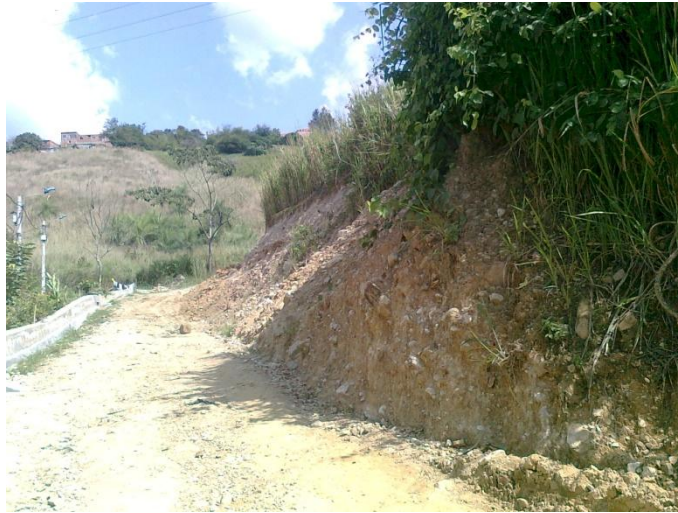
Figura 6. Vista de Talud desde K0+030 DER
