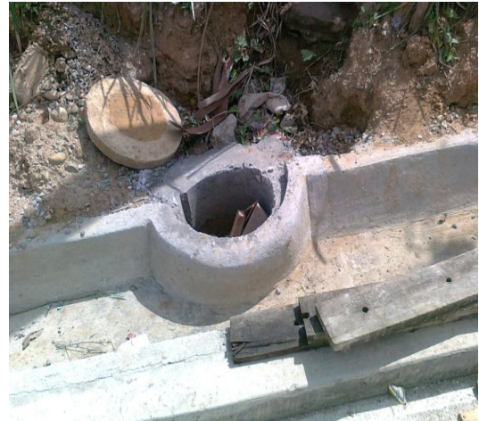
Figura 38. Modificación canaleta
