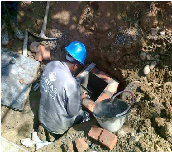
Figura 17.Elaboración caja de inspección
