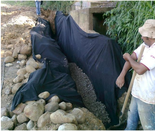
Figura 32. Geotextil extendido
