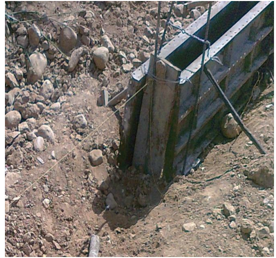
Figura 27. Formalela finalizada con tabla
