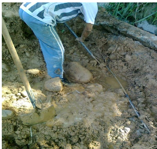
Figura 30. Terreno en mal estado por filtración
