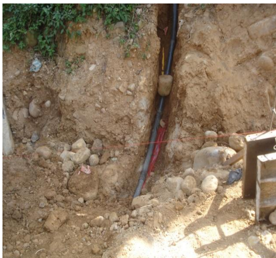
Figura 14. Adecuación tubería gas.
