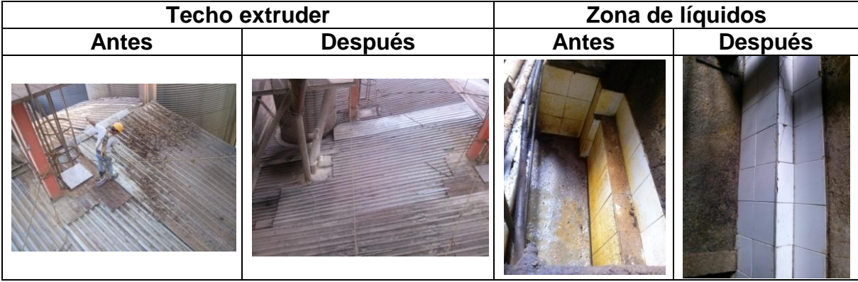
Figura 18. Limpieza techo de extruder y pared zona de líquidos.
