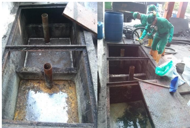
Figura 6. Limpieza trampa de grasas por parte de la empresa Celan Car.
