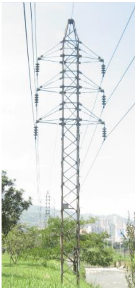
Estructura compacta metálica
