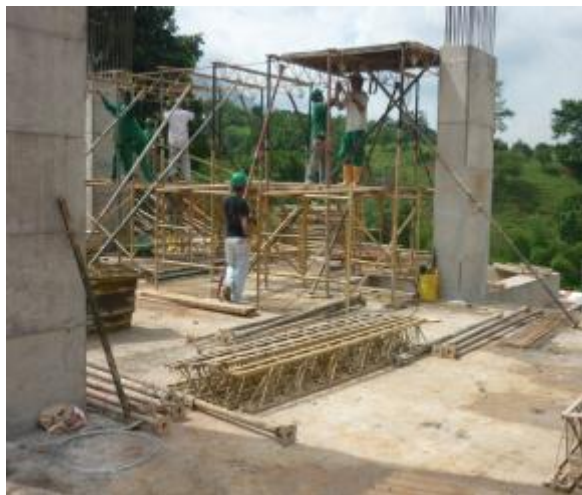
Imagen 4. Sección de andamios para el armado de la placa aligerada
