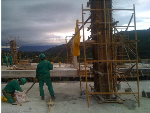
Imagen 220. Encofrado de columna
