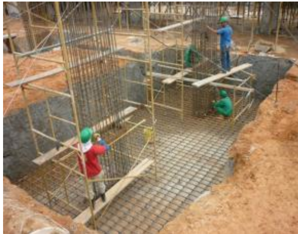
Imagen 3. Sección de andamios para el amarre de los estribos
