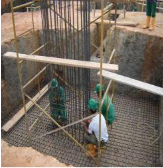
Imagen 100. Armado pedestal
