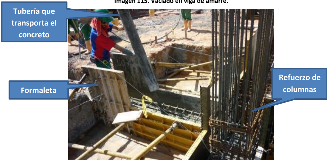
Imagen 115. Vaciado en viga de amarre.
