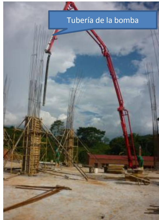
Imagen 159. Vaciado de columnas
