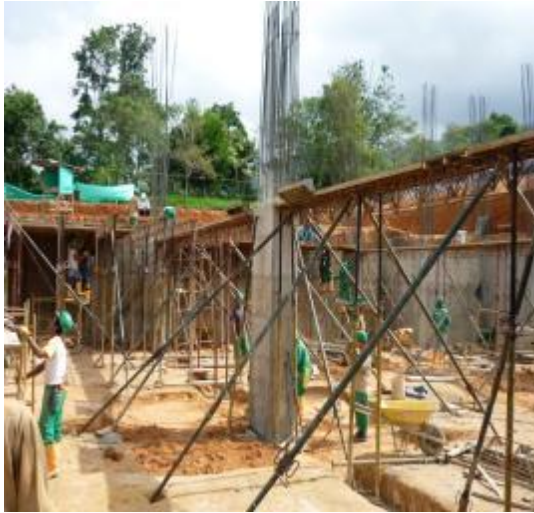
Imagen 140. Armado de estructura provisional
