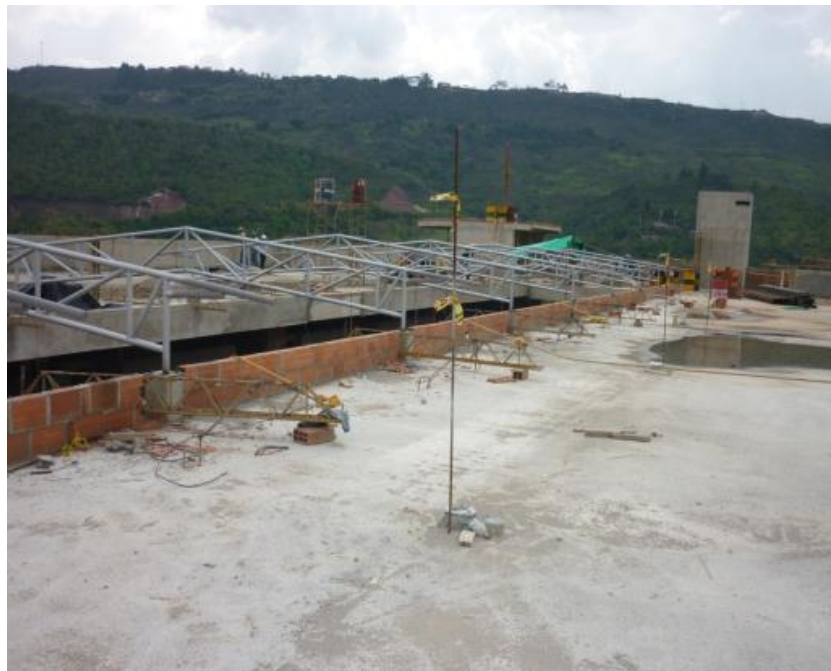
Imagen 232. Cubierta del quinto piso
