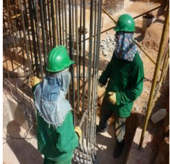
Imagen 131. Armado de las columnas del sótano
