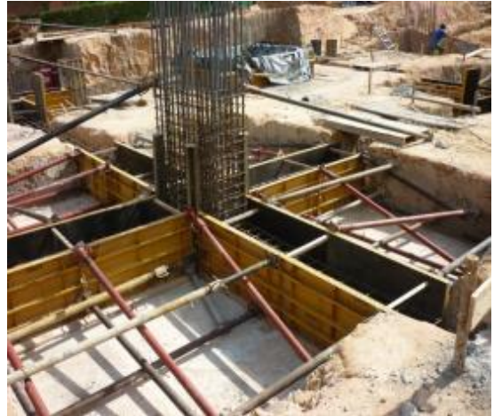
Imagen 109. Encofrado vigas de amarre
