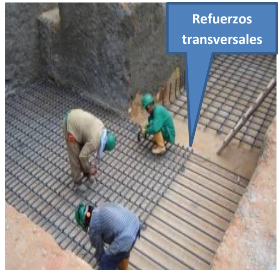
Imagen 99. Armado del refuerzo
