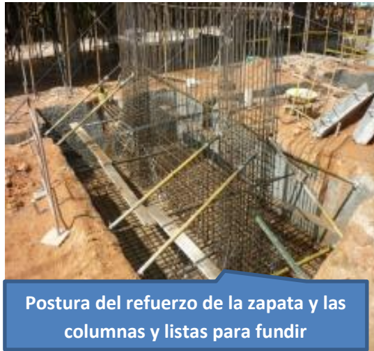
Imagen 164. Armado refuerzo cimentación
