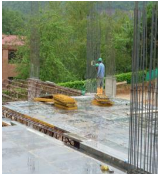
Imagen 143. Armado de estructura provisional
