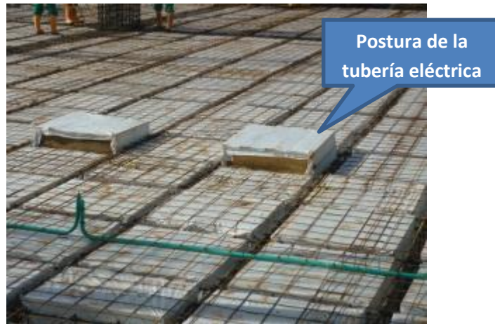
Imagen 148. Placa lista para fundirse
