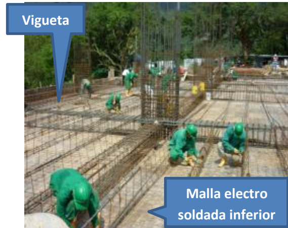
Imagen 145. Armado refuerzos losa
