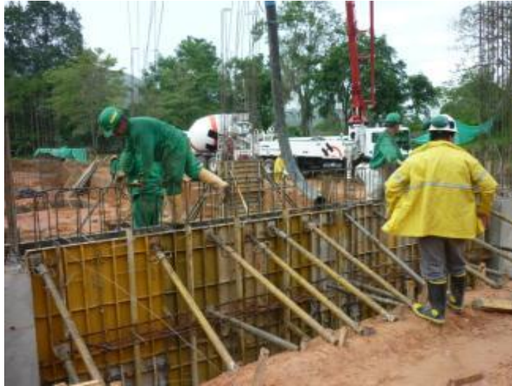
Imagen 35. parales metalicos para sostener la formaleta de las pantallas
