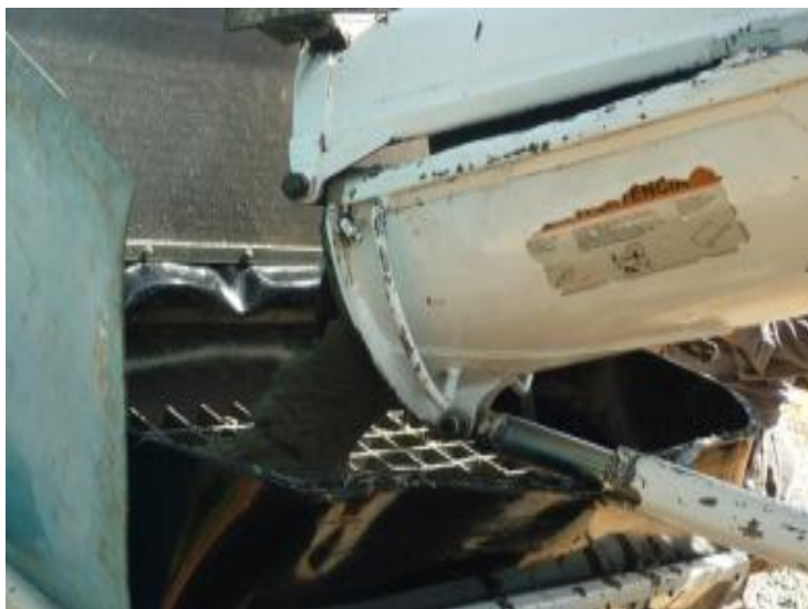
Imagen 113. Concreto de la mezcladora a la bomba
