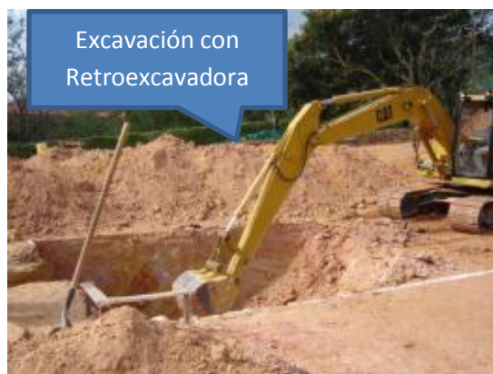
Imagen 91. Excavación con maquina
