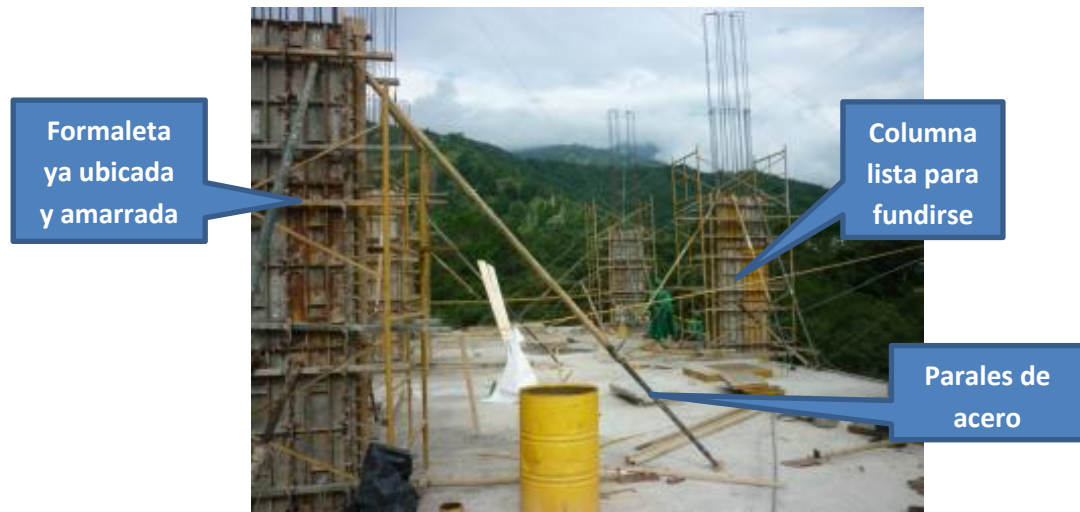
Imagen 203. Encofrado de columnas
