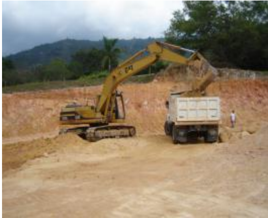
Imagen 19. Excavación a maquina
