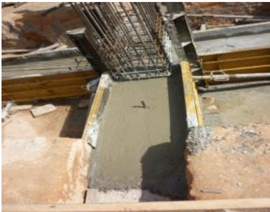
Imagen 110. Viga terminada
