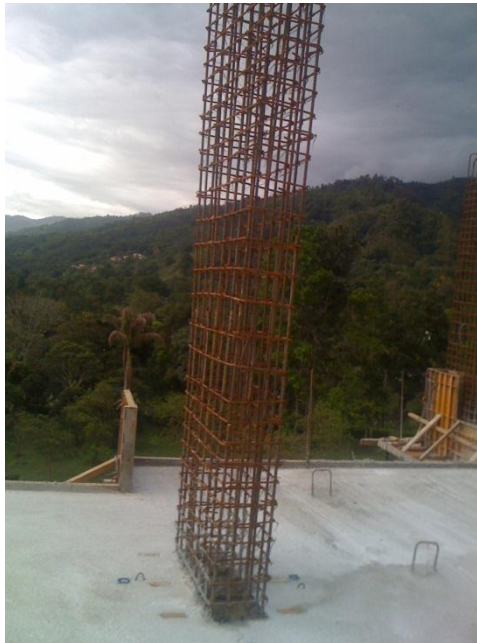
Imagen 219. Refuerzo de columna
