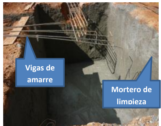
Imagen 163. Mortero de limpieza excavación
