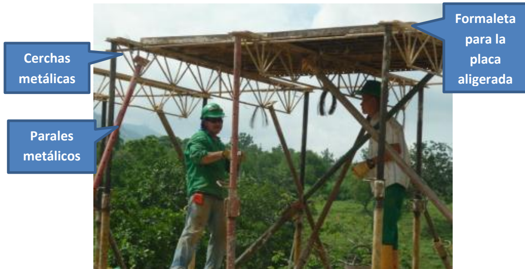
Imagen 166. Armado de la estructura provisional
