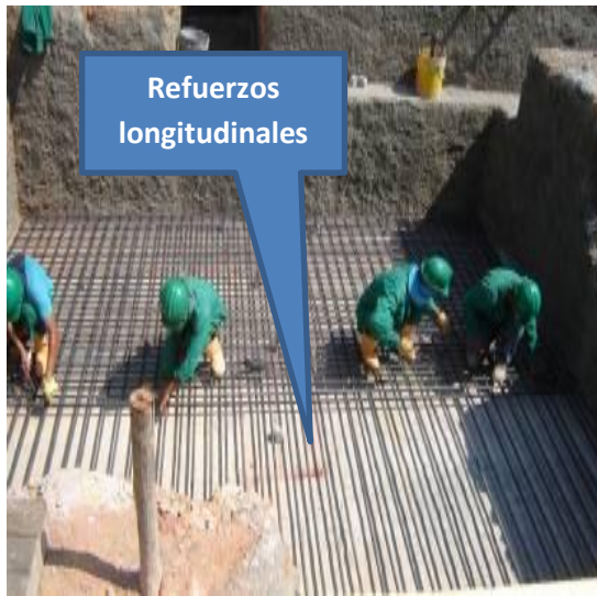
Imagen 98. Armado del refuerzo
