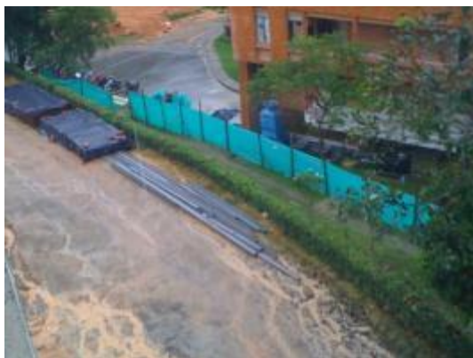
Imagen 74. Cerramiento para personal no autorizado
