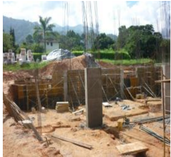
Imagen 165. Columnas terminadas
