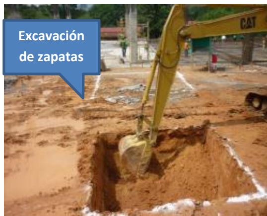
Imagen 162. Excavación a máquina de zapatas
