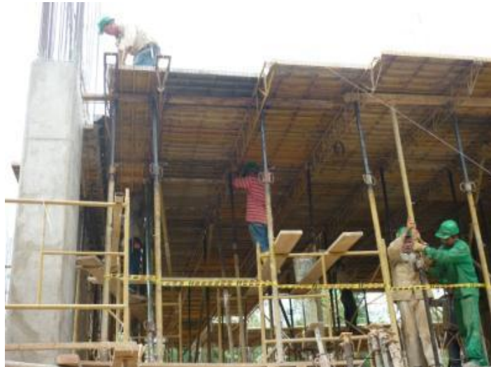
Imagen 34. Instalación de parales
