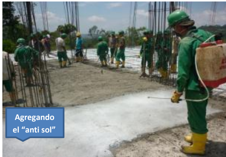
Imagen 230. Aplicando el Antisol
