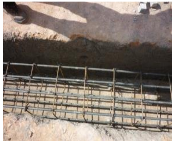
Imagen 107. Armado vigas de amarre
