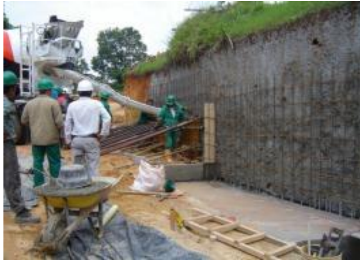
Imagen 88. Vaciado de concreto.
