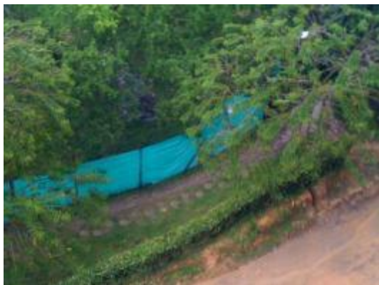
Imagen 72. Cerramiento Occidental de la obra
