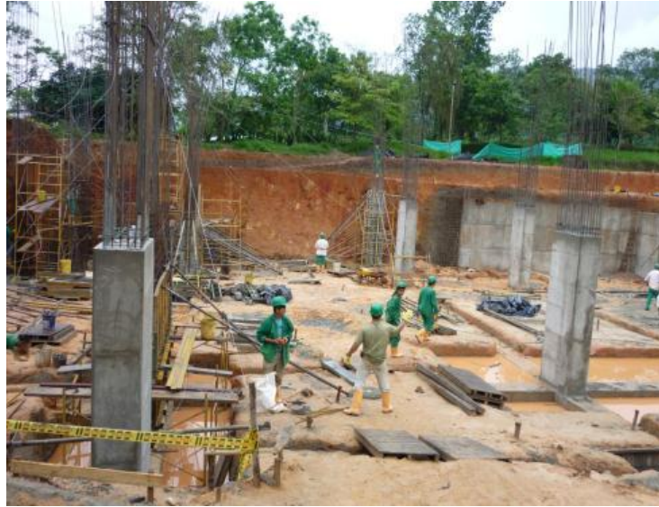
Imagen 139. Columnas terminadas
