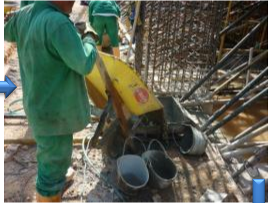
Imagen 125. Transporte concreto con carretilla
