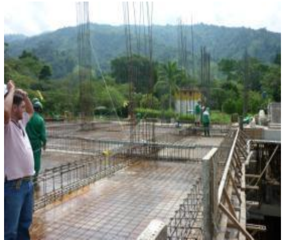
Imagen 196. Vigas de amarre y columnas
