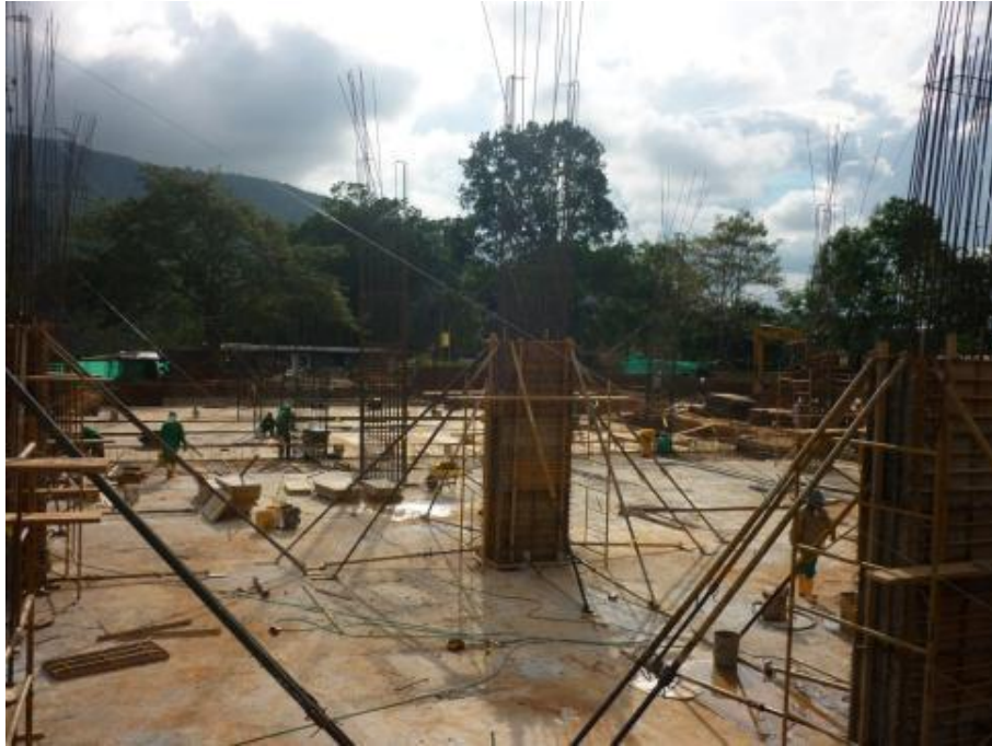
Imagen 188. Encofrado columnas segundo piso.
