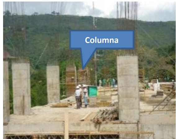
Imagen 205. Retiro de formaleta
