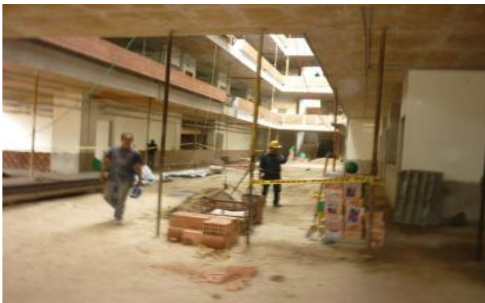
Imagen 173. Avance constructivo semisótano
