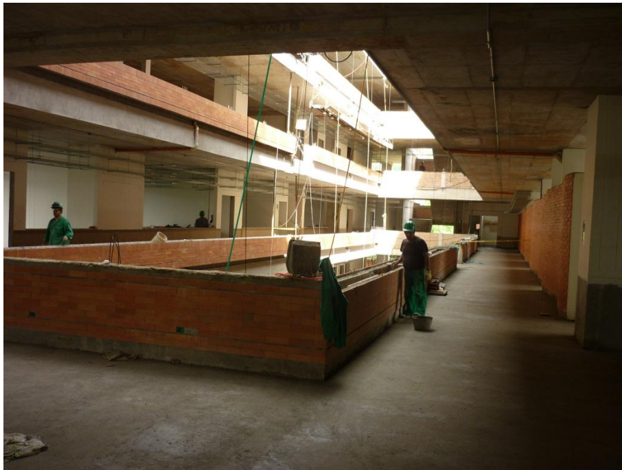
Imagen 200. Avance del segundo piso
