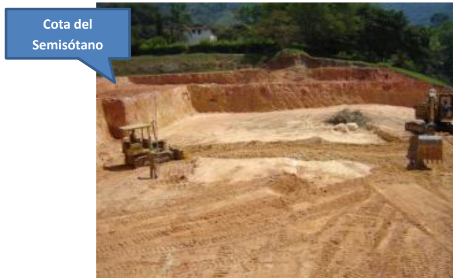
Imagen 57. Excavación sótano y semisótano
