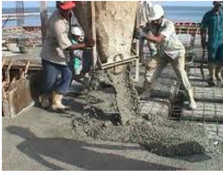
Imagen 15. Vaciado concreto 7
