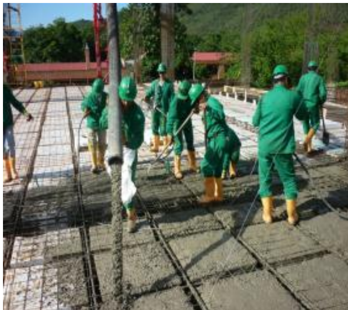
Imagen 16. Vaciado concreto losa.
