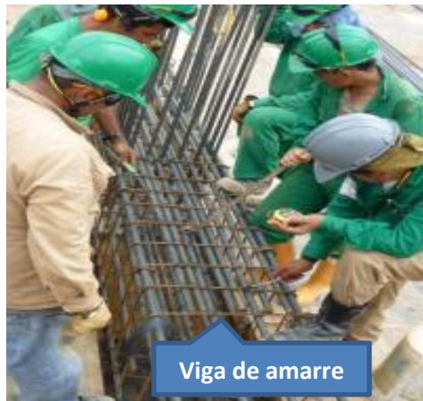
Imagen 144. Armado refuerzos viga
