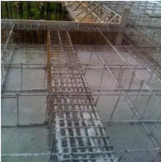
Imagen 207. Vigas, viguetas y torta inferior
