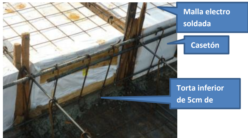
Imagen 147. Sección losa
