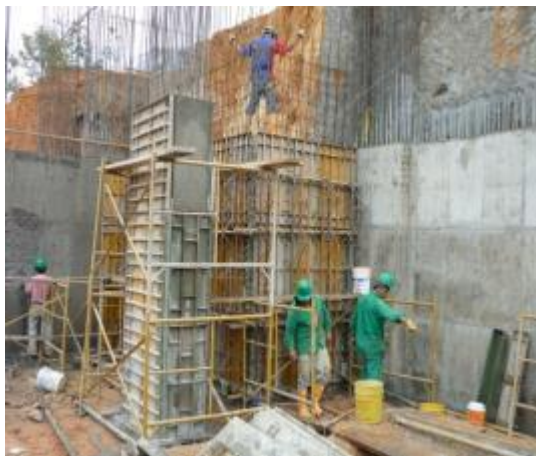
Imagen 137. Retiro de formaleta
