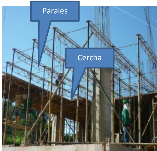
Imagen 176. Armado de estructura provisional o formaleta.
