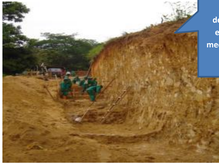
Imagen 86. Perfilación manual
