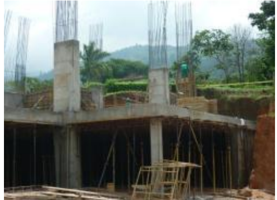
Imagen 161. Columnas terminadas
