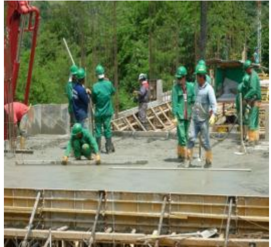
Imagen 170. Vaciado y nivelación de concreto
