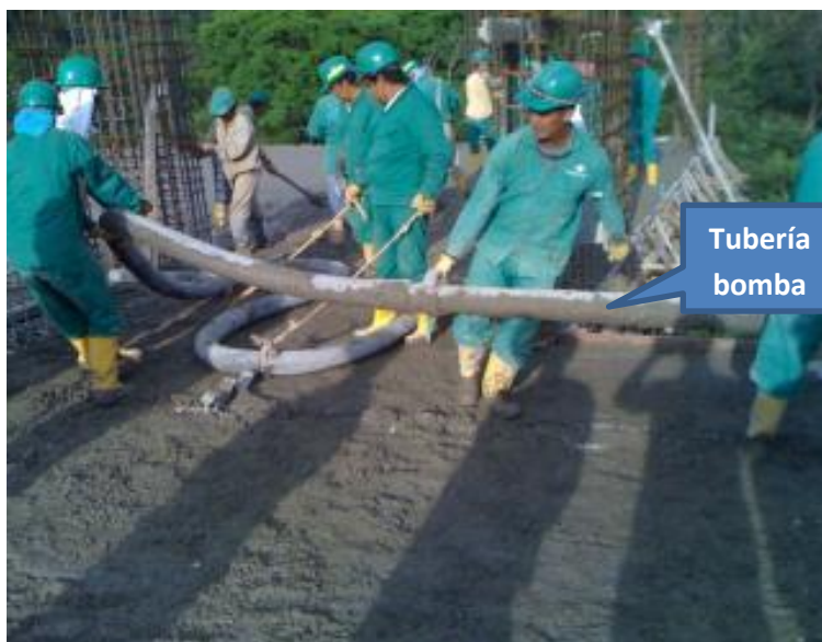
Imagen 227. Vaciado del concreto.
