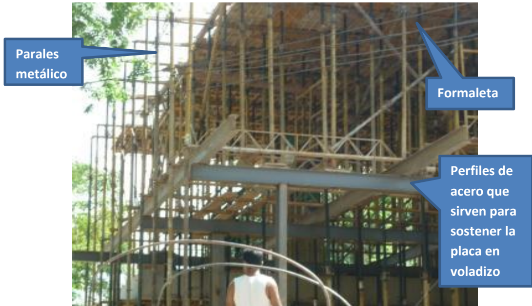
Imagen 193. Voladizo apoyado en la estructura de perfiles.
