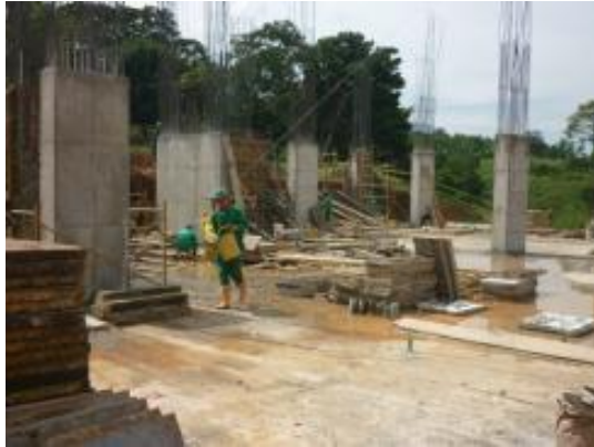
Imagen 160. Retiro de formaletas
