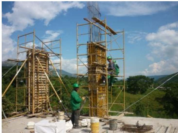
Imagen 40. Tablones de madera usados para la ubicación de la formaleta
