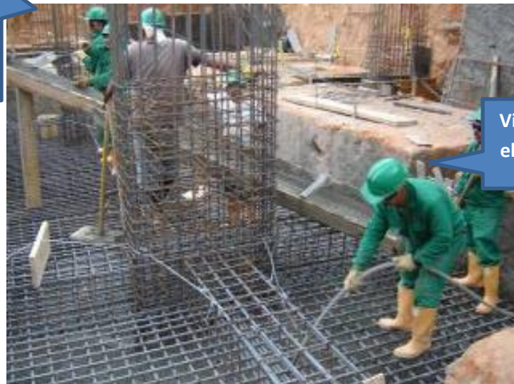
Imagen 103. Vaciado de zapatas
