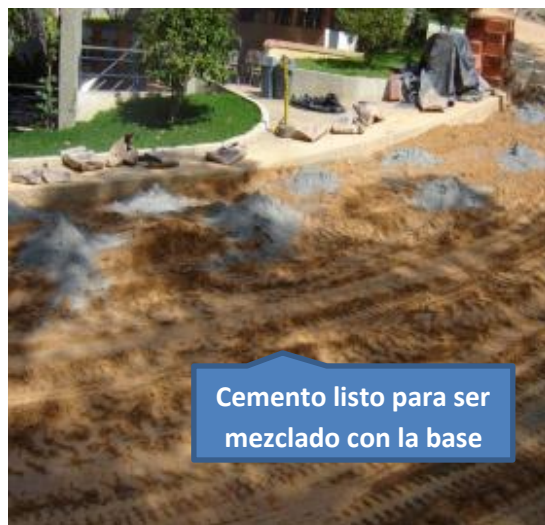
Imagen 84. Base con cemento para mezclar
