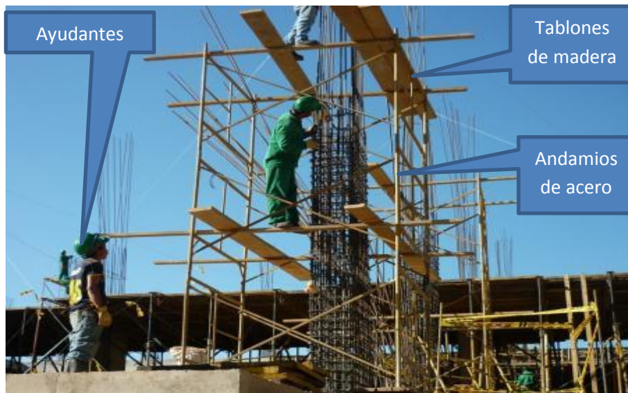
Imagen 174. Armado de refuerzo de columnas
