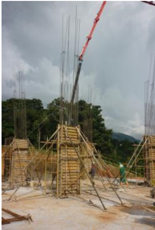
Imagen 158. Vaciado de columnas
