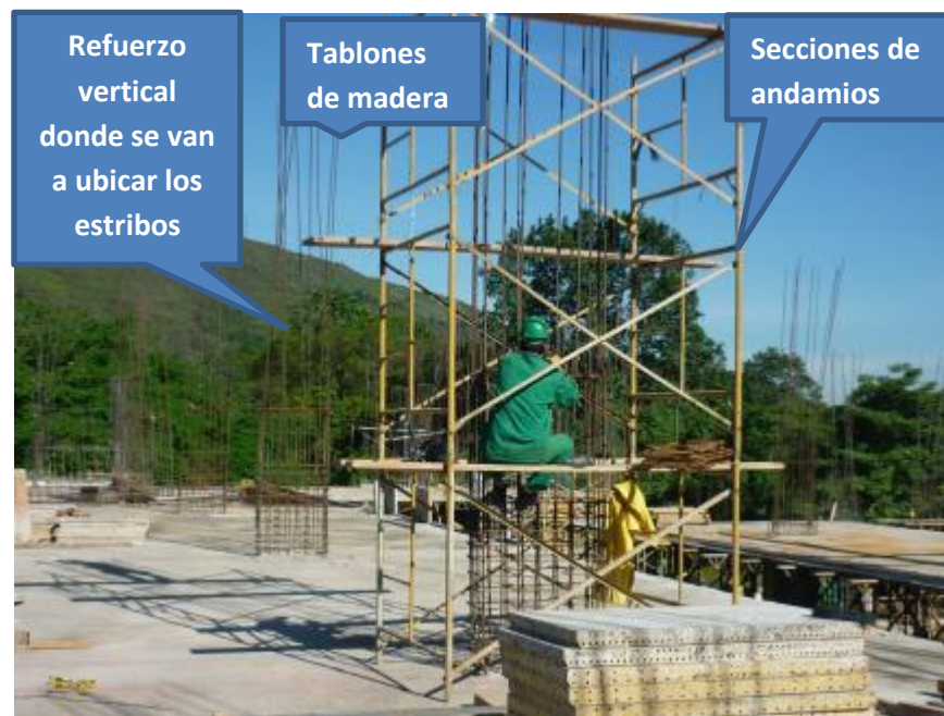
Imagen 214. Armado de refuerzo de columnas
