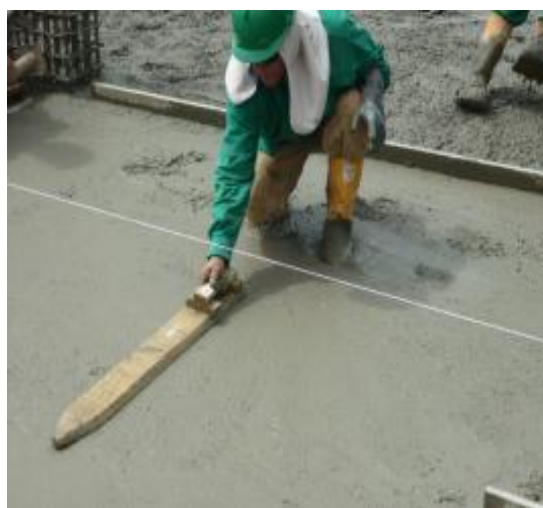
Imagen 151. Terminación con Llana de madera
