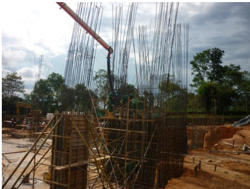
Imagen 189. Vaciado del concreto de columnas
