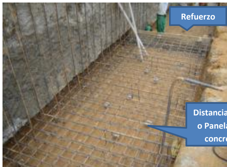
Imagen 87. Refuerzo del muro de contención
