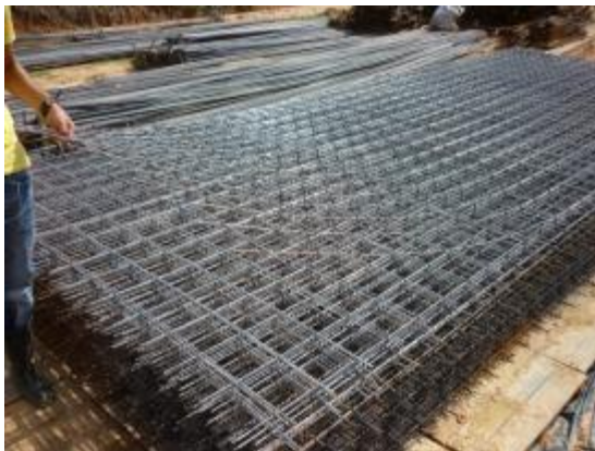
Imagen 27. Malla Electrosoldada
