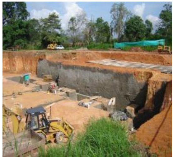
Imagen 95. Mortero de limpieza muros
