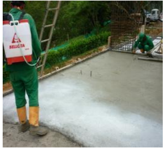
Imagen 153. Aplicación de antisol.
