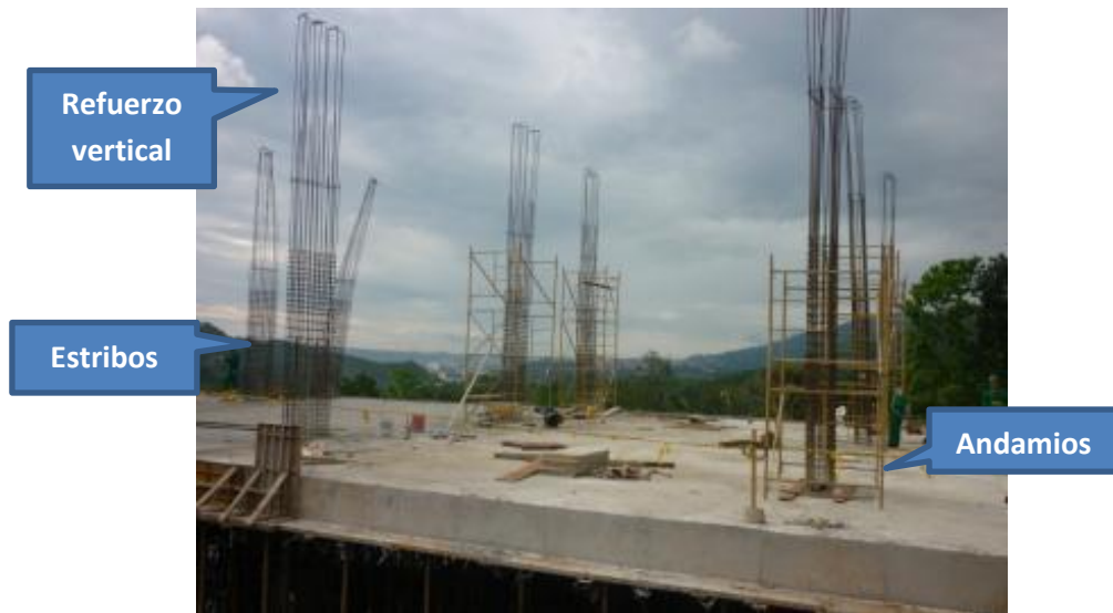
Imagen 201. Refuerzo de las columnas del tercer piso.
