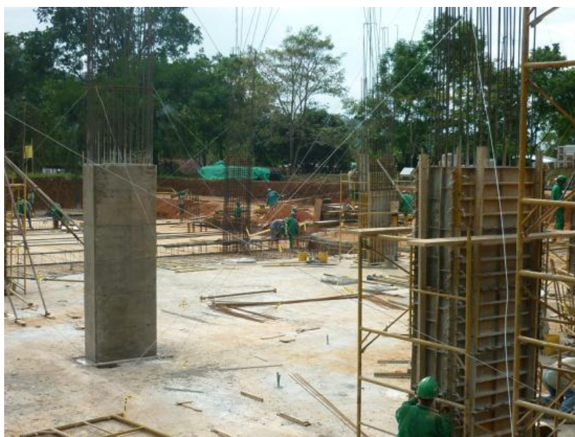
Imagen 190. Retiro de formaleta
