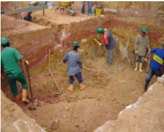
Imagen 21. Excavación manual de zapata
