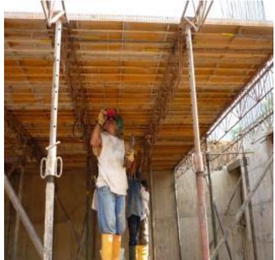
Imagen 141. Armado de estructura provisional
