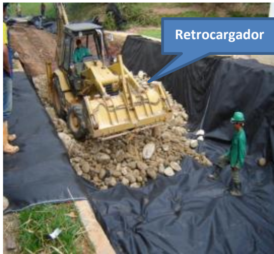
Imagen 81. Extendida con retrocargador
