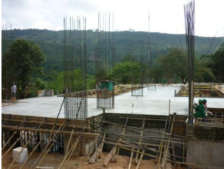
Imagen 184. Placa aligerada del nivel 3 ó primer piso
