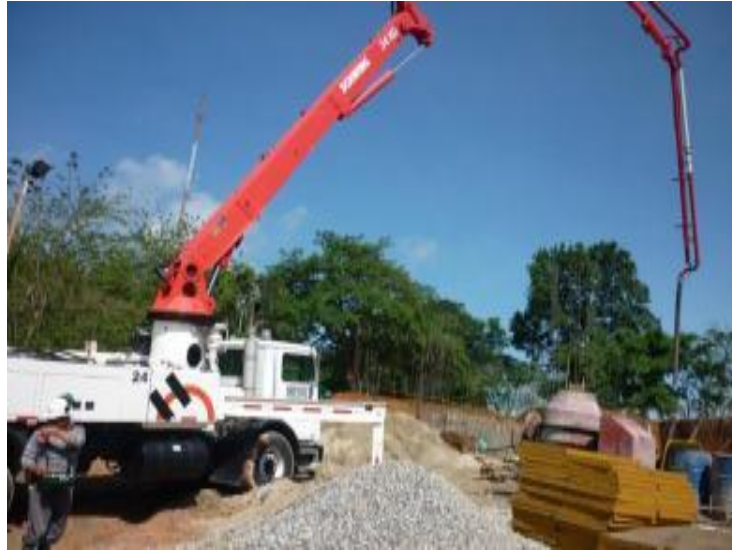
Imagen 114. Bomba de concreto
