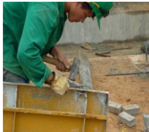
Imagen 138. Retiro de formaleta
