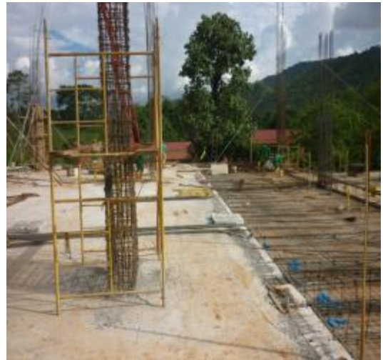
Imagen 187. Refuerzo losa entrepiso
