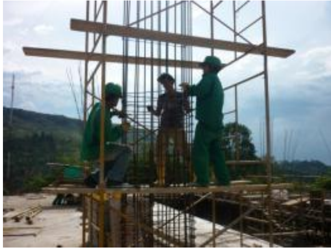
Imagen 202. Amarre de los estribos
