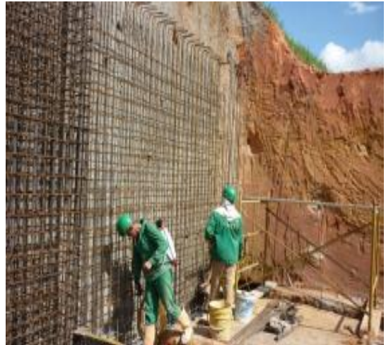
Imagen 121. Estribos de pantallas
