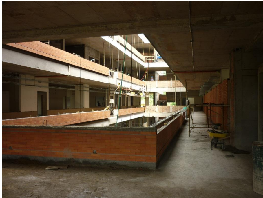
Imagen 213. Avance Tercer piso
