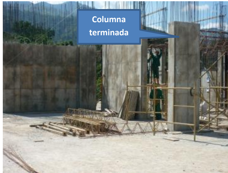
Imagen 216. Vaciado y retiro de la formaleta de columnas
