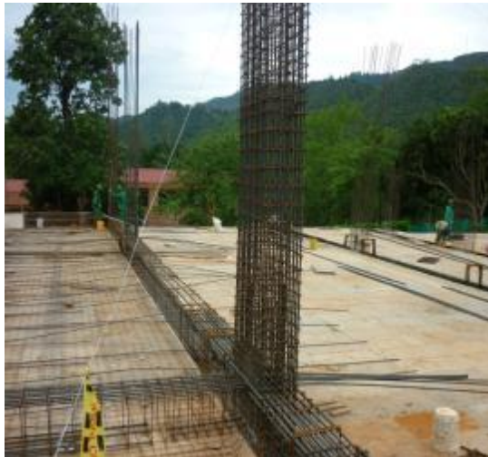
Imagen 186. Refuerzo de columnas y vigas
