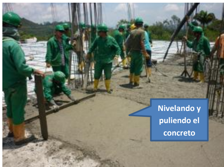
Imagen 229. Nivelación concreto
