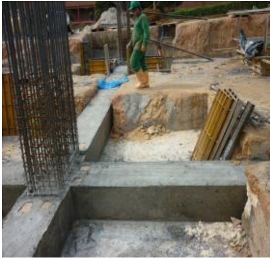
Imagen 118. Retiro de formaleta
