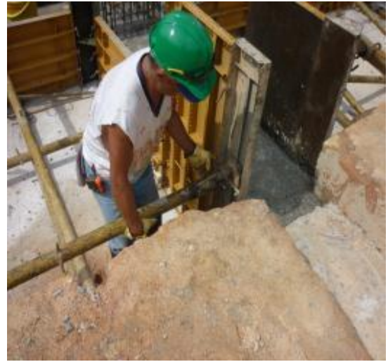
Imagen 119. Retiro de formaleta
