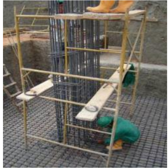
Imagen 101. Armado pedestal y columna
