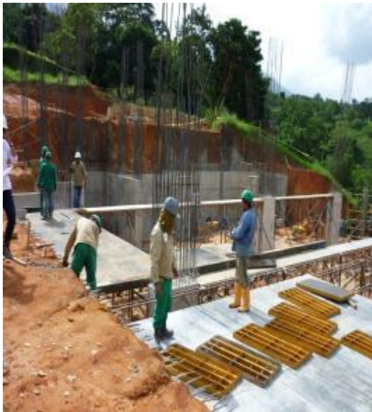
Imagen 142. Armado de estructura provisional
