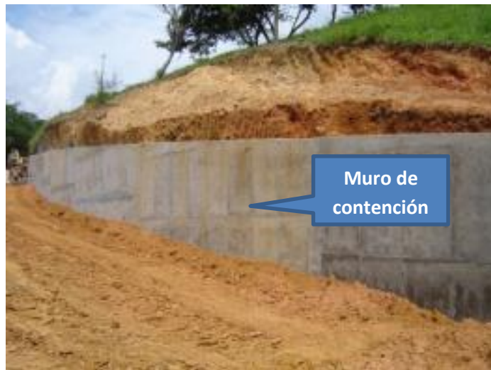
Imagen 89. Muro de contención
