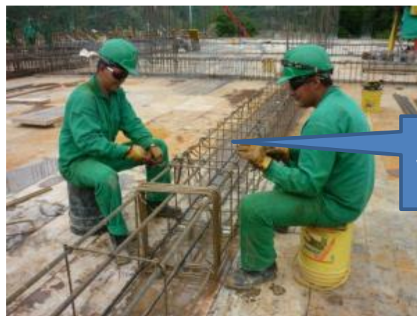
Imagen 221. Armado de viga
