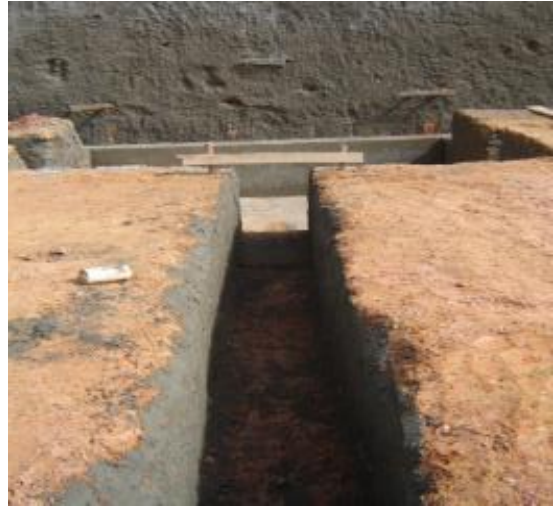
Imagen 97. Mortero de limpieza Vigas
