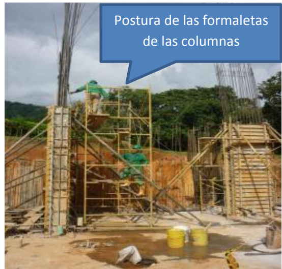
Imagen 157. Encofrado columnas
