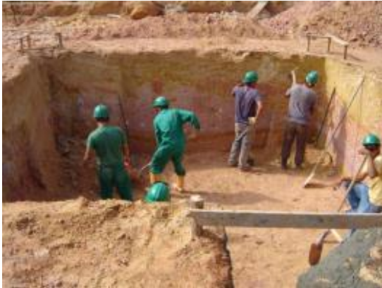
Imagen 92. Perfilación manual
