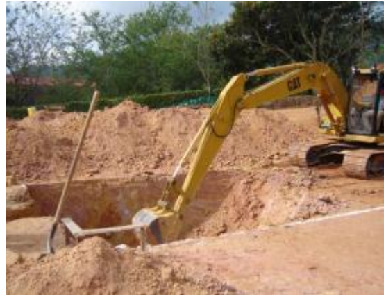
Imagen 20. Excavación a máquina de zapatas
