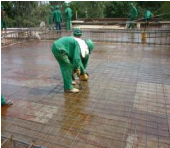
Imagen 195. Armado de losa de entrepiso
