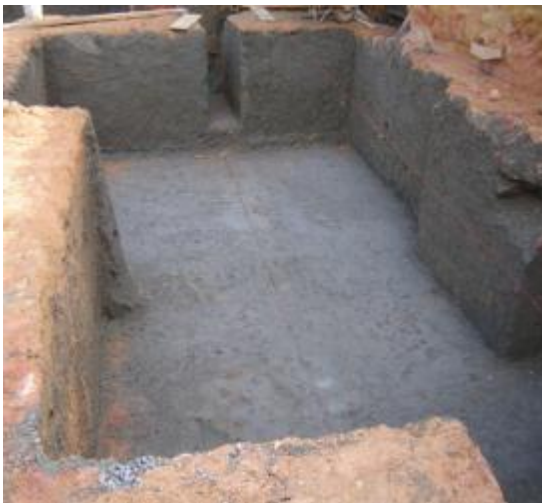
Imagen 94. Mortero de limpieza de zapata
