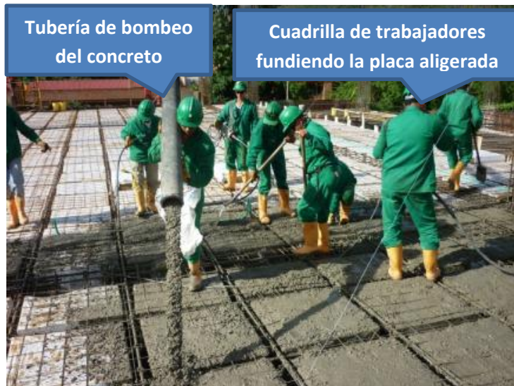
Imagen 149. Vaciado del concreto de la placa aligerada
