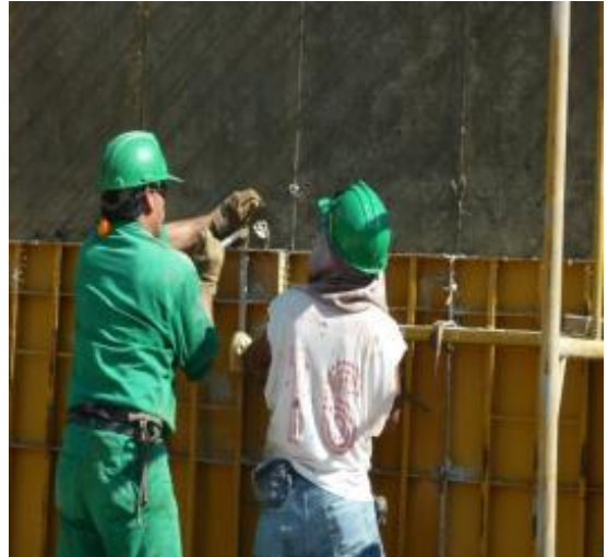
Imagen 129. Retiro de formaleta de pantallas
