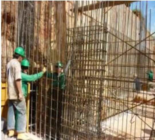
Imagen 120. Refuerzos verticales de pantallas
