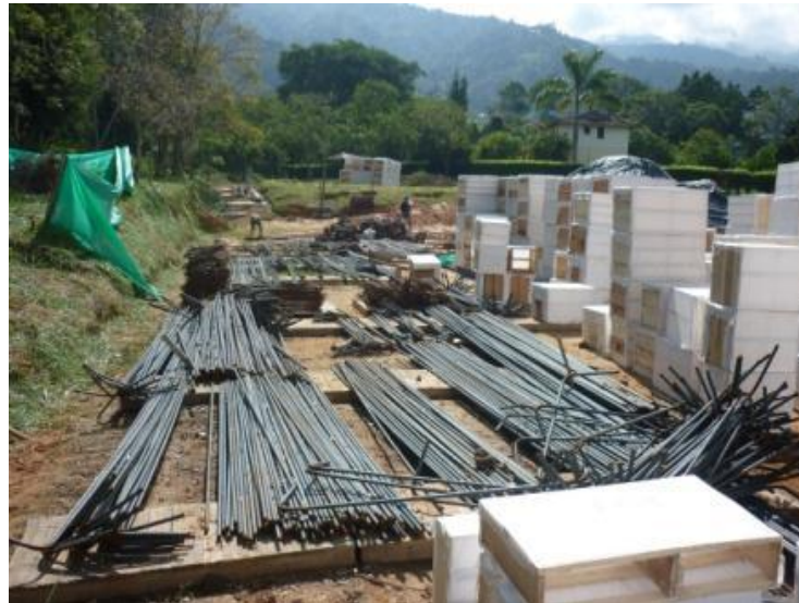
Imagen 44. Aceros para la placa aligerada
