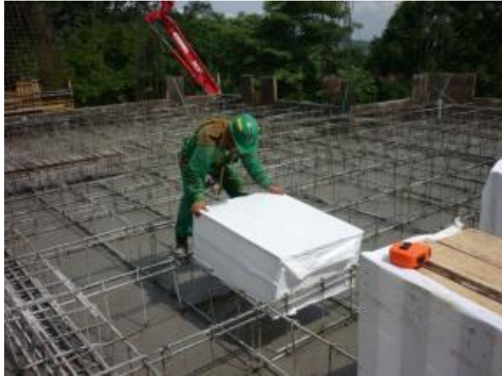
Imagen 48. Postura de los casetones una vez se haya colocado la torta inferior
