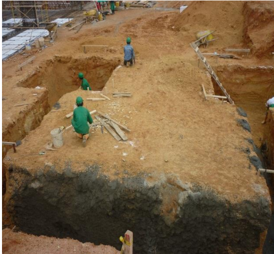
Imagen 96. Mortero de limpieza Cimentación
