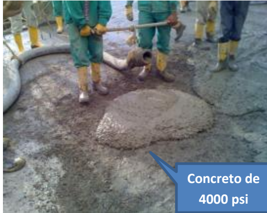
Imagen 209. Vaciado de losa del tercer piso
