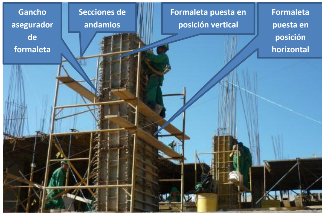
Imagen 215. Encofrado de columnas
