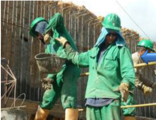
Imagen 126. Vaciado de pantallas o muros
