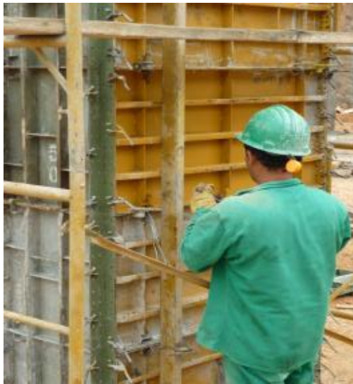
Imagen 17. Gancho asegurador ubicado
