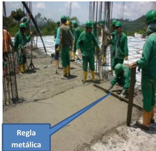
Imagen 211. Nivelación losa
