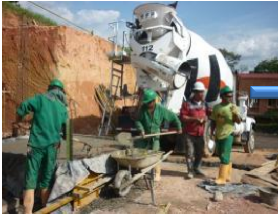
Imagen 124. Descargue de concreto a batea
