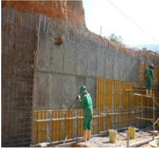
Imagen 128. Retiro de formaleta de pantallas
