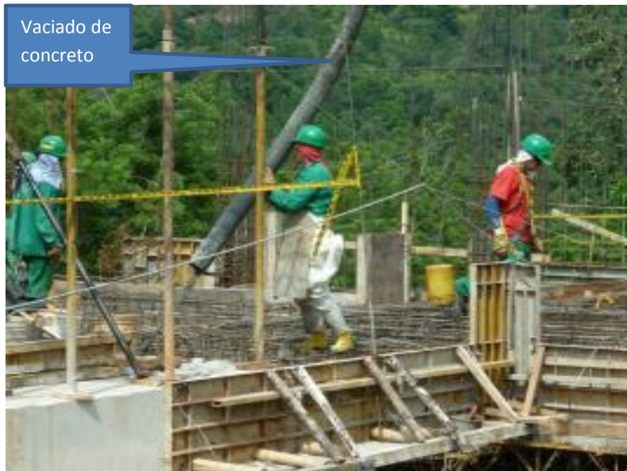
Imagen 199. Vaciado del concreto de la placa
