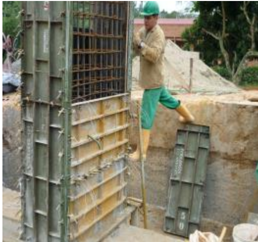
Imagen 134. Formaleta de columnas
