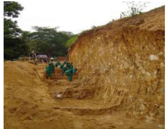
Imagen 22. Excavación manual de muro
