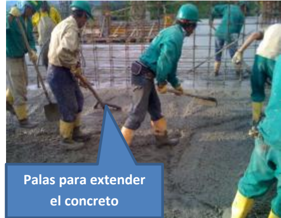
Imagen 210. Vaciado de losa del tercer piso
