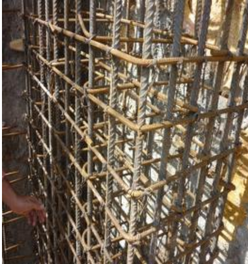
Imagen 130. Armado de las columnas del sótano
