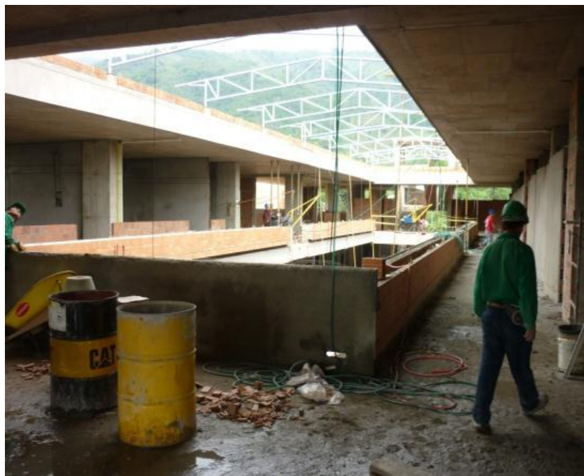
Imagen 231. Avance del quinto piso
