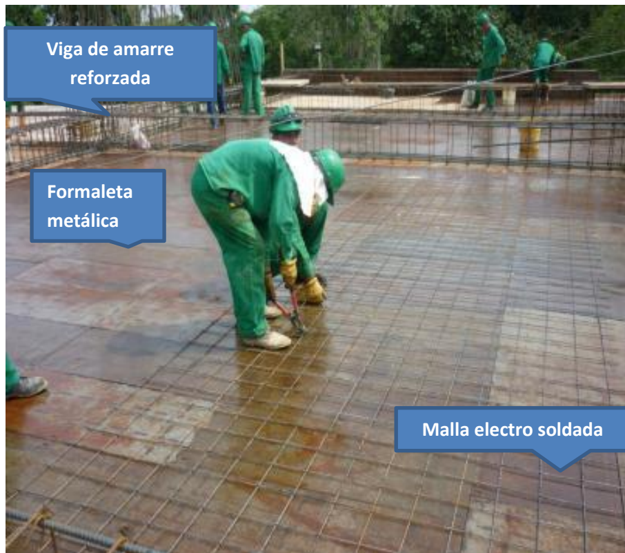
Imagen 191. Armado de la placa de entrepiso.
