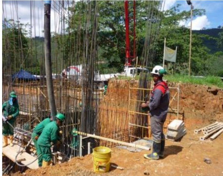
Imagen 136. Vaciado de columnas
