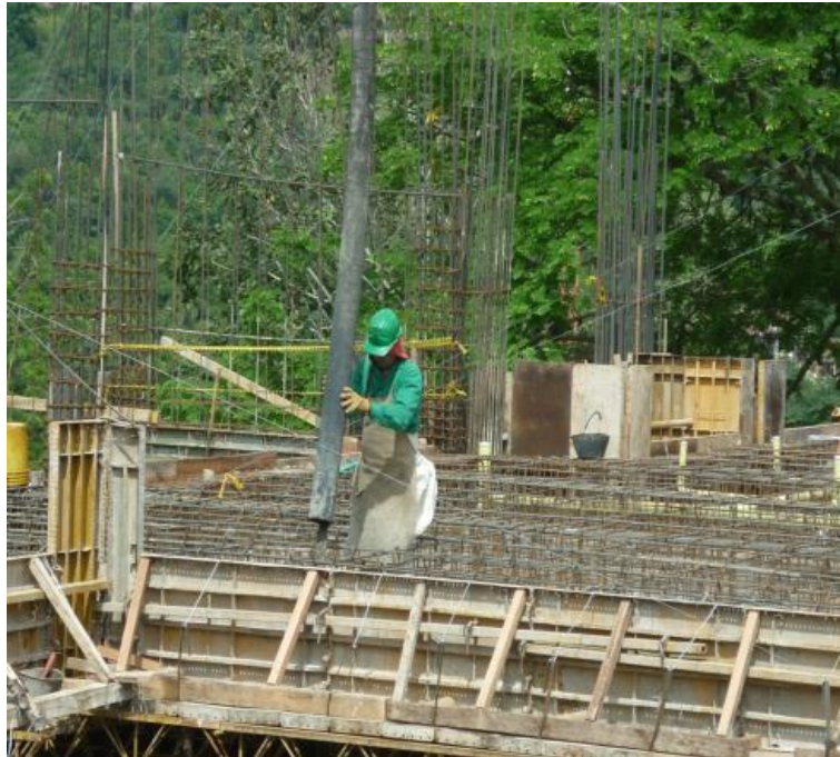
Imagen 224. Vaciado de la torta inferior
