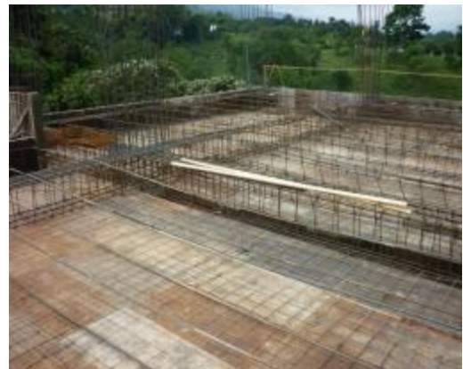
Imagen 28. Malla Electrosoldada en placa
