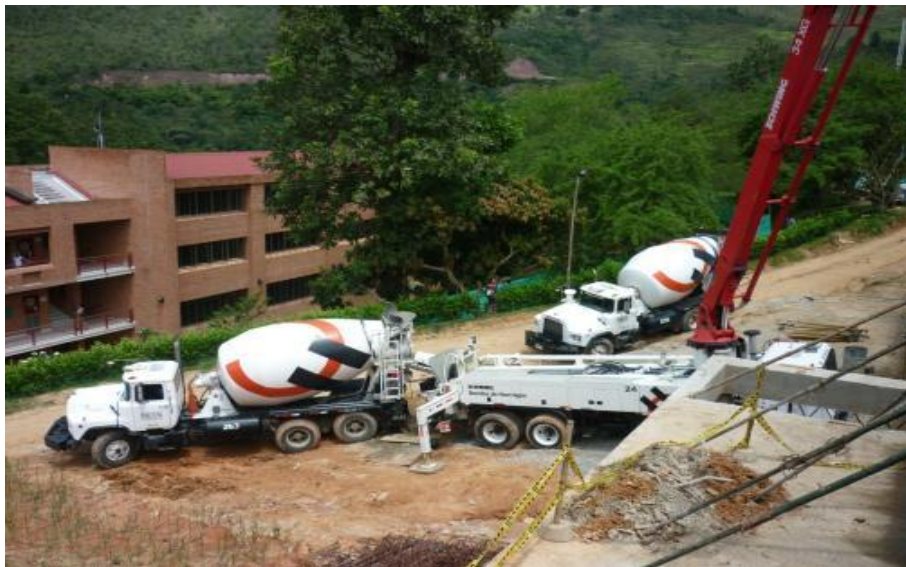
Imagen 171. Bombeo de concreto
