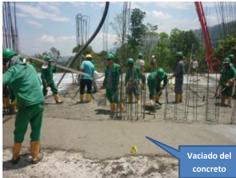
Imagen 228. Vaciado de losa de entrepiso
