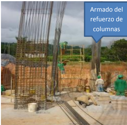
Imagen 156. Armado de refuerzo de columnas
