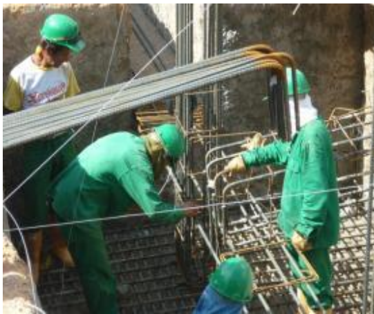
Imagen 106. Armado vigas de amarre
