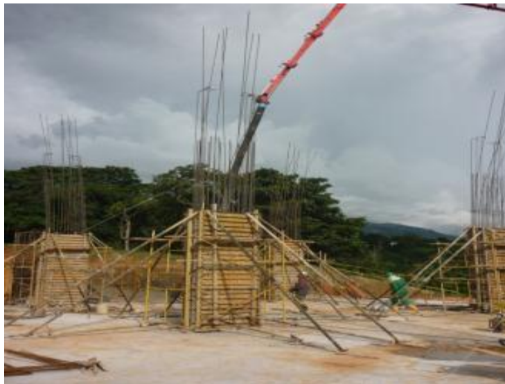
Imagen 36. Parales metálicos para sostener la formaleta de las columnas
