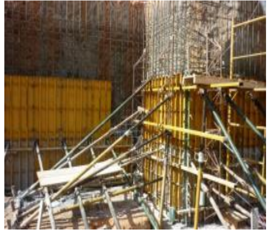
Imagen 123. Encofrado de pantallas
