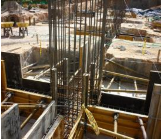
Imagen 108. Encofrado vigas de amarre
