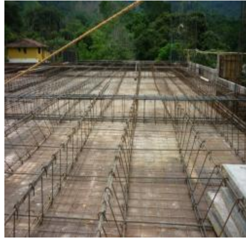
Imagen 43. Aceros de viguetas y vigas
