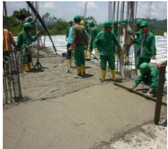
Imagen 183. Nivelación del concreto
