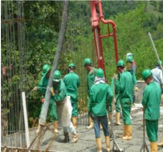
Imagen 169. Vaciado y nivelación de concreto
