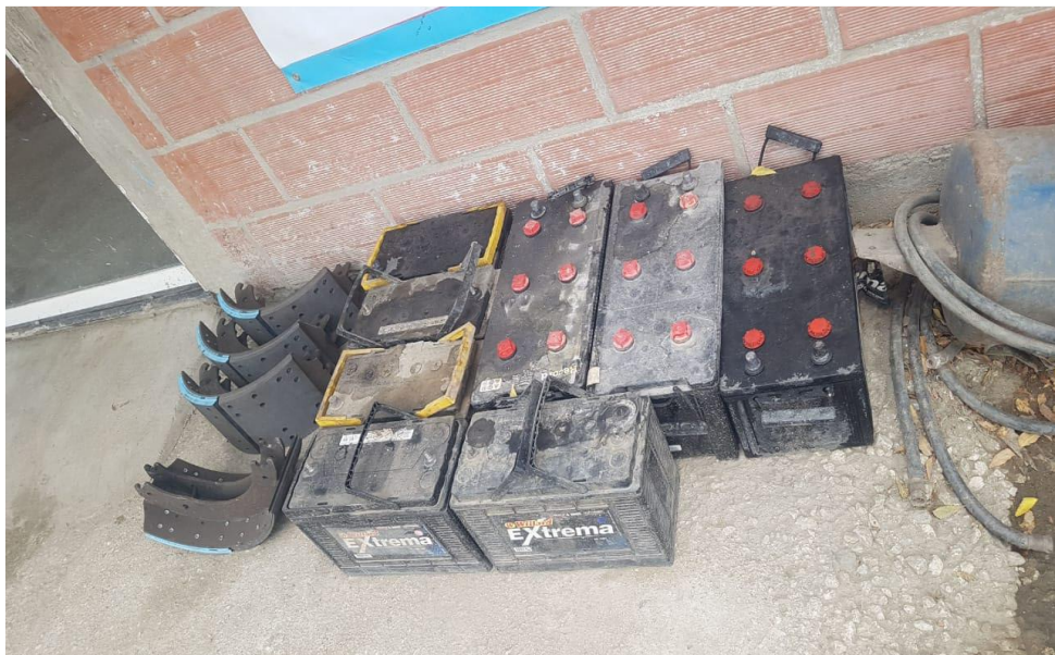
ILUSTRACIÓN 18 BATERÍAS 4D Y 30H
