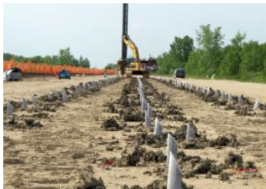
Figura 5. Instalación de drenes verticales
