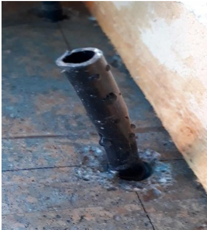
Foto 26. Drenes en ejecución
