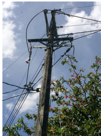
Figura 59. Poste en ángulo, cafetería primaria
