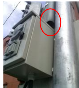
Figura 28. Bloque 11, adaptador en la entrada de cajas
