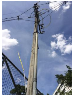
Figura 60. Poste aisladero, cancha de cemento bloque 6
