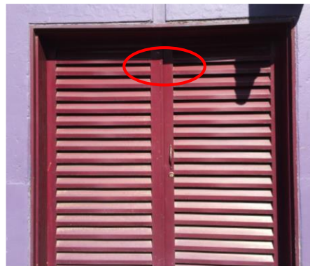
Figura 7. Bloque 12, marcación riesgo eléctrico
