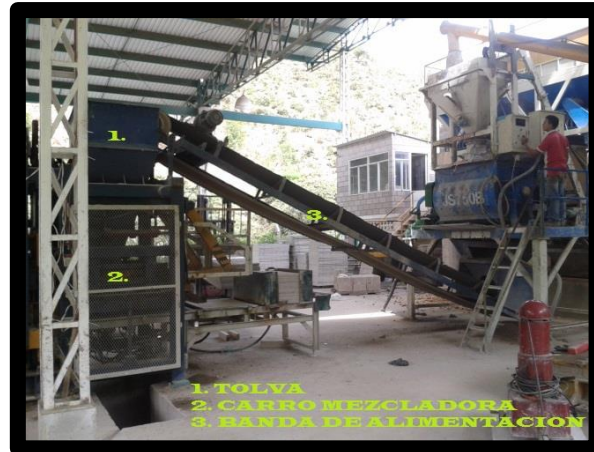
Figura 16: Proceso de dosificación de la maquinaria
