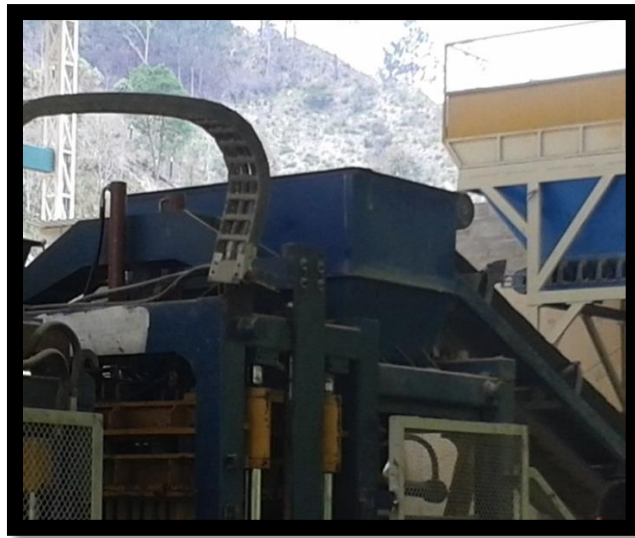
Figura 17: Alimentación de la tolva.
