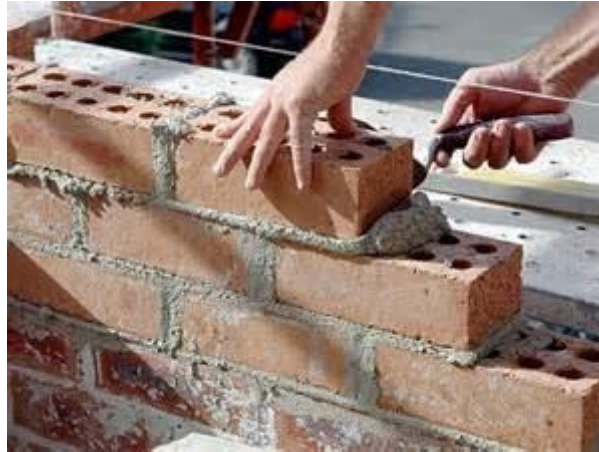
Figura 3: Mampostería no Estructural
