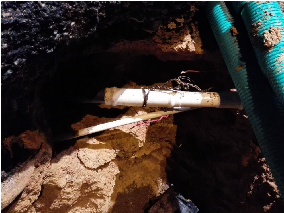
FIGURA 22 REPARACION DE LINEA DE AGUA POTABLE DAÑADA
