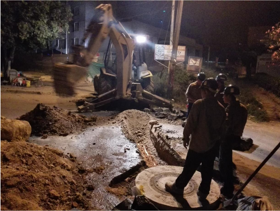
FIGURA 21 EXCAVACION SOBRE LA VIA.
