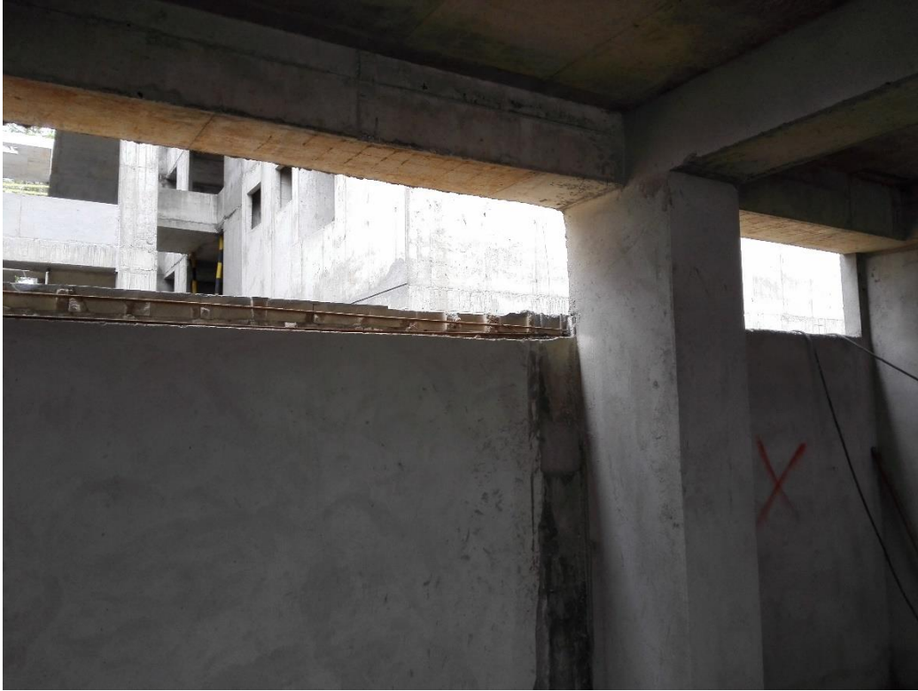
FIGURA 28. COLUMNTE FUNDIDA Y VIGA CINTA ARMADA
