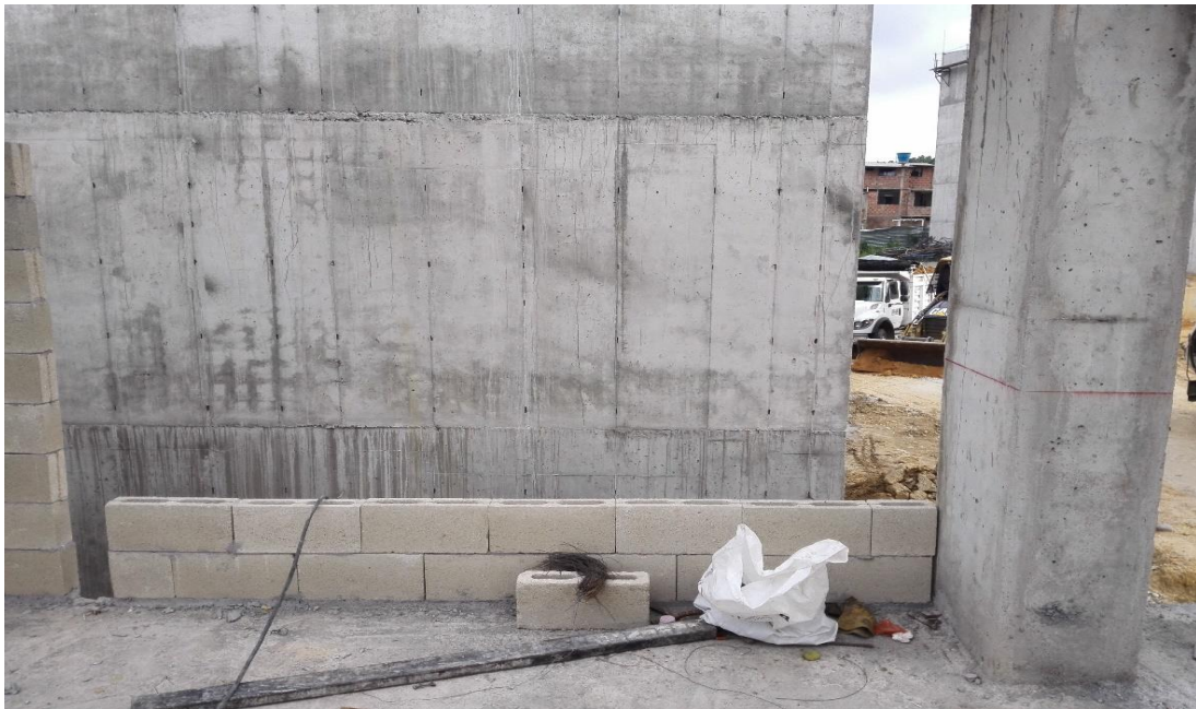
FIGURA 6. COLUMNAS DE CONFINAMIENTO PARA MAMPOSTERIA DEL PROYECTO CARACOLÍ MINUTO DE DIOS CONJUNTO CERRADO
