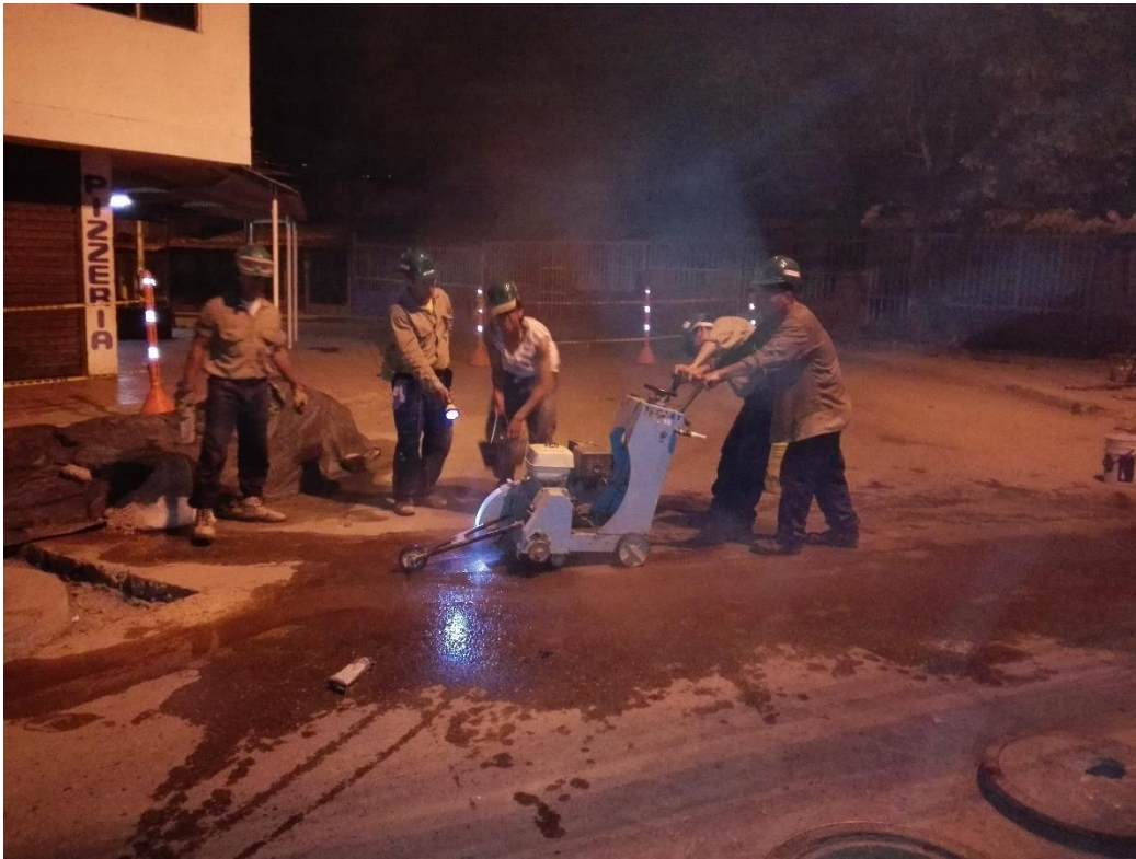
FIGURA 20 CORTE DEL PAVIMENTO SOBRE LA VÍA.
