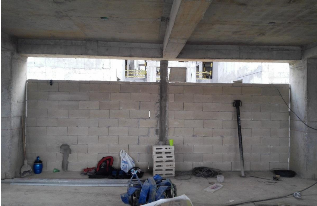
FIGURA 9 FIGURA 7, 8, 9. MAMPOSTERIA DEL SALON SOCIAL DEL PROYECTO CARACOLÍ MINUTO DE DIOS CONJUNTO CERRADO
