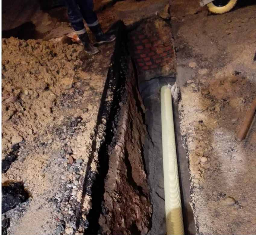
FIGURA 24. INSTALACION DE TUBERIA DIAMETRO 8"
