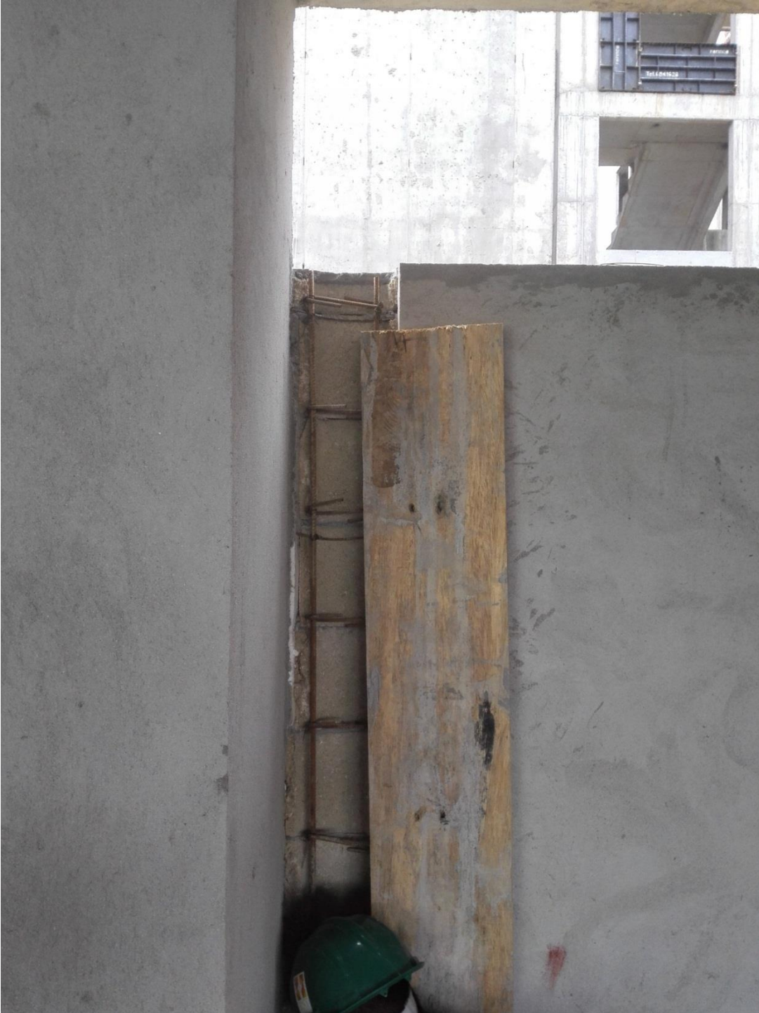
FIGURA 26. COLUMNETA MODIFICACIONES REALIZADAS AL DISEÑO DE LA MAMPOSTERIA.
