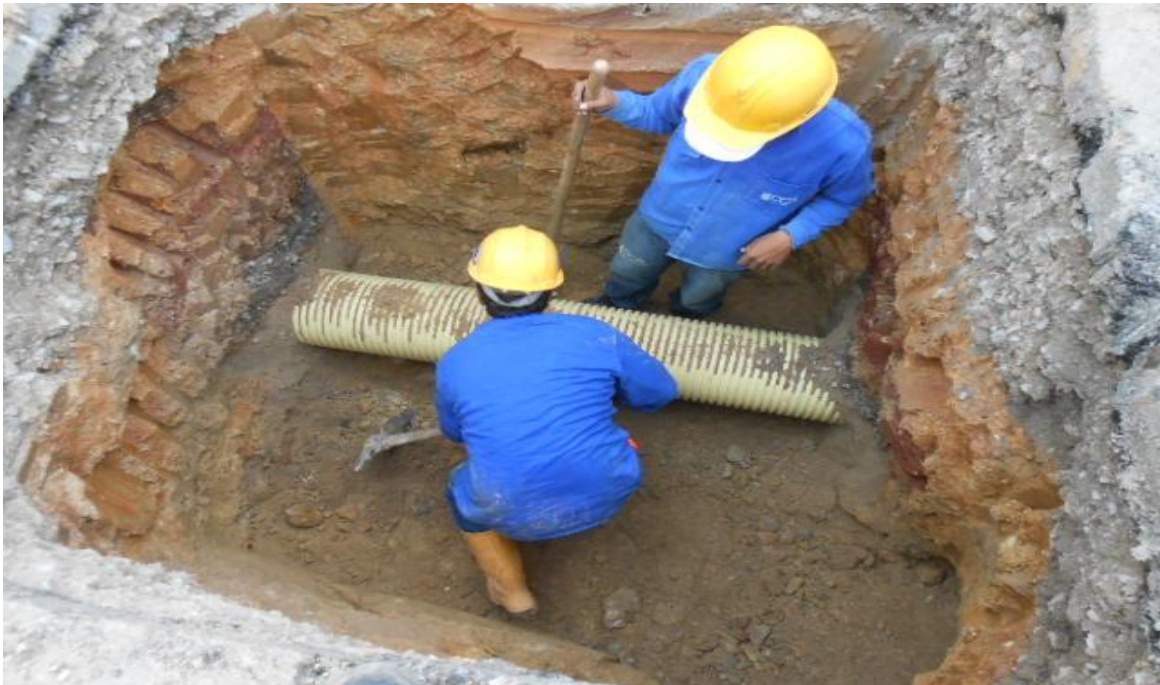
FIGURA 10. EXCAVACION PARA POZO DE AGUAS NEGRAS
