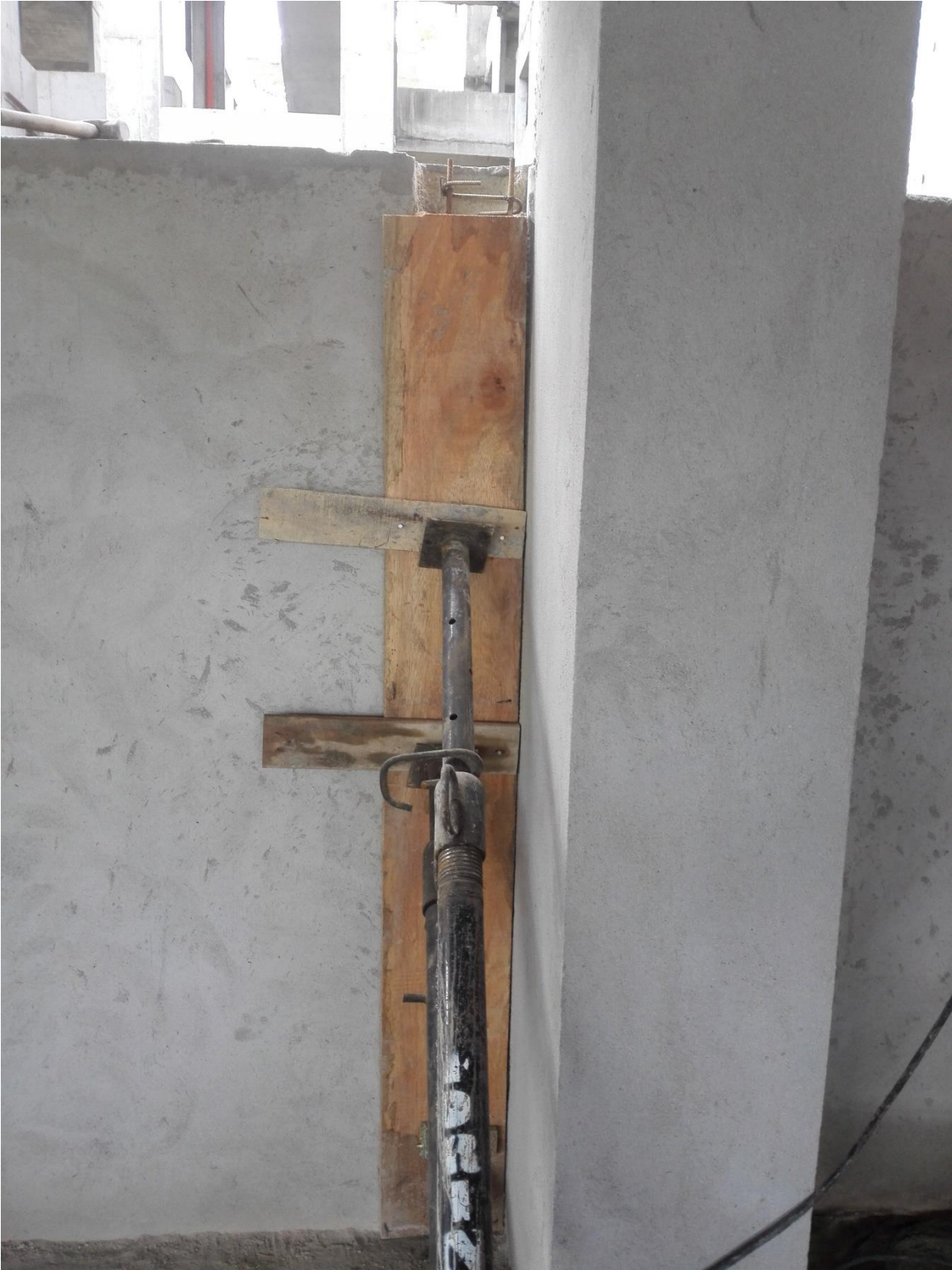
FIGURA 27. COLUMNETA LISTA PARA FUNDIR.
