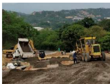
Ilustración 79. Motoniveladora, minicargador, ayudante y volqueta seriando parte inferior de la vía
