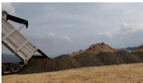
Ilustración 63. Acopio de base granular
