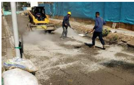
Ilustración 53. Ayudantes esparcen cemento en zonas susceptibles al agua
