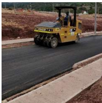
Ilustración 145. Compactador de llanta sobre carpeta asfáltica
