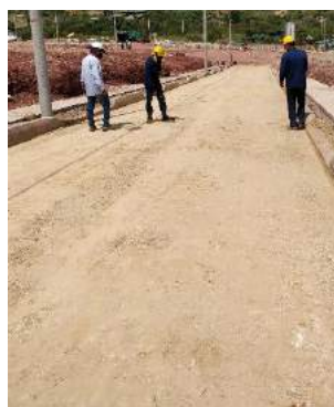
Ilustración 129. Inspector y ayudantes revisan la conformación de la sub-base granular
