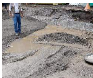
Ilustración 47. Fuertes lluvias ocasionaron desplazamiento de material granular y grandes charcos
