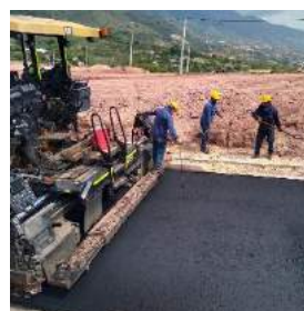
Ilustración 138. Tornillero revisando espesor de la carpeta asfáltica
