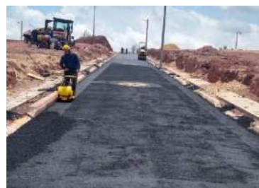
Ilustración 144. Operario compactando mezcla asfáltica en borde de vía
