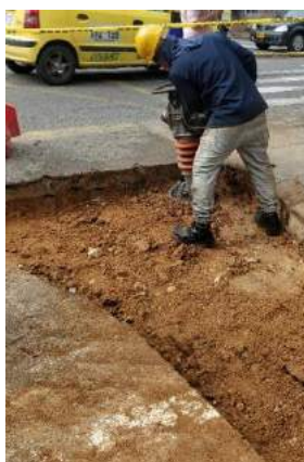
Ilustración 162. Ayudante compactando la subrasante con saltarín
