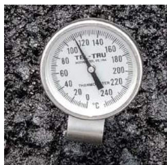
Ilustración 98. Monitoreo de la temperatura para inicio de compactación
