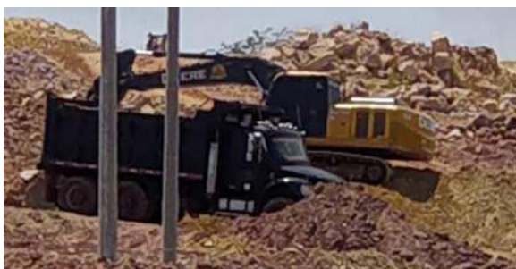
Ilustración 120. Retroexcavadora carga de sub-base granular a volqueta en sitio de acople
