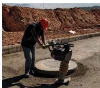
Ilustración 87. Ayudante compactando base granular alrededor de pozo
