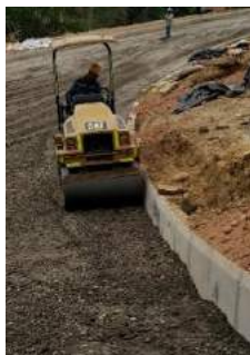
Ilustración 84. Vibro compactador tándem compactando bordes
