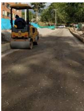
Ilustración 25. Compactación de la sub-base granular calzada sur
