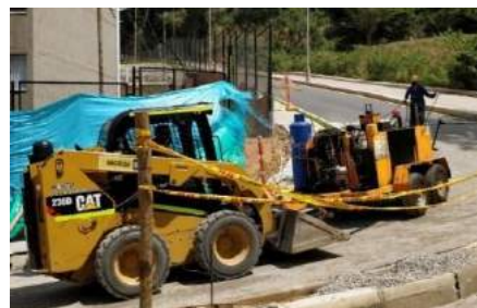
Ilustración 34. Minicargador ubica irrigador al inicio de la calzada norte
