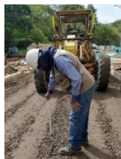
Ilustración 24. Seriado de la sub-base granular calzada sur
