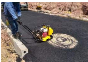
Ilustración 143. Operario compactando mezcla asfáltica alrededor de pozo con rana
