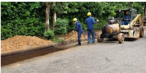
Ilustración 170. Operario de minicargador con marmita irrigadora y ayudantes realizando riego de imprimación.
