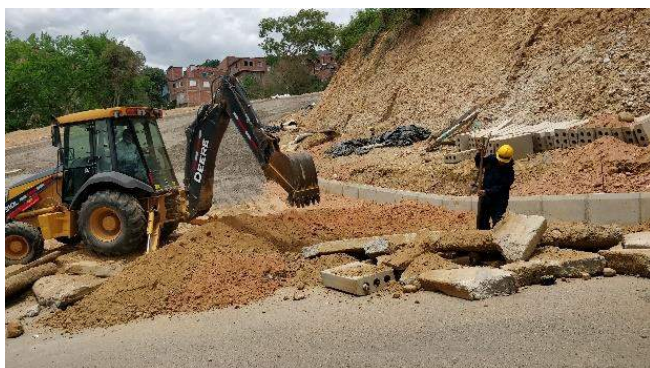
Ilustración 103. Retroexcavadora y ayudante retiran sardineles de la vía existente
