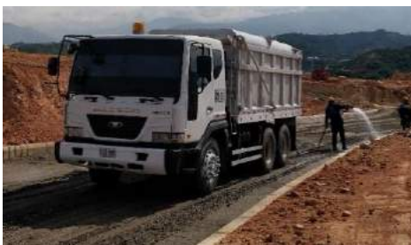
Ilustración 80. Operador mojando base granular para garantizar humedad óptima parte superior
