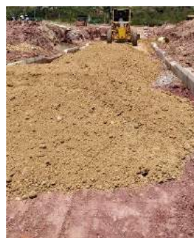
Ilustración 123. Sub-base granular apilada en calle
