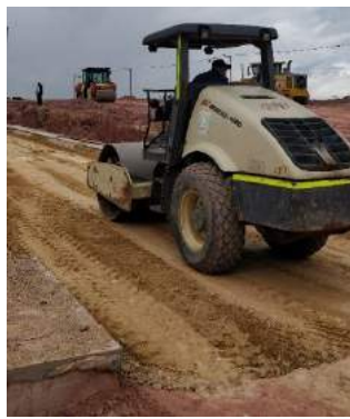
Ilustración 127. Vibrocompactador pisando la sub-base granular en calle
