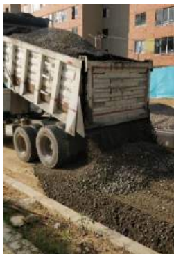
Ilustración 19. Vertimiento sub-base granular calzada sur
