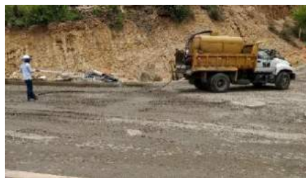
Ilustración 81. Operador mojando base granular para garantizar humedad óptima parte inferior
