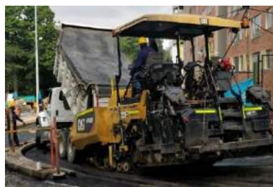
Ilustración 37. Volqueta vertiendo mezcla asfáltica a la tolva de la finisher
