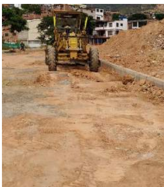
Ilustración 73. Motoniveladora seriendo subrasante
