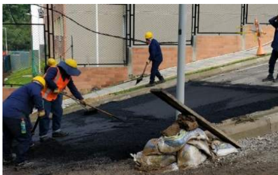
Ilustración 40. Ayudantes nivelando mezcla asfáltica en curva de acceso norte
