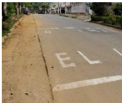
Ilustración 159. Zanjado antes de intervenir Carrera 23
