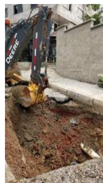
Ilustración 104. Retroexcavadora retirando estructura de pavimento para arreglo de tubería
