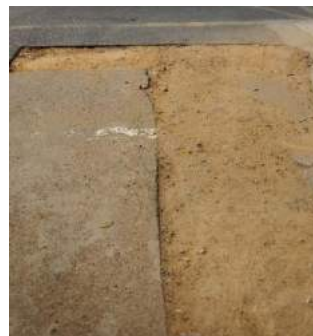
Ilustración 160. Zanjado antes de intervenir Calle 105
