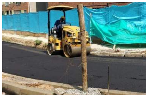
Ilustración 43. Compactación de la carpeta asfáltica
