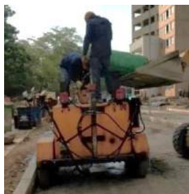
Ilustración 33. Operarios cargan emulsión en irrigador
