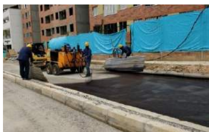
Ilustración 35. Operarios realizan la imprimación en vía calzada norte
