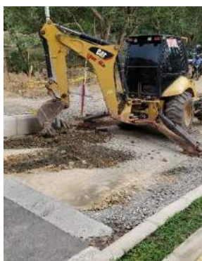
Ilustración 13. Excavación y retiro de material en curva acceso
