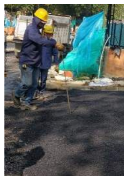
Ilustración 41. Tornillero midiendo espesor
