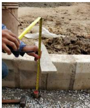
Ilustración 28. Ubicación de tacos en base granular
