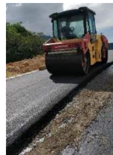
Ilustración 100. Vibro compactador tándem grande sobre carpeta asfáltica
