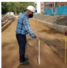
Ilustración 9. Seriado de la subrasante calzada sur
