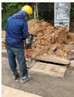
Ilustración 168. Ayudante compactando la base granular alrededor de tapa de sumidero
