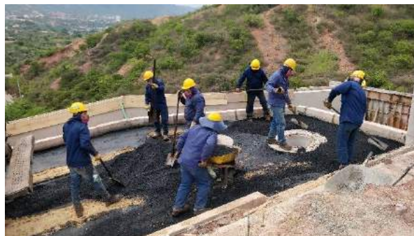
Ilustración 136. Ayudantes vierten mezcla asfáltica alrededor de pozo.
