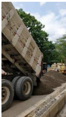
Ilustración 26. Volqueta vertiendo base granular en calzada sur
