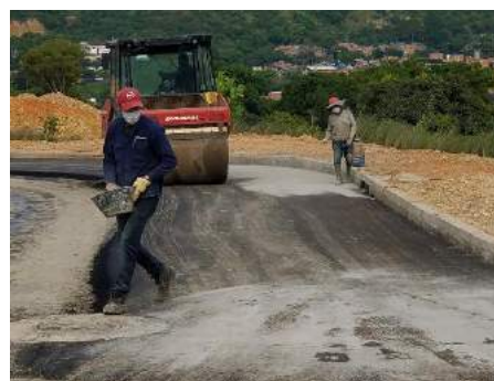
Ilustración 102. Ayudantes ventean cemento sobre carpeta asfáltica
