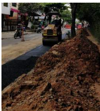
Ilustración 177. Vibrocompactador compactando la carpeta asfáltica
