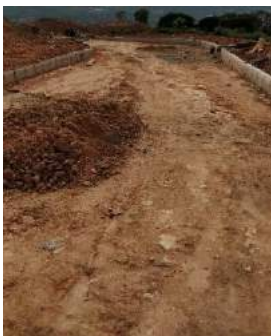
Ilustración 68. Vía antes de ser intervenida (tramo superior)
