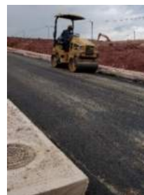
Ilustración 142. Vibrocompactador pisando borde de carpeta asfáltica
