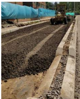
Ilustración 21. Motoniveladora seriando sub-base granular calzada norte
