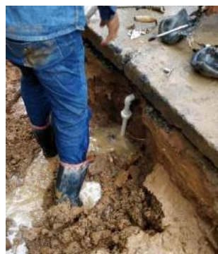
Ilustración 180. Trabajador del Acueducto Metropolitano de Bucaramanga (AMB) revisando el arreglo de la tubería
