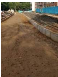
Ilustración 8. Calzada sur antes de ser intervenida
