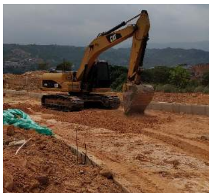
Ilustración 74. Retroexcavadora seriendo subrasante
