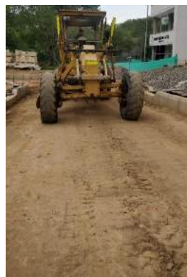
Ilustración 12. Subrasante conformada calzada sur
