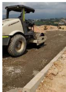
Ilustración 85. Compactación base granular después de humectada
