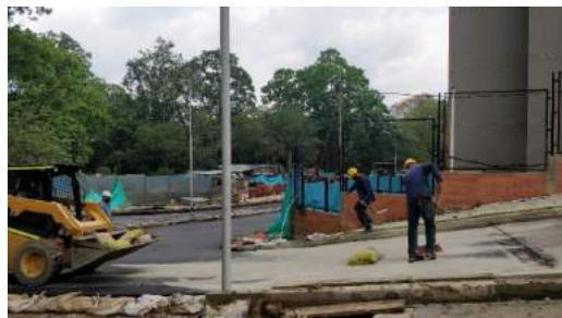
Ilustración 44. Ayudantes vierten cemento acceso calzada norte
