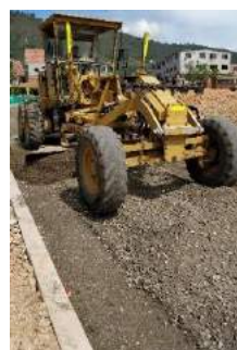
Ilustración 83. Motoniveladora seriando base granular
