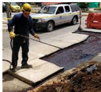
Ilustración 171. Ayudante realiza riego de imprimación
