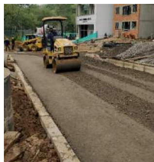
Ilustración 31. Compactación base granular calzada sur
