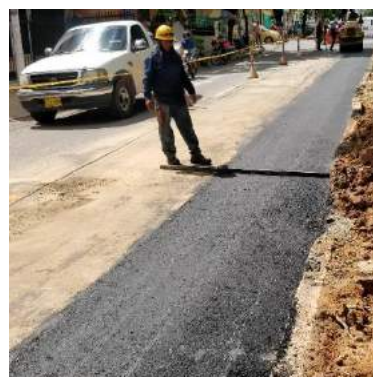
Ilustración 178. Ayudante verifica nivelación de la carpeta asfáltica
