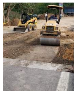
Ilustración 16. Compactación subrasante curva acceso
