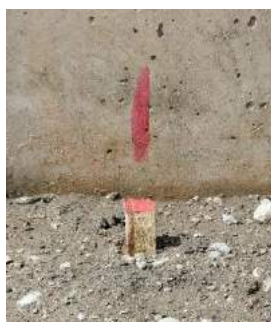
Ilustración 82. Taco ubicado en base granular
