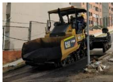
Ilustración 38. Vibroextendedora (finisher) iniciando en curva de acceso norte
