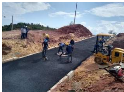
Ilustración 140. Ayudantes revisan el nivel de mezcla asfáltica alrededor de pozo.
