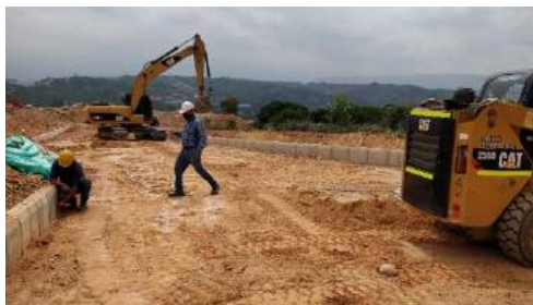
Ilustración 72. Seriado de la subrasante parte superior
