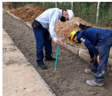
Ilustración 167. Inspector y ayudante revisando nivel de la base granular
