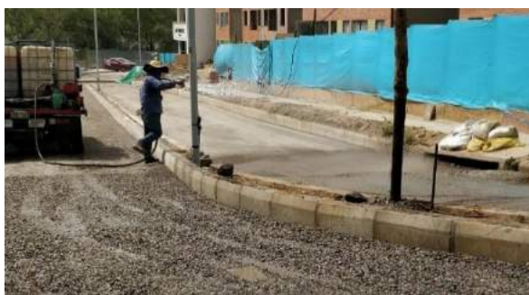
Ilustración 23. Carrotanque mojando sub-base granular
