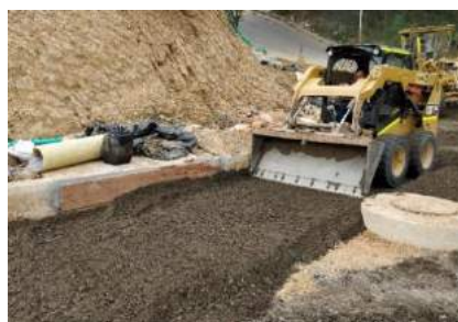
Ilustración 78. Minicargador seriando la base en lugar estrecho
