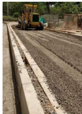
Ilustración 27. Motoniveladora nivelando base granular calzada sur
