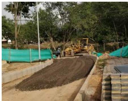
Ilustración 20. Esparcimiento de la sub-base granular calzada sur
