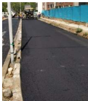
Ilustración 42. Finisher y ayudantes trabajan en calzada norte
