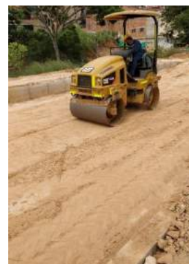
Ilustración 75. Compactación de la subrasante
