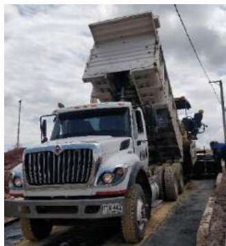
Ilustración 135. Volqueta vierte mezcla asfáltica en tolva de la finisher
