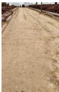
Ilustración 128. Sub-base granular conformada
