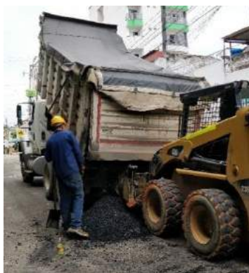
Ilustración 174. Volqueta vertiendo mezcla asfáltica en tolva del minicargador
