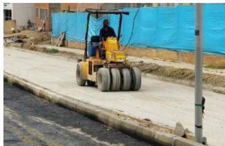
Ilustración 45. Compactador de llanta
