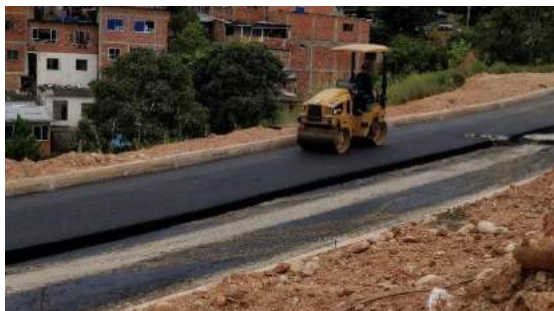
Ilustración 99. Vibro compactador tándem pequeño sobre bordes de carpeta asfáltica
