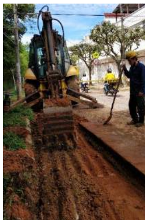
Ilustración 161. Retroexcavadora excavando la subrasante
