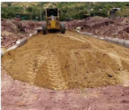
Ilustración 126. Motoniveladora extiende sub-base granular
