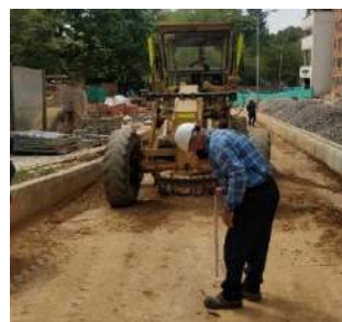
Ilustración 10. Seriado de la subrasante calzada sur
