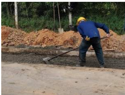
Ilustración 166. Ayudante extendiendo la base granular
