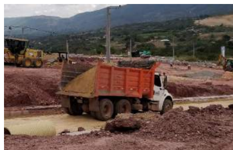
Ilustración 121. Volqueta transporta sub-base granular a calle
