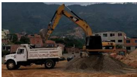
Ilustración 76. Retroexcavadora cargando base granular a volqueta
