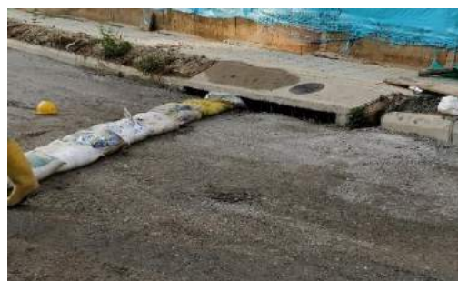
Ilustración 51. Sacos de arena ubicados a 45° del sumidero para encausar aguas
