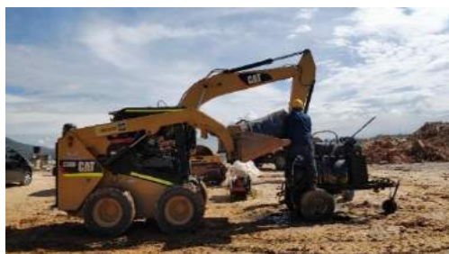
Ilustración 89. Operario del minicargador y ayudantes cargan la marmita (irrigadora de emulsión asfáltica)
