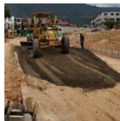
Ilustración 77. Motoniveladora nivelando base granular
