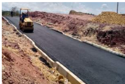
Ilustración 141. Vibrocompactador pisando carpeta asfáltica
