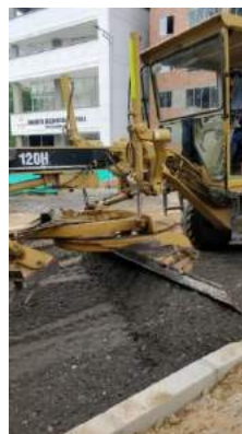
Ilustración 22. Motoniveladora nivelando sub-base granular calzada sur
