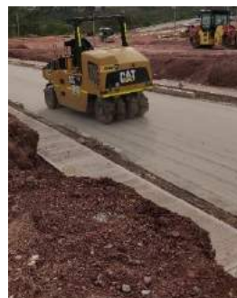
Ilustración 146. Compactador de llanta sobre carpeta asfáltica venteada con cemento
