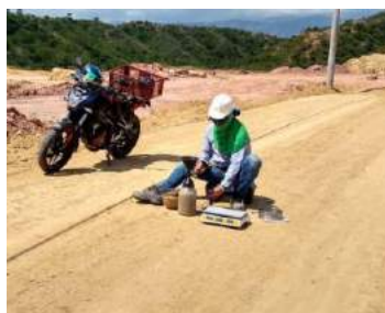
Ilustración 148. Toma de muestra para ensayo de cono y arena
