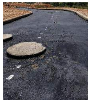
Ilustración 94. Demarcación de la mitad de la calzada
