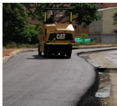
Ilustración 101. Compactador de llanta sobre carpeta asfáltica
