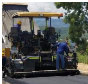
Ilustración 96. Tornillero midiendo espesor de la carpeta asfáltica
