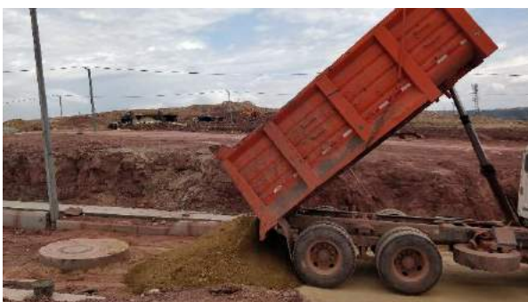
Ilustración 122. Volqueta vierte sub-base granular en parte superior de calle
