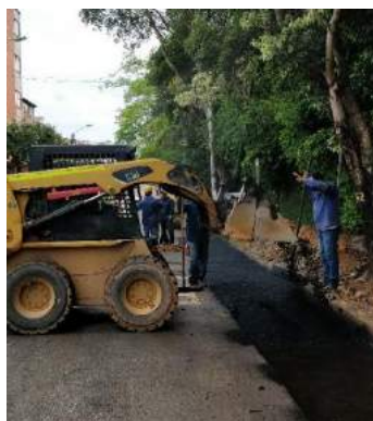
Ilustración 175. Operario del minicargador vertiendo mezcla asfáltica en zanjado
