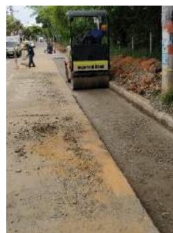
Ilustración 169. Vibrocompactador compactando la base granular
