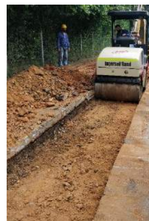
Ilustración 163. Vibrocompactador pisando la subrasante
