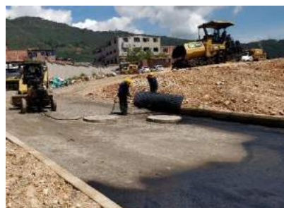
Ilustración 90. Imprimación parte superior de la vía
