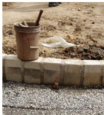
Ilustración 29. Taco ubicado en base granular
