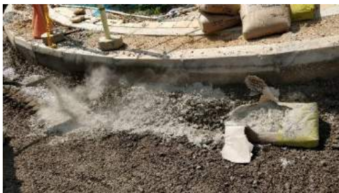
Ilustración 52. Aplicación de cemento en curva de acceso
