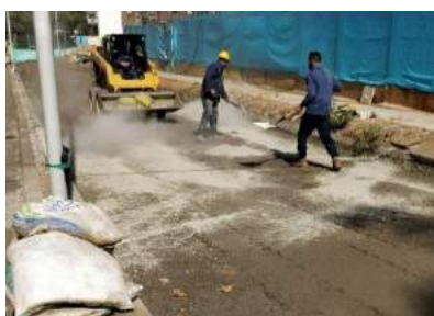
Ilustración 32. Ayudantes esparcen cemento por la base granular
