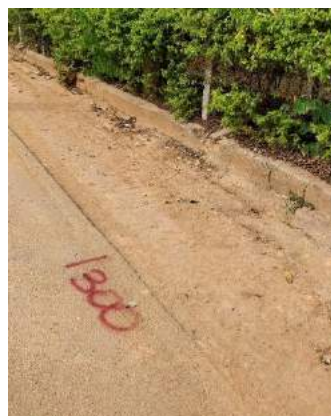
Ilustración 155. Zanja en carrera 23 abscisa 1300
