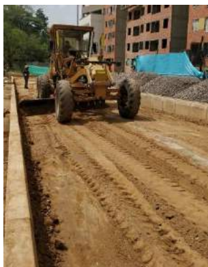
Ilustración 11. Motoniveladora nivelando la subrasante calzada sur
