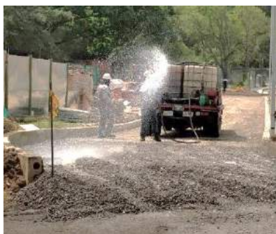
Ilustración 30. Operador mojando base granular para garantizar humedad óptima
