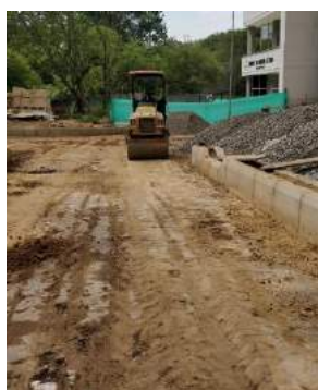
Ilustración 15. Inicio de compactación de subrasante calzada sur
