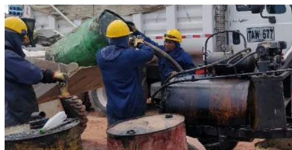
Ilustración 131. Ayudantes cargan emulsión en la marmita irrigadora
