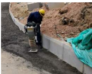
Ilustración 86. Ayudante compactando base granular con saltarín en esquina
