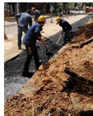
Ilustración 176. Ayudantes extienden la mezcla asfáltica.
