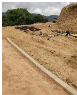
Ilustración 69. Vía antes de ser intervenida (tramo medio)
