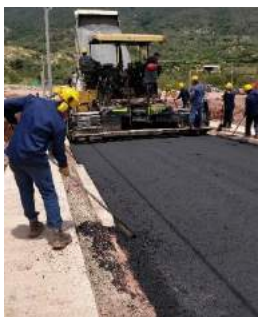
Ilustración 139. Rastrillero arreglando borde de la carpeta asfáltica
