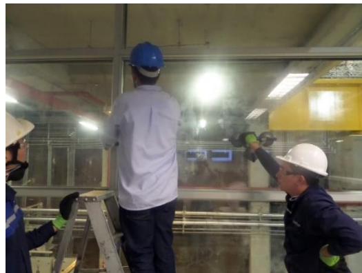
Ilustración 23 Garantías a Ventanería Instalada
