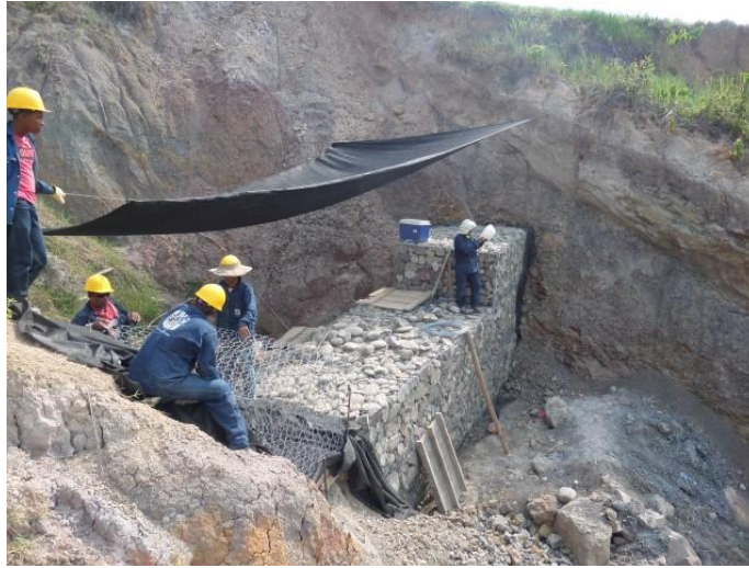
Ilustración 8 Construcción Muros en Gaviones
