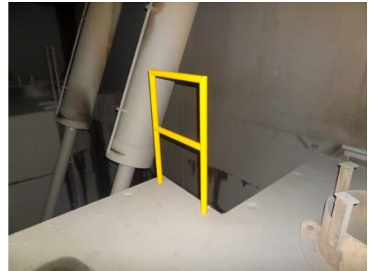
Ilustración 21 Reinstalación de Elementos Metálicos
