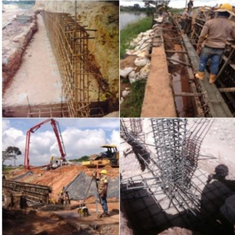
Figura 17. Armada del acero y fundida del concreto Fuente. Elaborada por el autor
