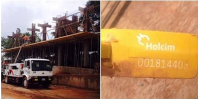
Figura 18. Verificación del sello de la mixer Fuente. Elaborada por el autor
