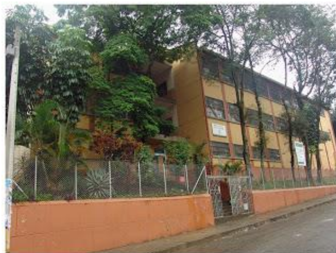
Figura No. : Fallada de la Institución Educativa Ana de Castrillón sede Divino Salvador. Fuente:
