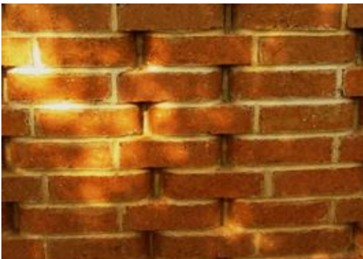
ILUSTRACIÓN 67: MURO EN BLOQUE DE TIERRA
