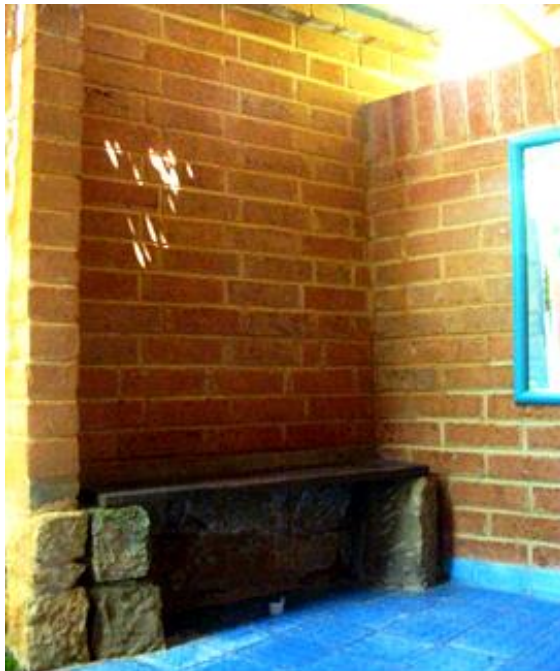
ILUSTRACIÓN 68: MUROS EN BLOQUES DE TIERRA COMPRIMIDOS
