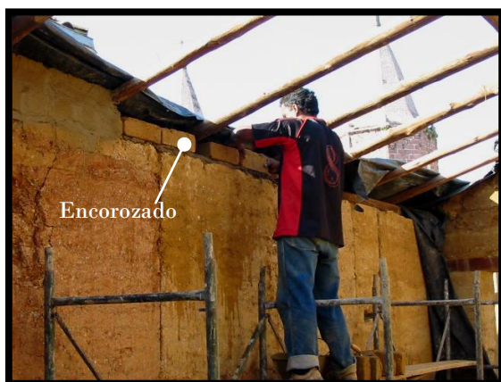
ILUSTRACIÓN 19: ENCOROZADO
