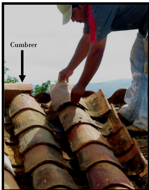
ILUSTRACIÓN 34: CUMBRERA EN LA CUBIERTA
