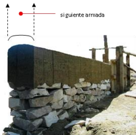
ILUSTRACIÓN 15: CONFINAMIENTO ENTRE ARMADAS
