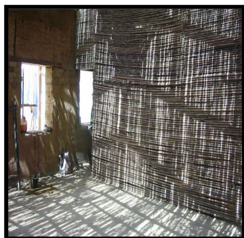
ILUSTRACIÓN 72: MUROS EN BAHAREQUE
