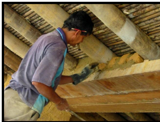
ILUSTRACIÓN 19: ENCOROZADO
