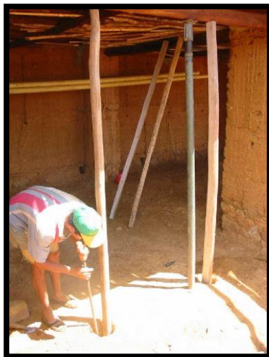
ILUSTRACIÓN 71: PROCESO DE CONSTRUCCION BAHAREQUE
