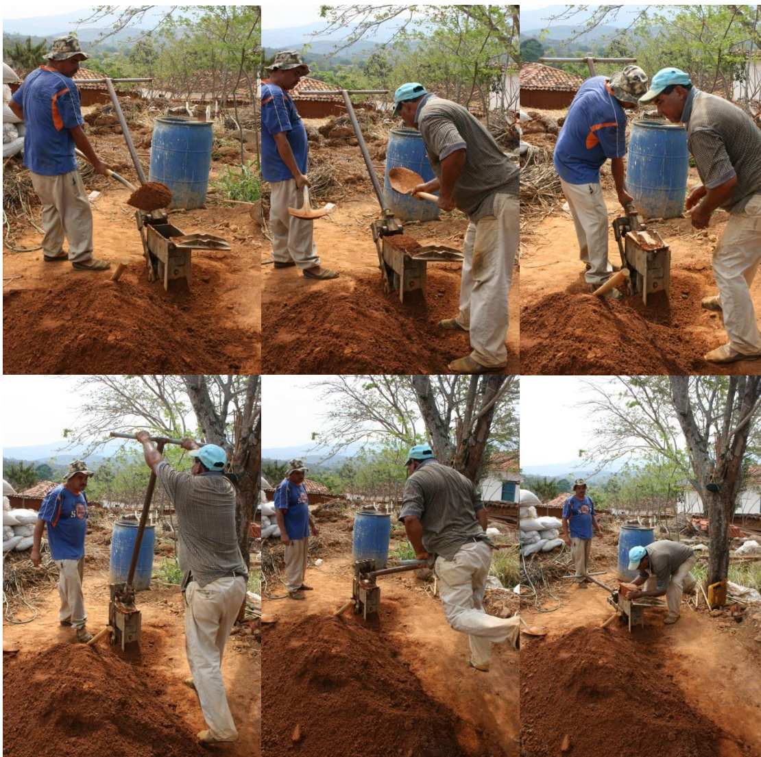
ILUSTRACIÓN 65: PROCESO DE CONSTRUCCION DE BTC
