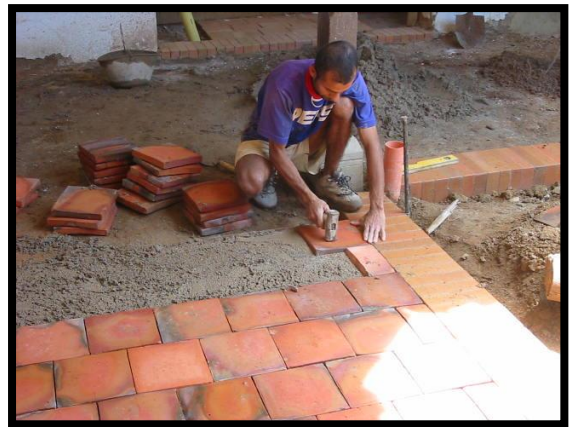
ILUSTRACIÓN 46: INSTALACIÓN DEL TABLÓN
