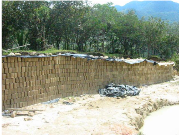
ILUSTRACIÓN 61: SECADO DEL ADOBE
