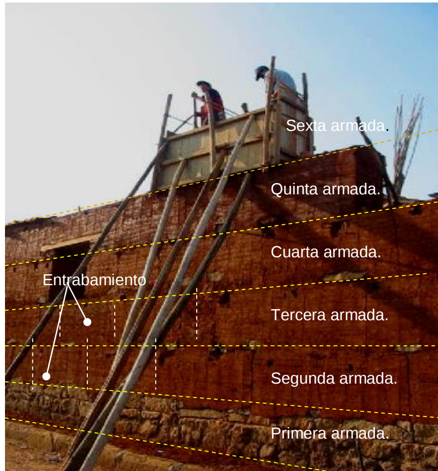
ILUSTRACIÓN 12: ARMADAS EN EL MURO DE TAPIA
