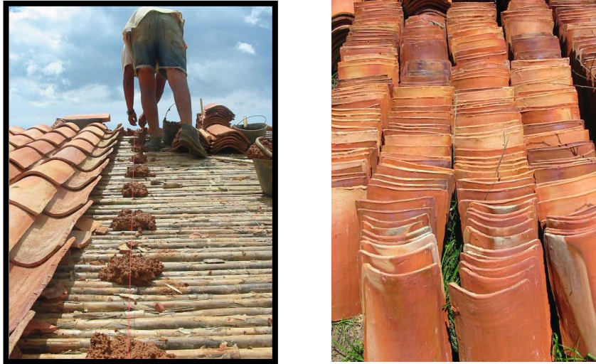
ILUSTRACIÓN 31: ORGANIZACIÓN DE LAS TEJAS ANTES DE COLOCARLAS
