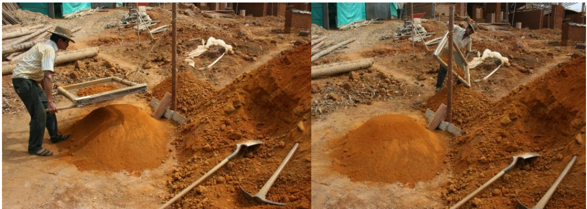
ILUSTRACIÓN 64: TAMIZADO DE LA TIERRA PARA BTC
