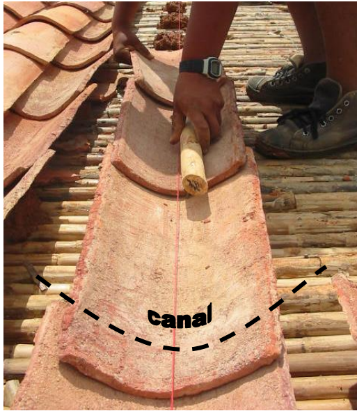
ILUSTRACIÓN 32: CANAL Y ROBLÓN EN LAS TEJAS DE BARRO
