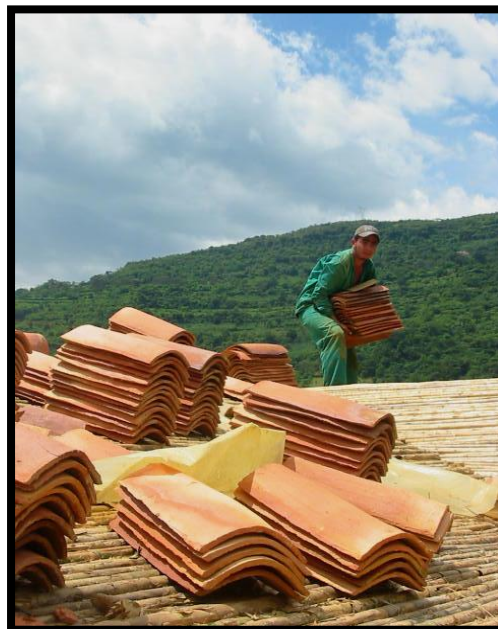
ILUSTRACIÓN 34: CUMBRERA EN LA CUBIERTA
