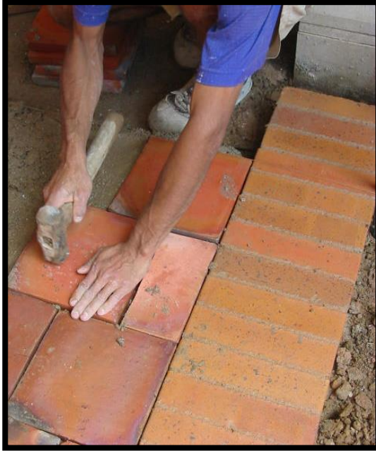
ILUSTRACIÓN 46: INSTALACIÓN DEL TABLÓN
