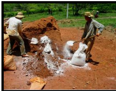
ILUSTRACIÓN 11: MEZCLA CON CAL
