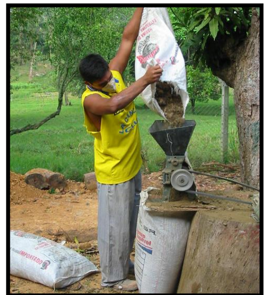
ILUSTRACIÓN 40: PREPARACIÓN DEL PAÑETE
