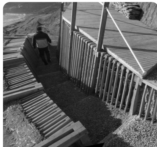
INSTALACIONES Y ESTRUCTURAS VICHUQUÉN, CHILE
