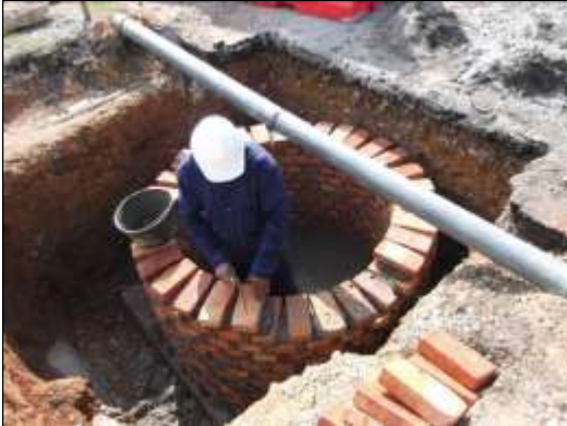
Construcción de cilindro en mampostería Pozo de inspección
