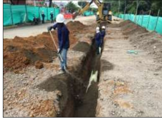
Recubrimiento de tubería con material granular (arena) alcantarillado
