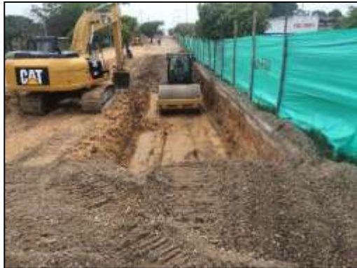
Retiro de fallos de subrasante
