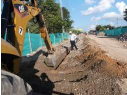
Excavación para instalación de banco de ductos media tensión.
