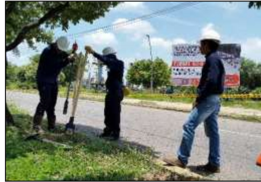
Apiques para instalación de madera rolliza (cerramiento)
