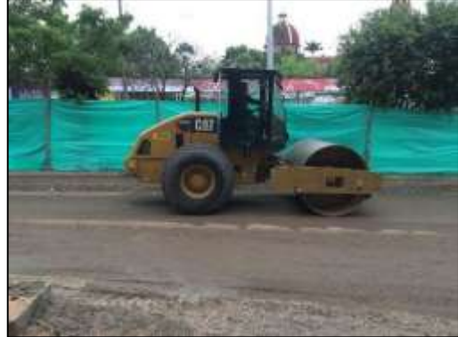
Compactación de Subbase granular
