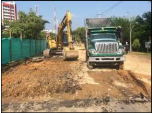
Demolición de calzada y retiro de Escombros-material sobrante
