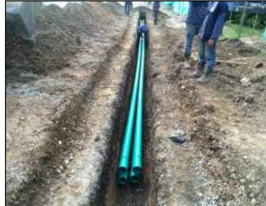
Instalación de banco ductos de 4" PVC DB para red de telecomunicaciones
