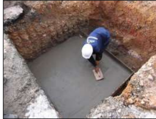
Placa de piso en concreto reforzado
