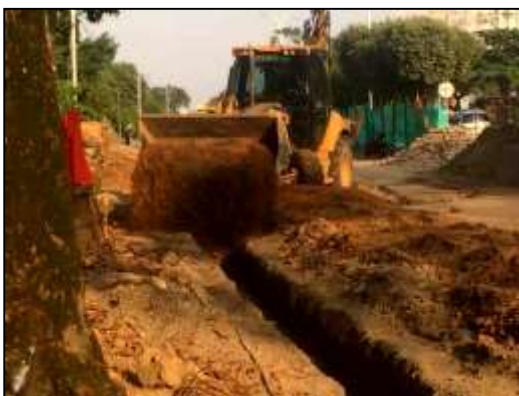
Figura 23. Registro Fotográfico de Actividades Construcción Subdrenaje Filtro Francés.
