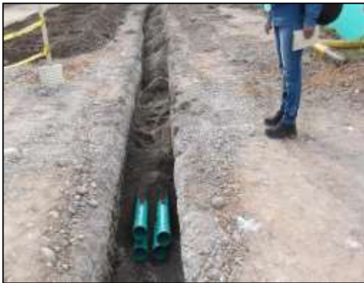
Recubrimiento en arena para red de telecomunicaciones
