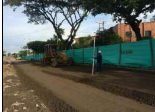
Instalación de base estabilizada con cemento
