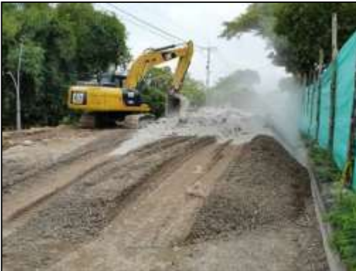
Preparación In Situ de base estabilizada Con cemento
