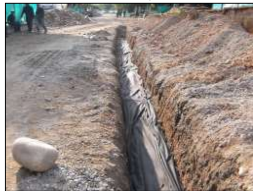
Recubrimiento de filtro con geotextil
