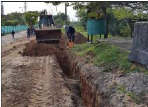
Instalación de cama de arena
