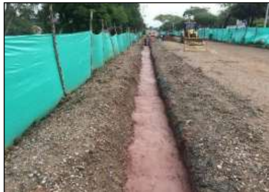
Concreto mineral de banco ductos de media tensión.
