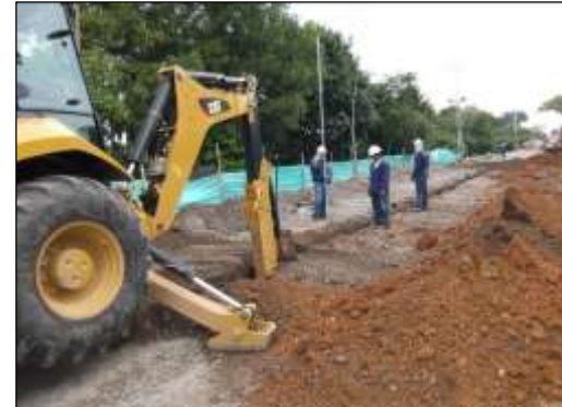
Excavación para instalación de Tubería PCV 12" red de alcantarillado pluvial
