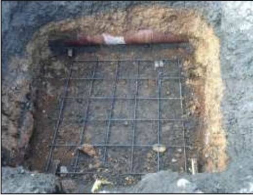
Refuerzo de placa de piso para pozo
