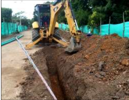
Excavación para instalación de banco de ductos de telecomunicaciones
