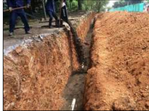
Instalación de recubrimiento en arena para red de Acueducto
