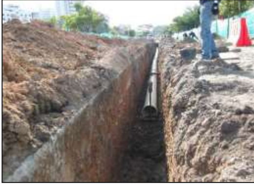
Instalación de Tubería PCV 12" red de pluvial
