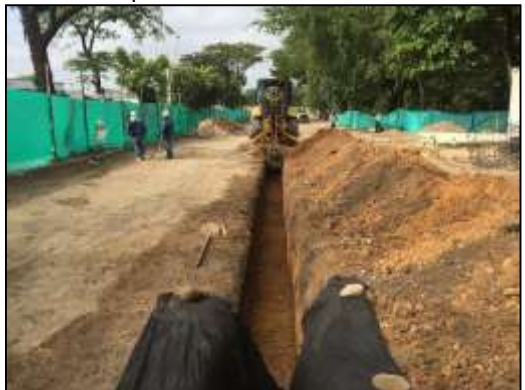
Figura 22. Registro Fotográfico de Actividades Caja de Inspección y Subdrenaje Francés para Pavimentos.
