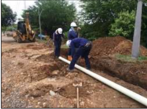
Instalación de tubería PVC 4" red de Acueducto
