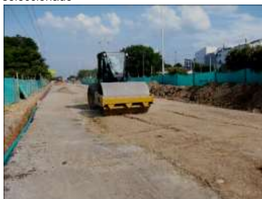
Figura 23. Registro Fotográfico de Actividades Construcción Subdrenaje Filtro Francés.
