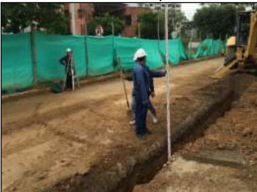
Figura 22. Registro Fotográfico de Actividades Caja de Inspección y Subdrenaje Francés para Pavimentos.
