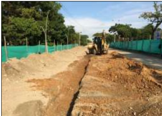
Relleno de zanja con material comun seleccionado
