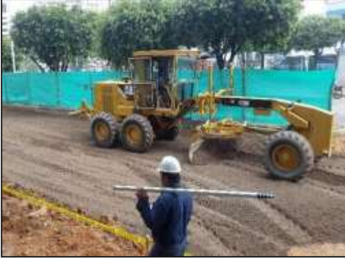
Nivelación de Subbase granular
