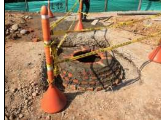
Excavación para filtro
