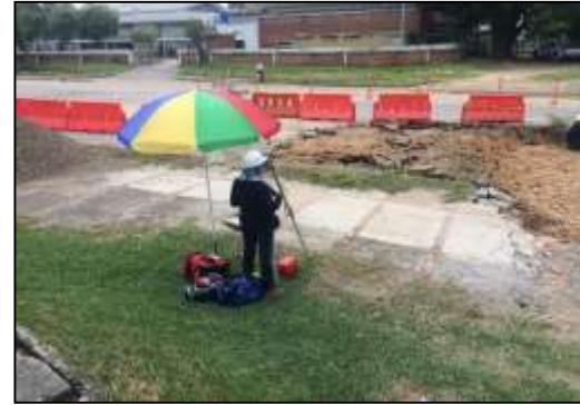
Localización y replanteo
