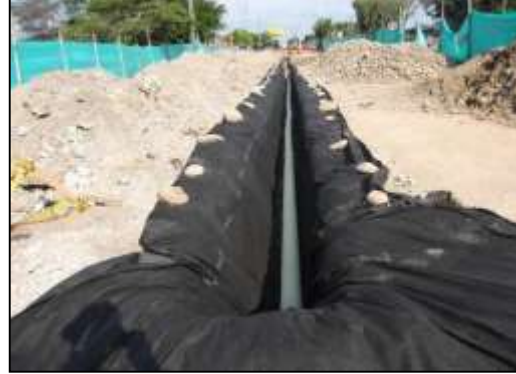
Recubrimiento de filtro con geotextil
