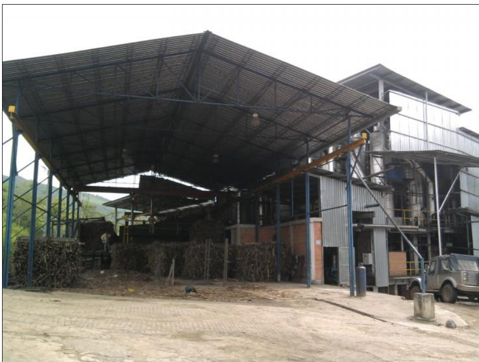
Foto 3. Vista de Puente Grúa y Zona de Evaporación (P.E)
