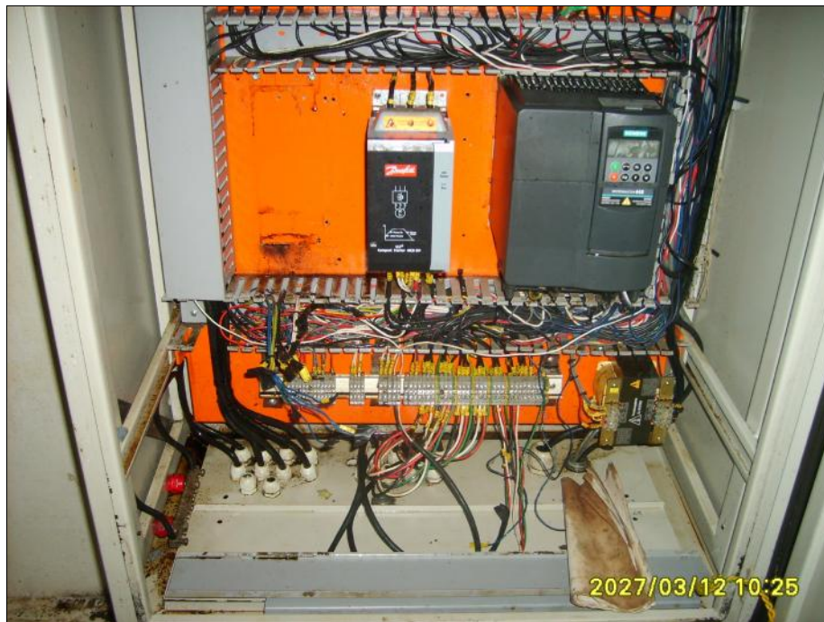
Foto 19. Vista Tablero Área Blanca Antes del Mantenimiento (P.E)
