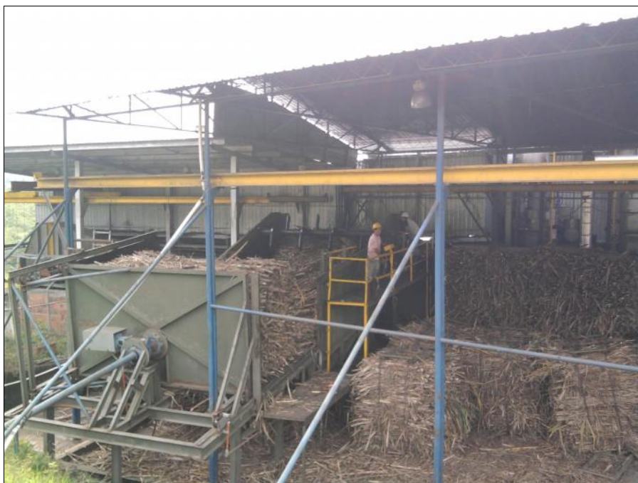
Foto 2. Vista de Punto Grúa y Mesa de Caña (Planta de Elaboración)
