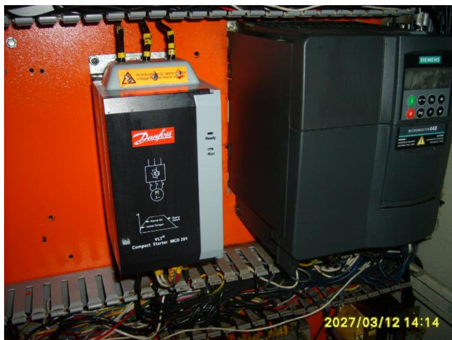
Foto 22. Vista Tablero Área Blanca Después del Mantenimiento (P.E)
