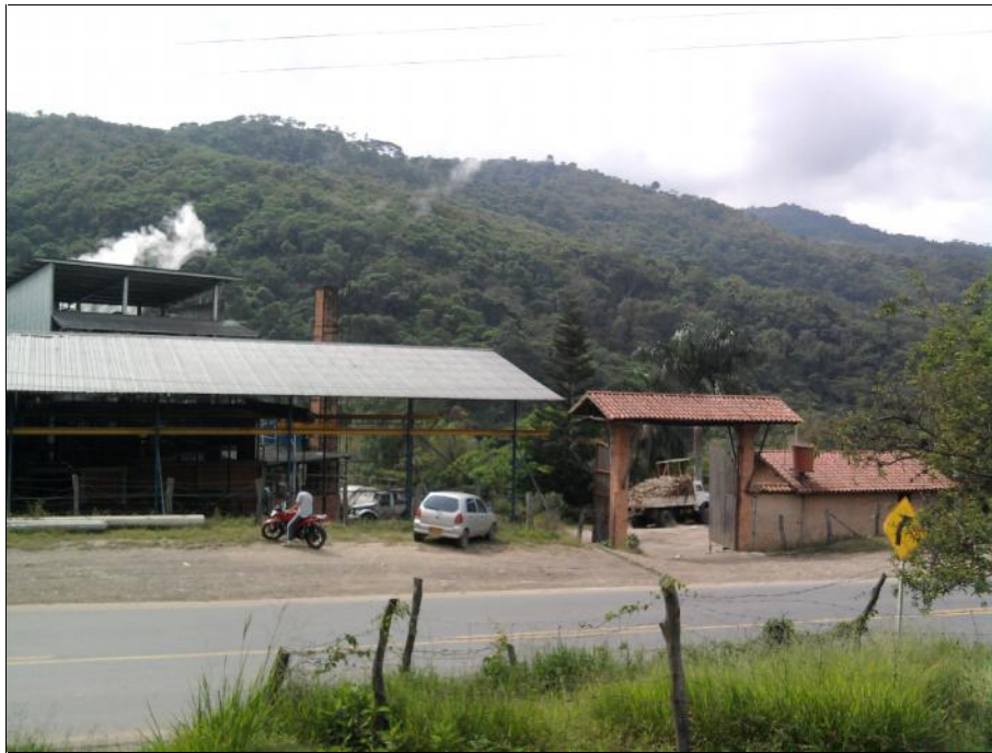
Foto 1. Vista Exterior Zona Oeste (Planta de Elaboración)
