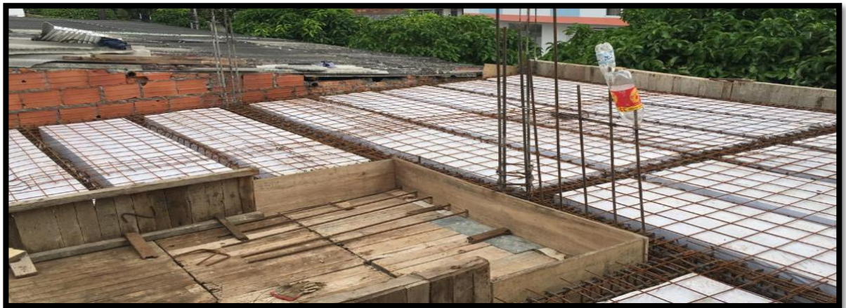
Imagen 59 Placa segundo piso lista para fundir
