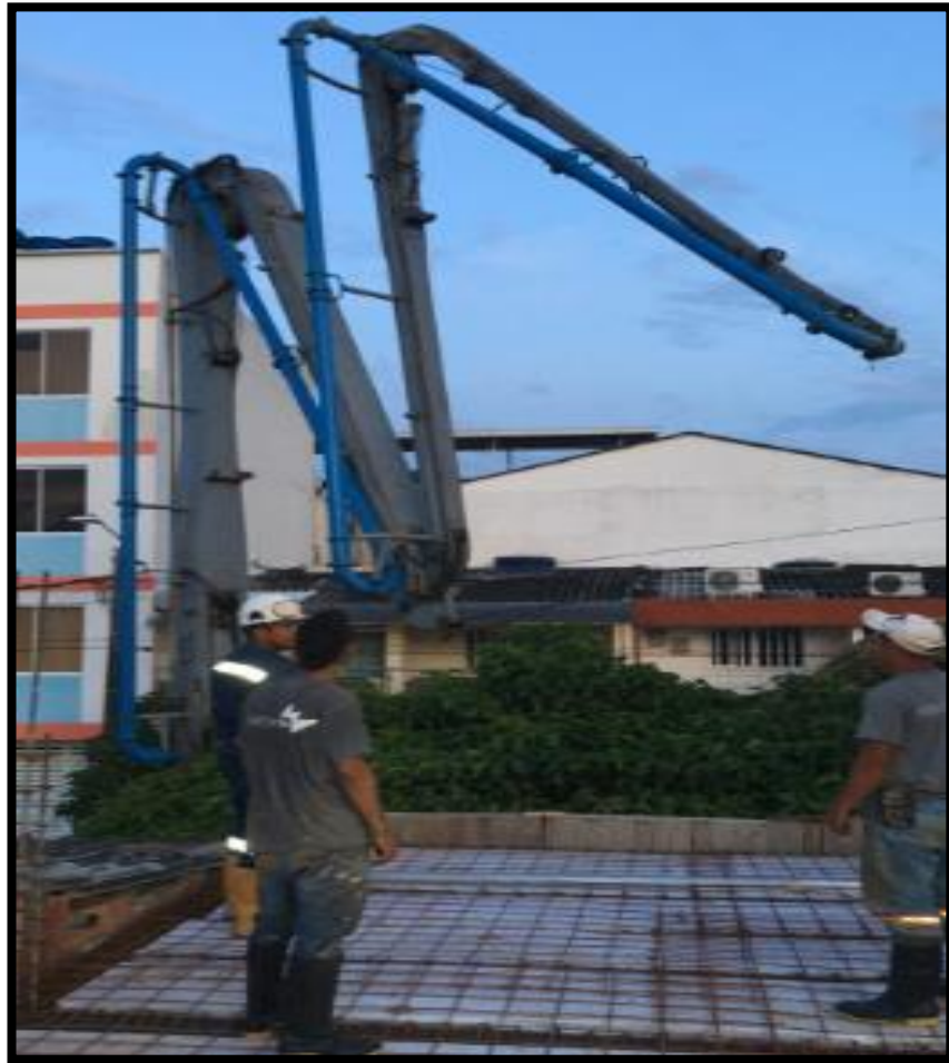
Imagen 60 Auto bomba para vaciar concreto
