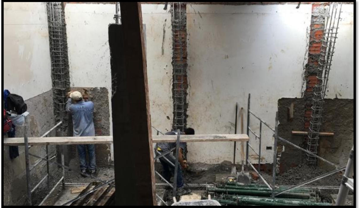
Imagen 57 Demolicion columnas
