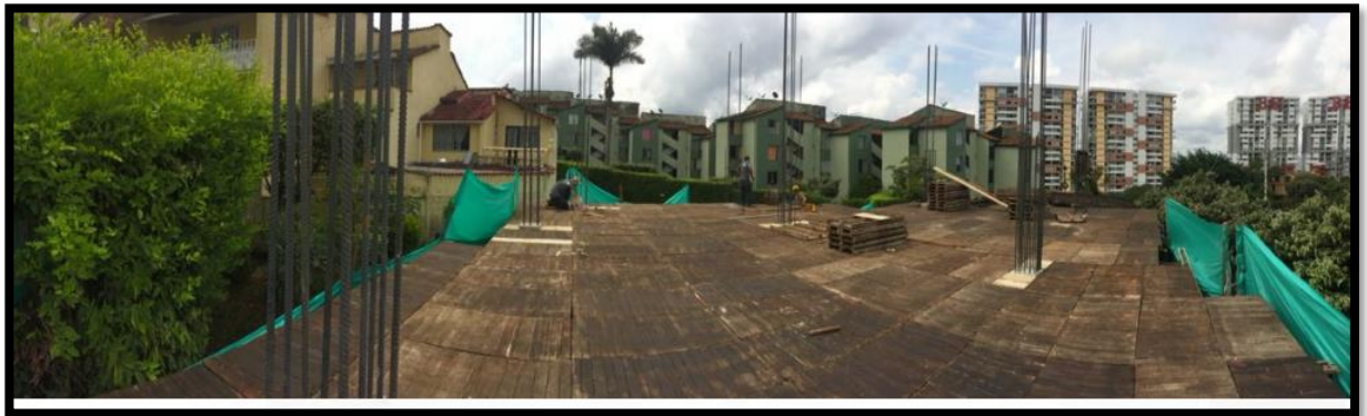
Imagen 22 Armado tarima de placa segundo piso.
