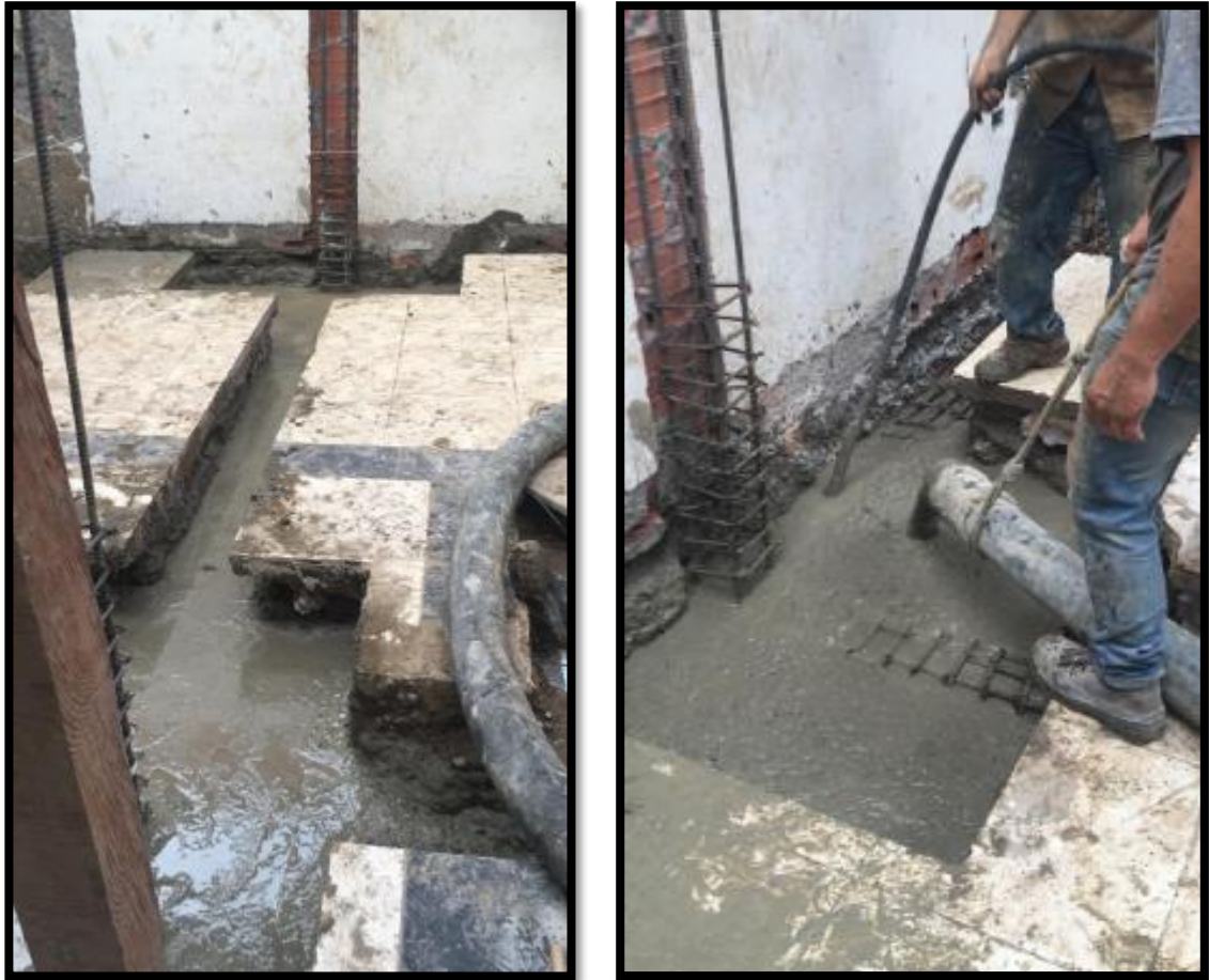
Imagen 54 Fundida cimentación
