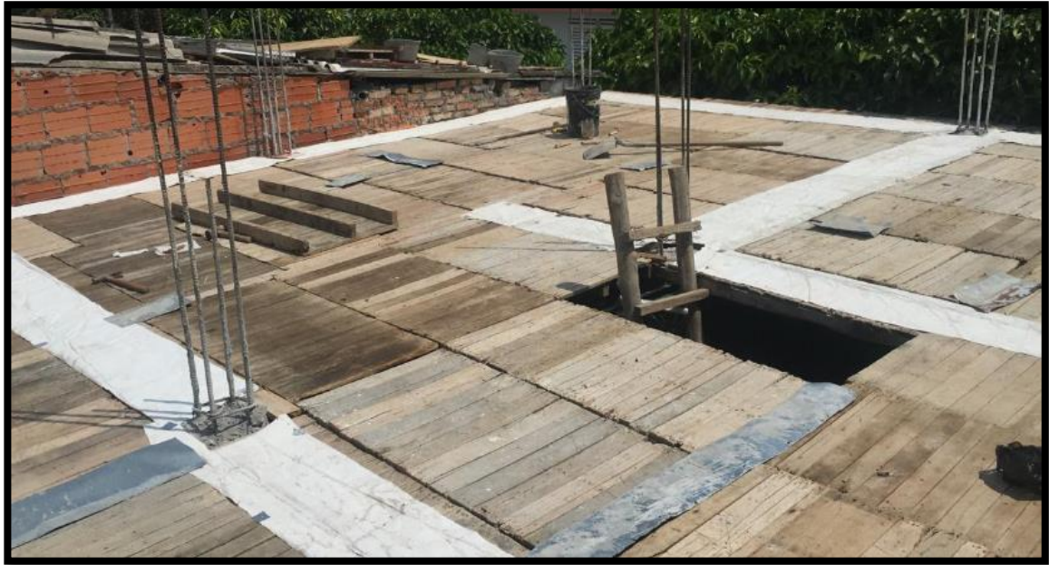
Imagen 58 Armado tarima para placa 2 piso.
