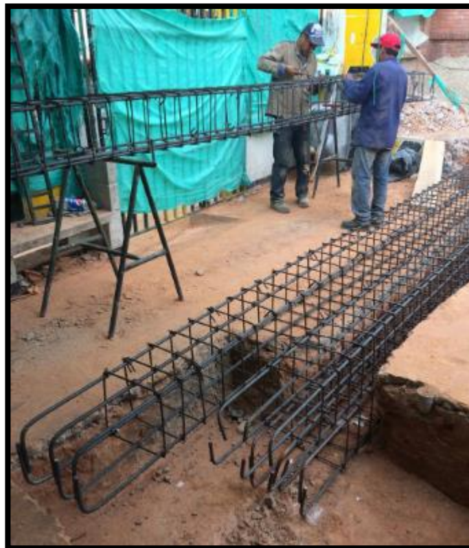
Imagen 17 Armado vigas de cimentación
