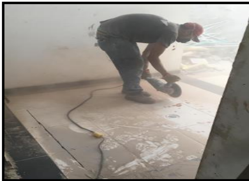
Imagen 49 Cimbrado y corte baldosa para excavar zapata
