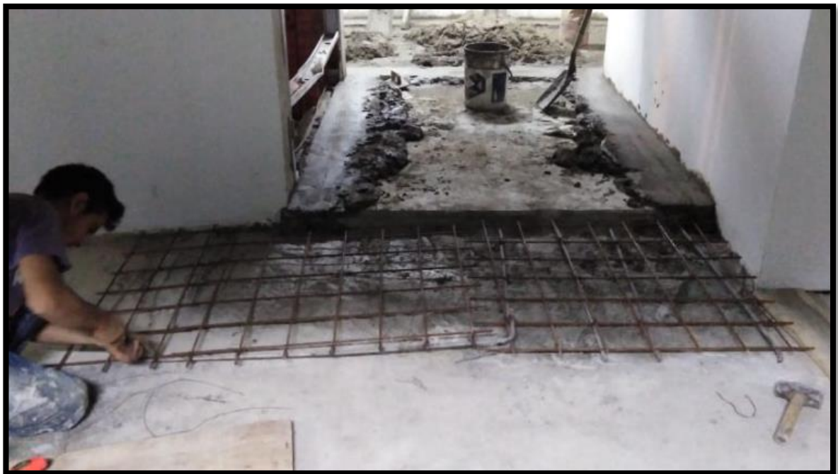
Imagen 42 Mortero y rampa de acceso para punto fijo en semisotano
