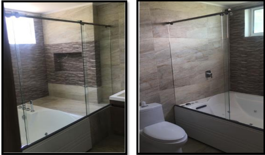
Imagen 34 Enchape e instalación de tina en alcoba principal
