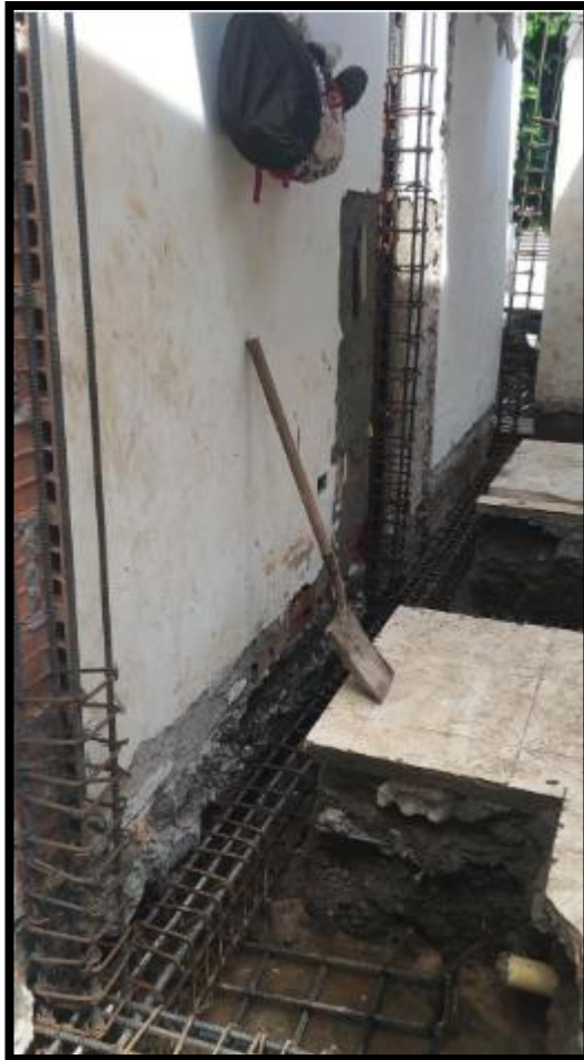
Imagen 53 Armado de columnas dentro de muros existentes.
