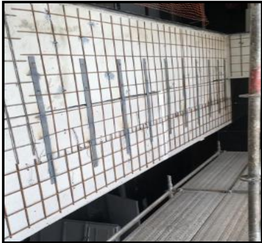
Imagen 48 Instalación platina y anclaje de malla para refuerzo en dintel
