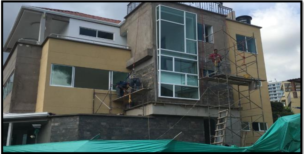
Imagen 32 Trabajos en fachada interna
