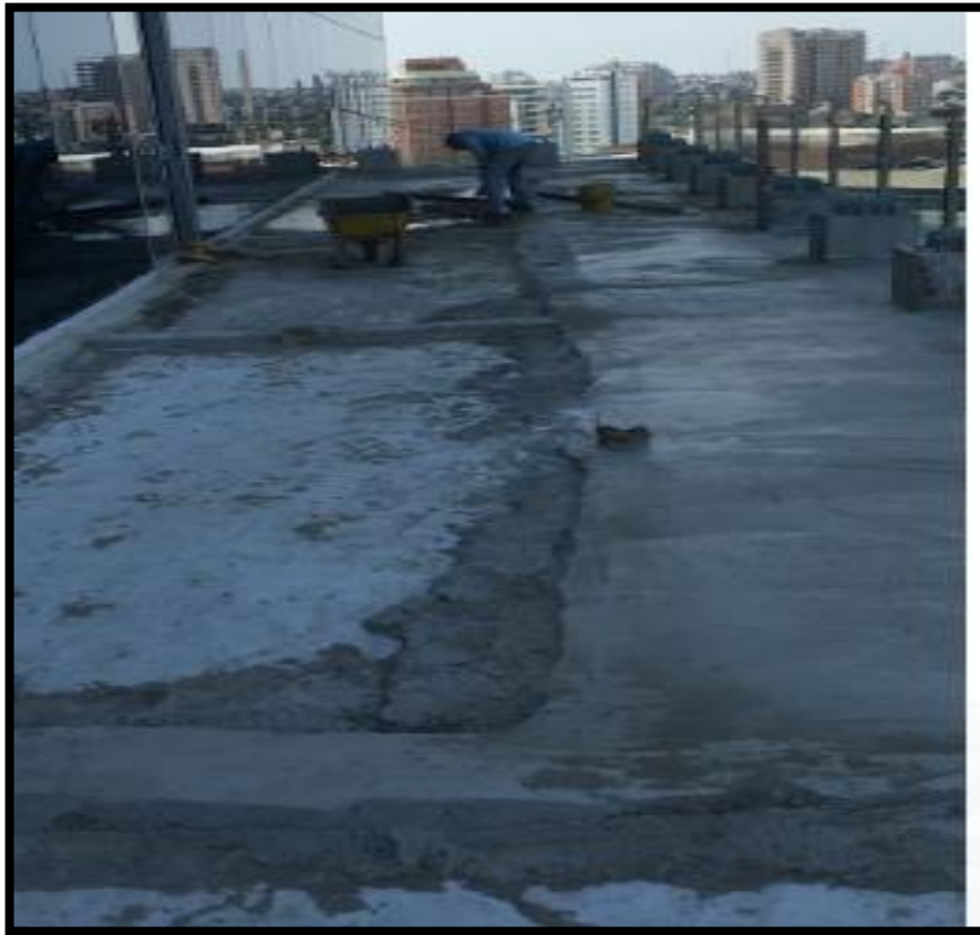
Imagen 41 Elaboración de maestras para mortero, Terraza piso 15
