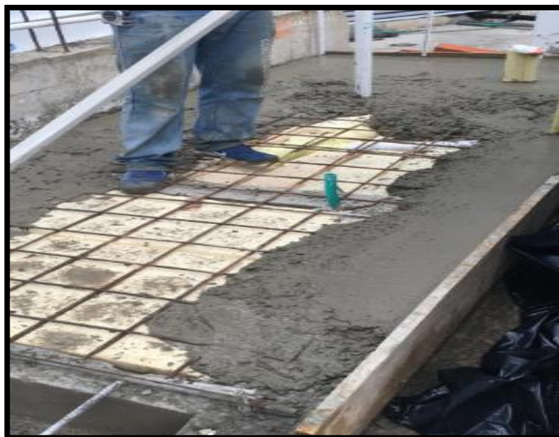
Imagen 45 Fundida ante piso baño
