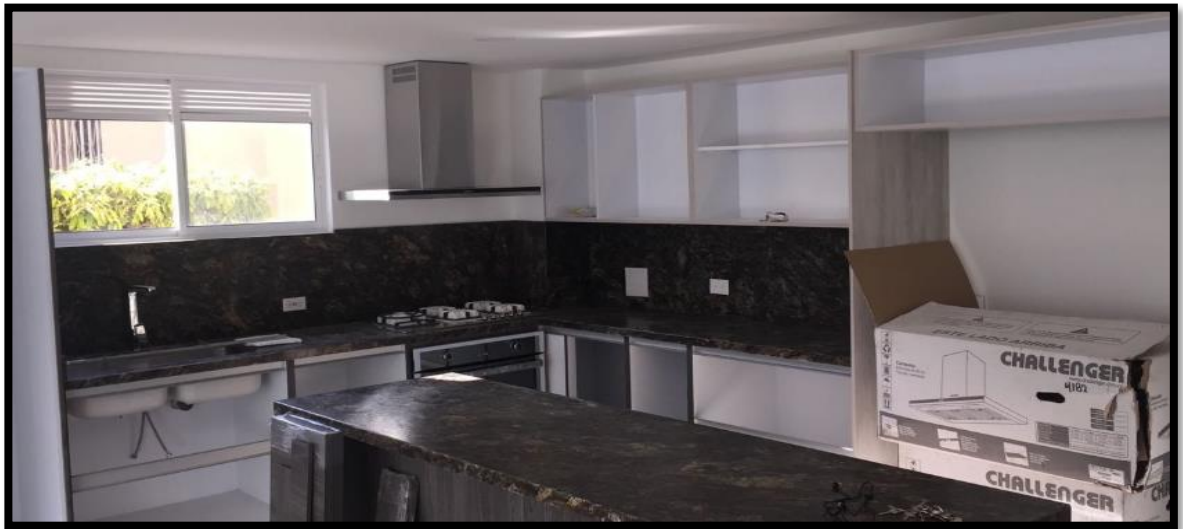
Imagen 33 Avance acabados de cocina
