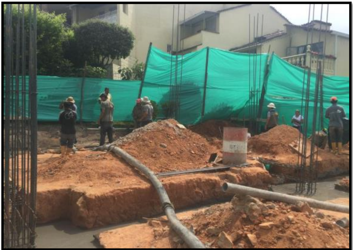
Imagen 19 Vaciado concreto de cimentación
