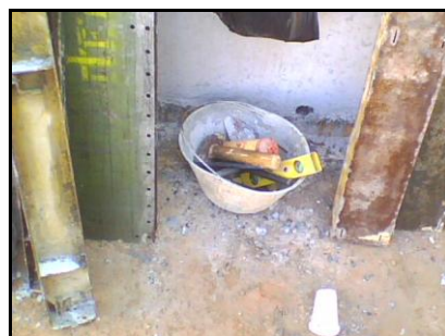
Porra, nivel , balde, cimbra
