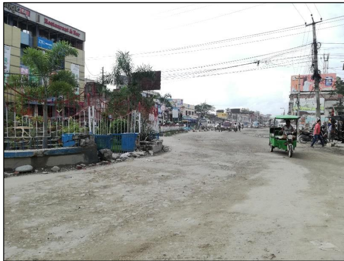
Figura 25. Condiciones del Pavimento
