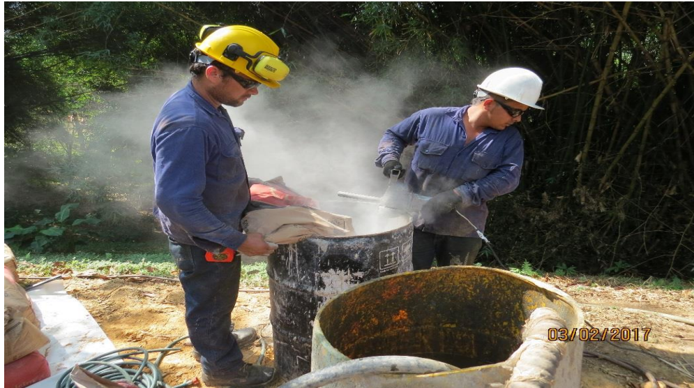
Figura 13. Preparación de la lechada
