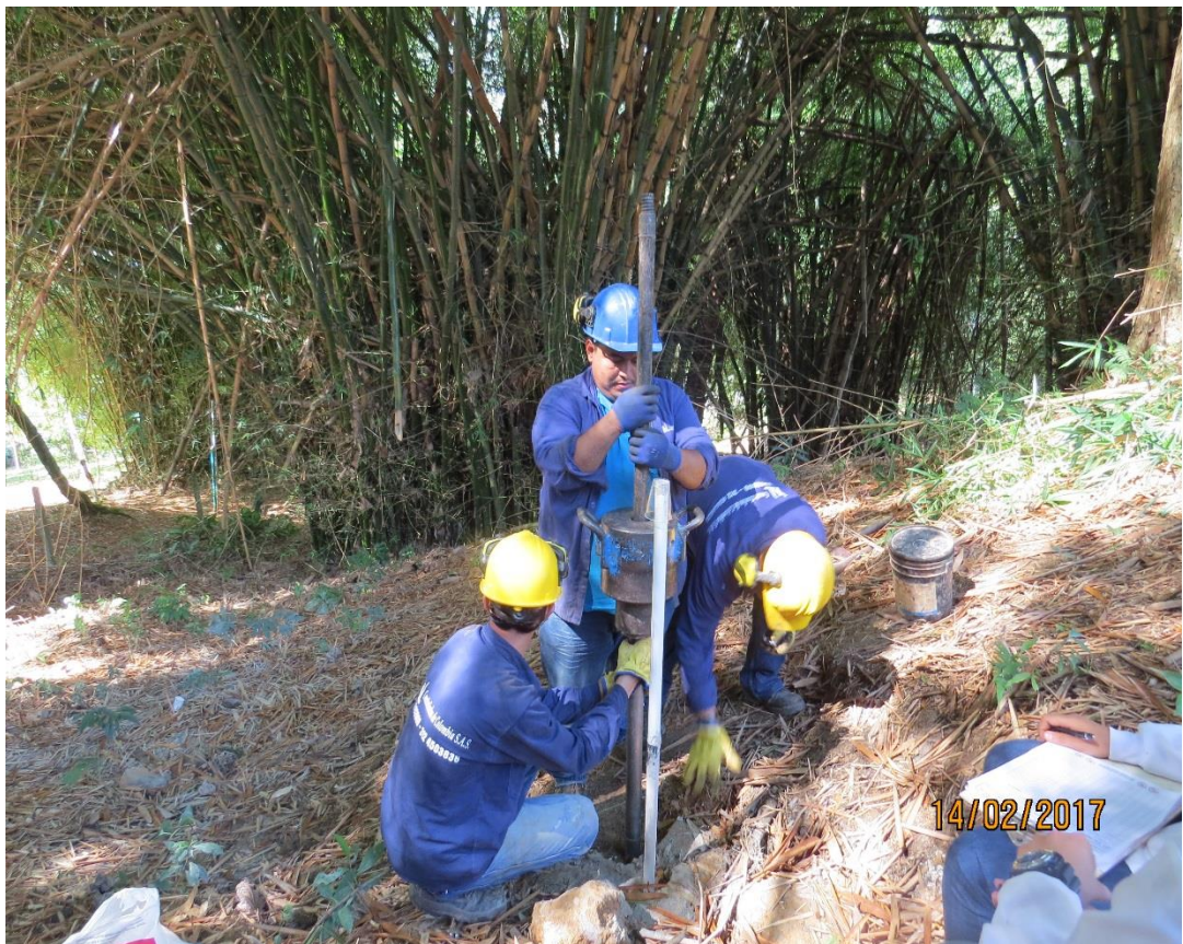
Figura 28. Ensayo SPT Post-inyección
