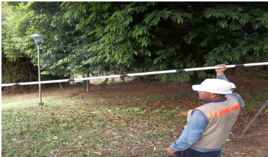
Figura 12. Tubería con neumáticos lista para ser introducida en la perforación
