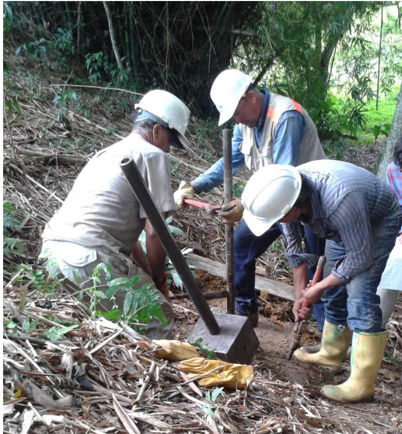
Figura 18. Prueba SPT en campo
