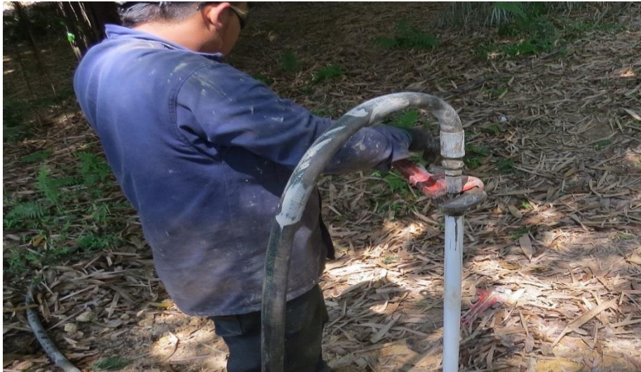
Figura 15. Inyección del suelo
