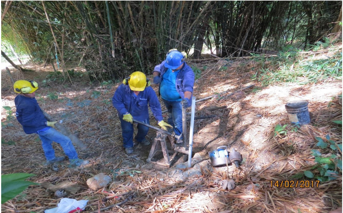
Figura 17. Prueba de SPT post-inyección
