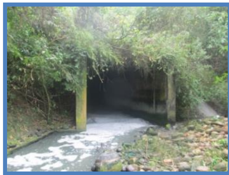
Figura 16. Aguas abajo Gaitán I Fuente: autor
