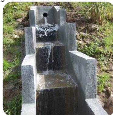
Fotografía 4 Vertimiento PTAR S 25.000
