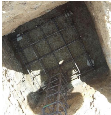
Figura 31. Acero de refuerzo para zapatas de muro de cerramiento
