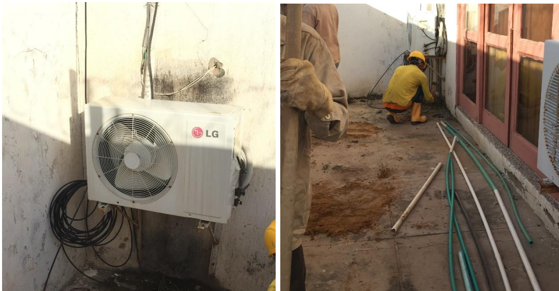
Figura 14. Traslado de máquinas de aires acondicionados
