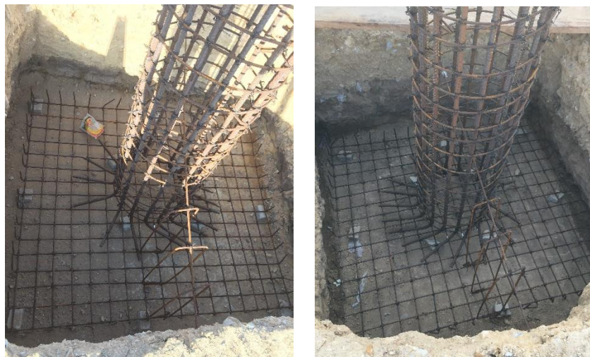
Figura 29. Acero de refuerzo para zapatas de polideportivo
