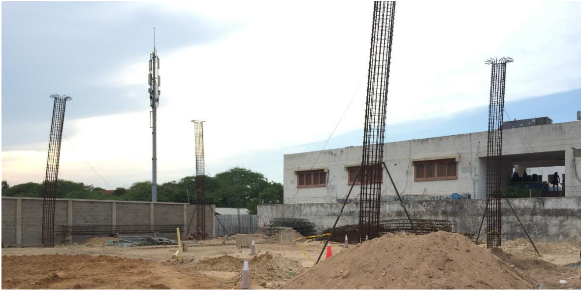
Figura 51. Acero de refuerzo para columnas de polideportivo
