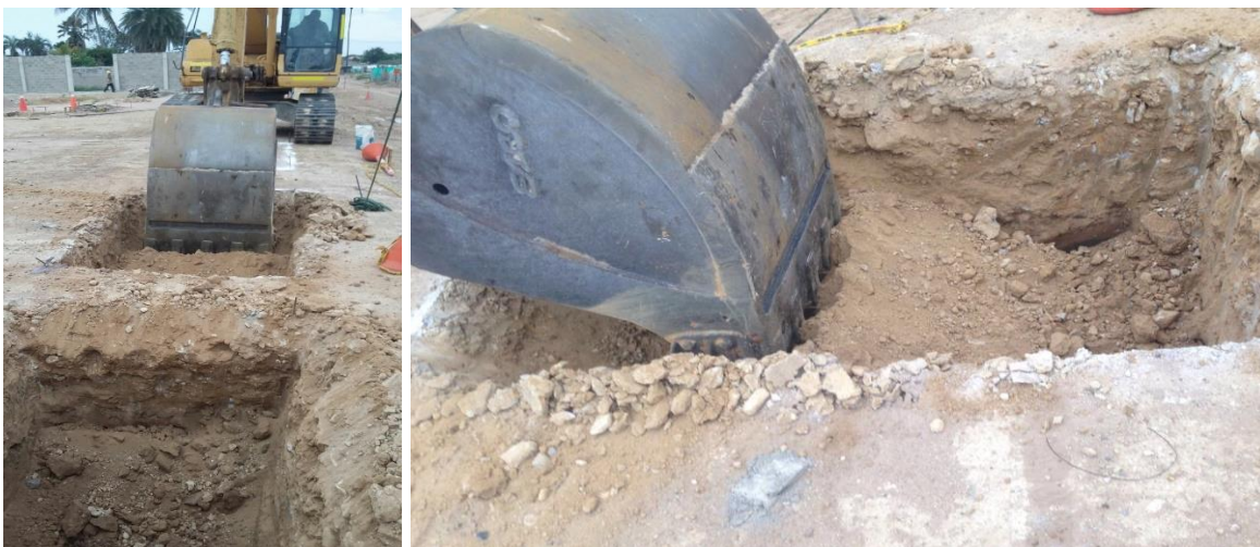
Figura 16. Excavación para zapatas de modulo de servicios
