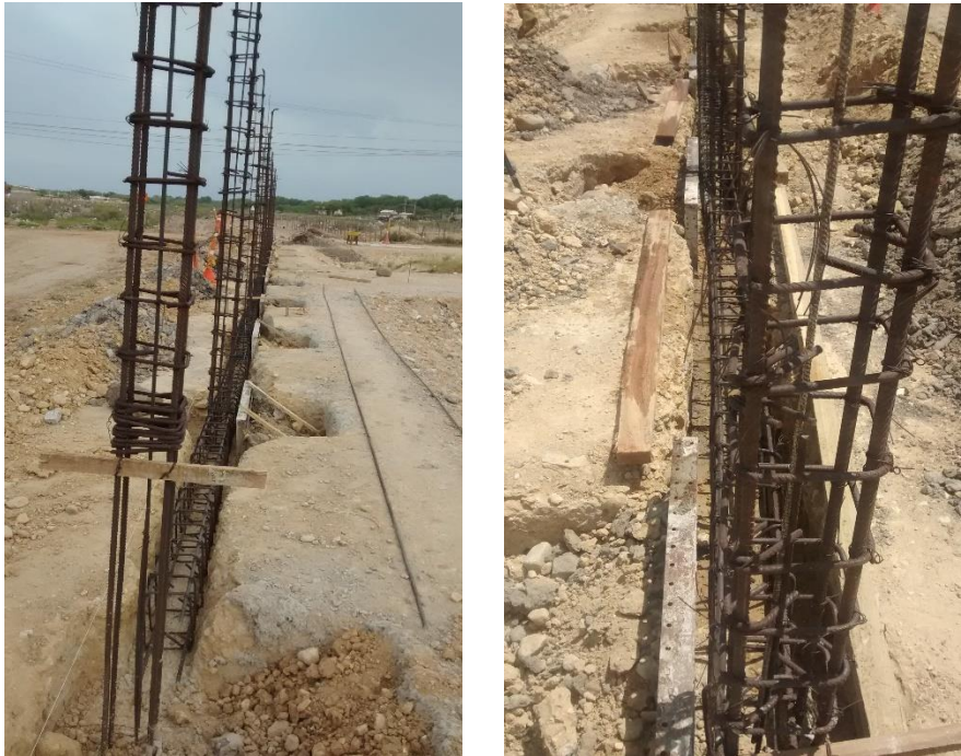
Figura 35. Acero de refuerzo para vigas de cimentación de muro de cerramiento
