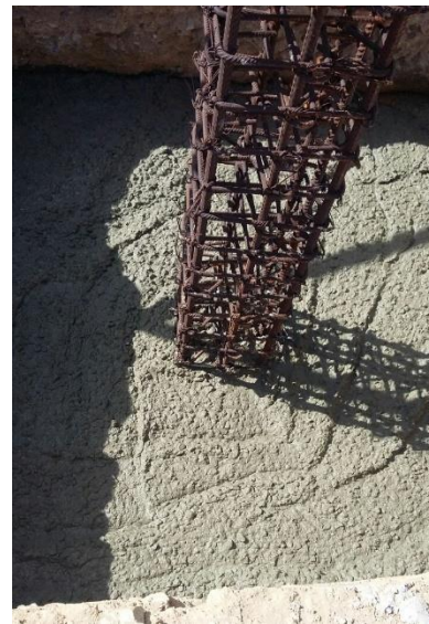
Figura 40. Concreto para zapatas de modulo de servicios
