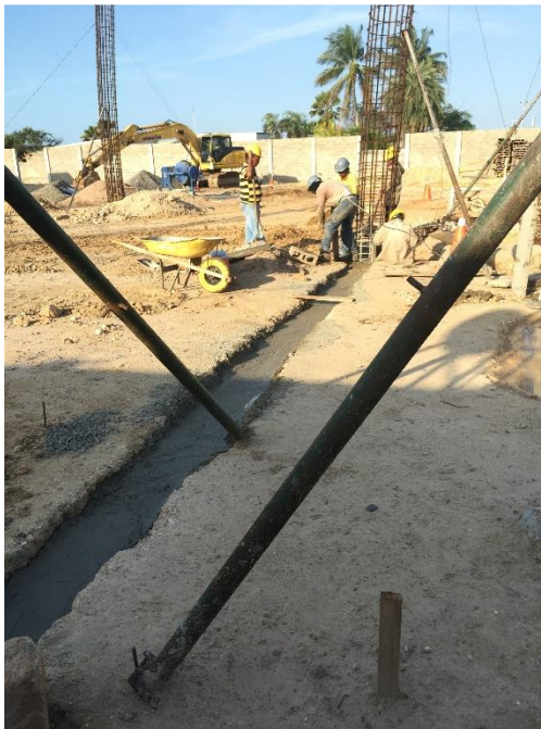
Figura 46. Concreto para vigas de cimentación de polideportivo
