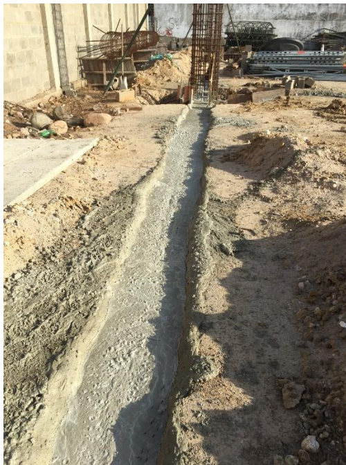
Figura 46. Concreto para vigas de cimentación de polideportivo
