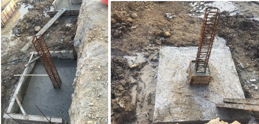
Figura 42. Concreto para zapatas de piscina de adultos
