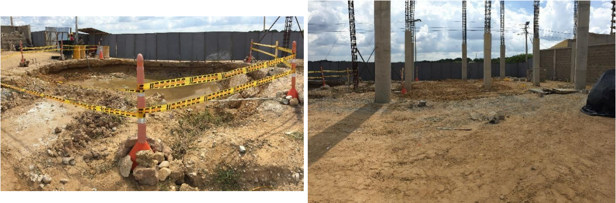
Figura 59. Módulo de servicios – Estado al finalizar las practicas (2)
