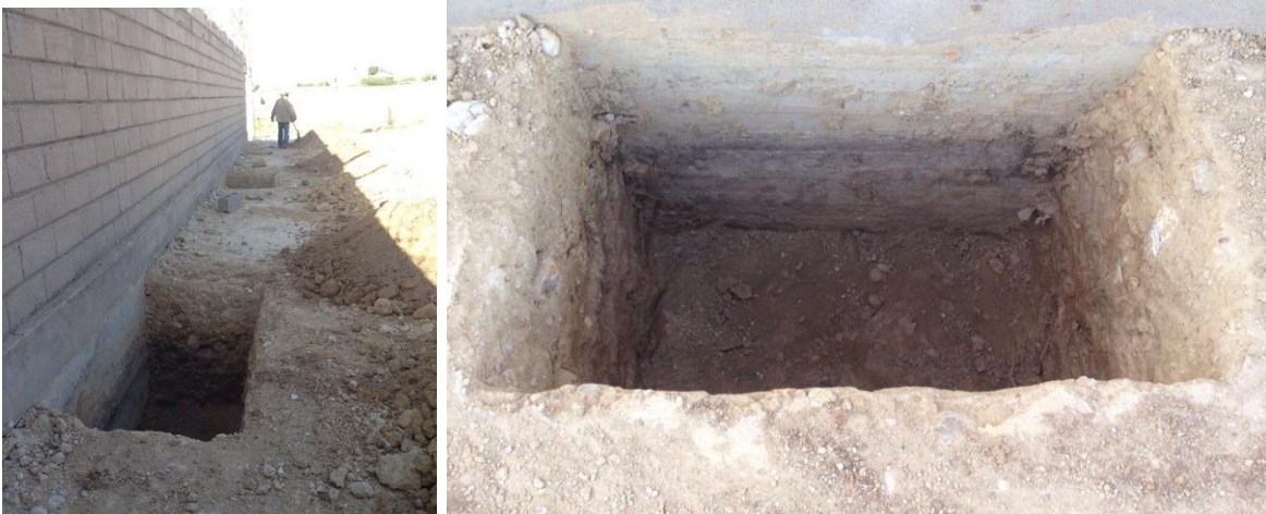
Figura 18. Excavación para zapatas de modulo administrativo
