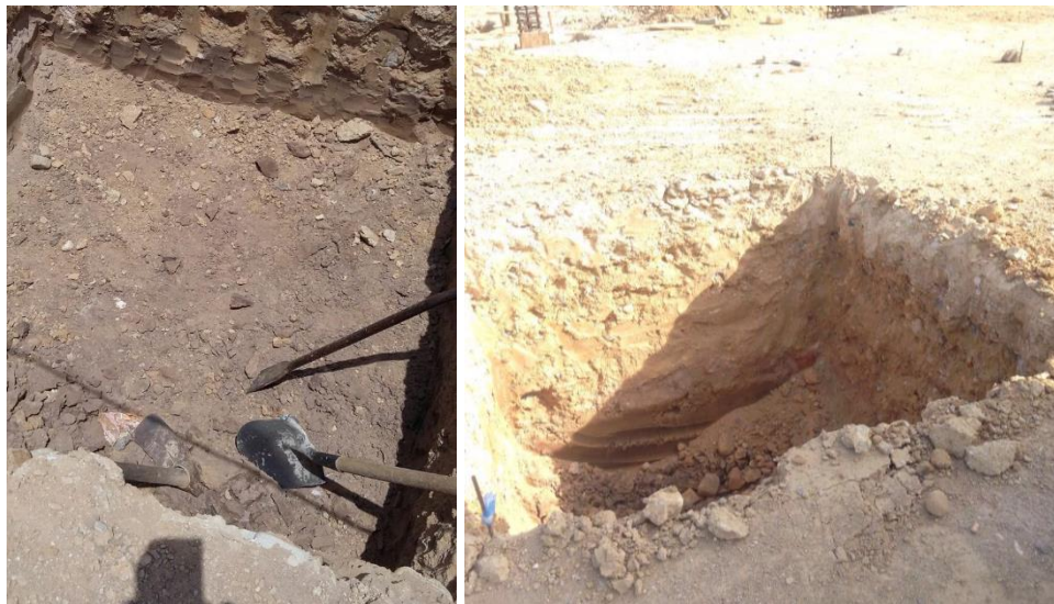
Figura 20. Excavación para zapatas de polideportivo
