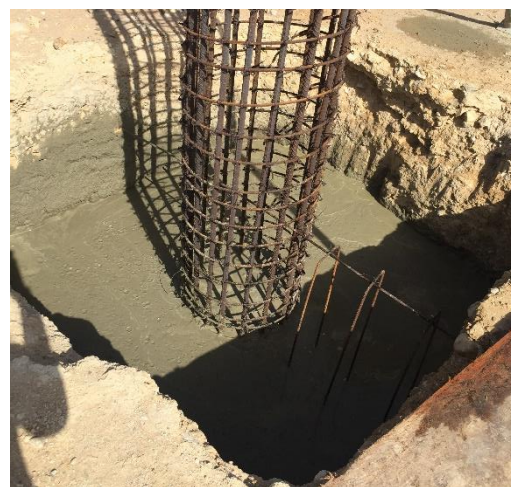
Figura 41. Concreto para zapatas de polideportivo
