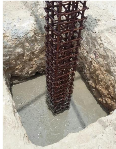
Figura 39. Concreto para zapatas de modulo administrativo
