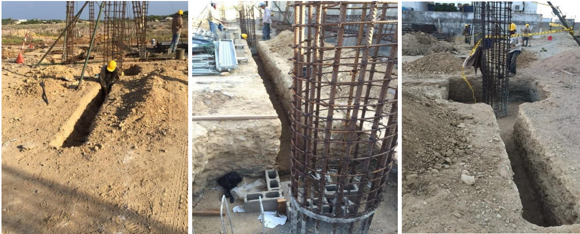
Figura 25. Excavación para vigas de cimentación de polideportivo
