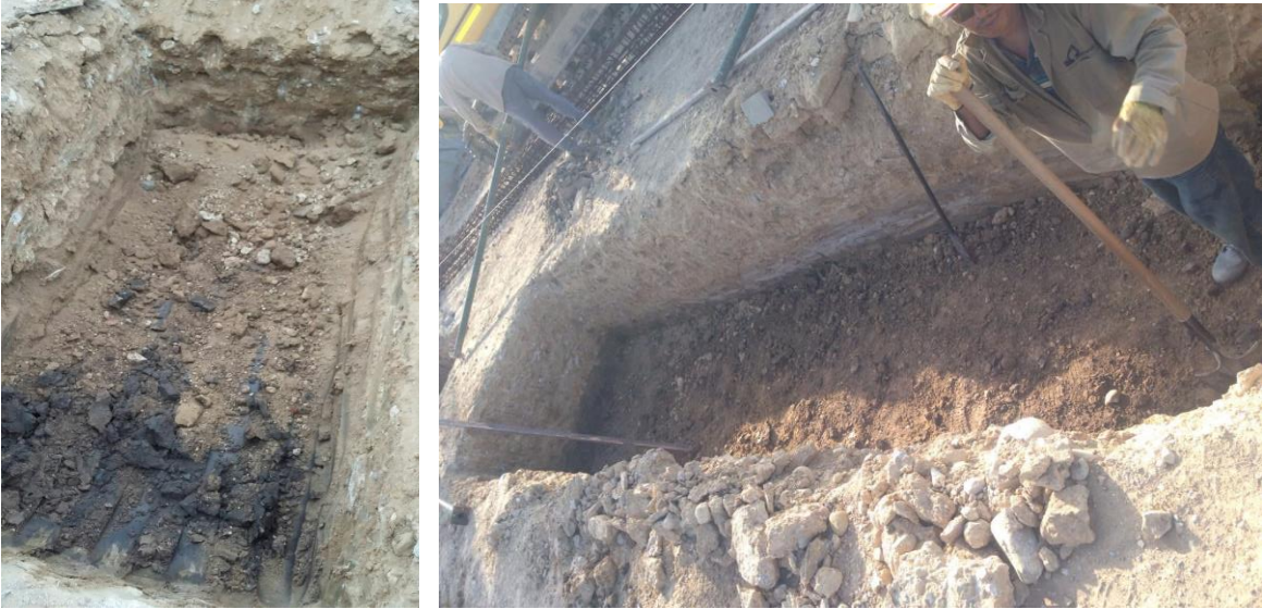
Figura 17. Excavación para zapatas de modulo de servicios
