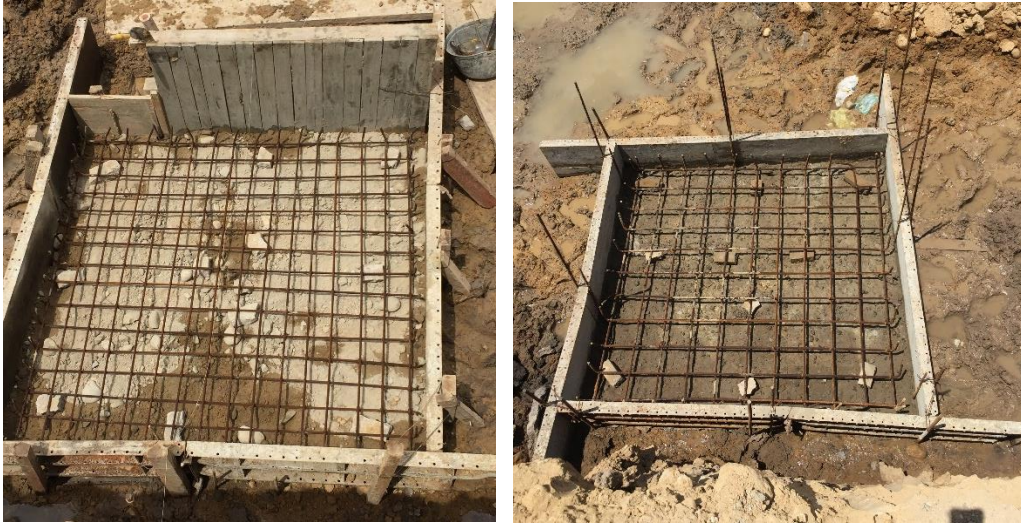
Figura 30. Acero de refuerzo para zapatas de piscina de adultos
