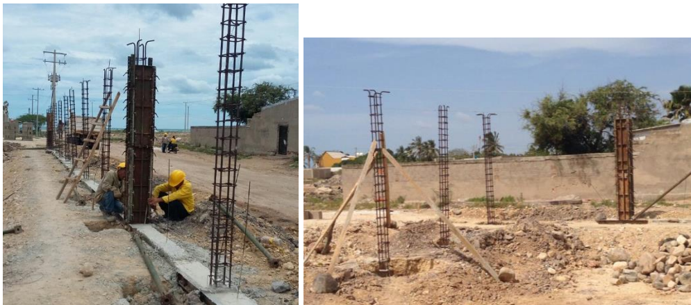
Figura 52. Acero de refuerzo para columnetas de muro de cerramiento
