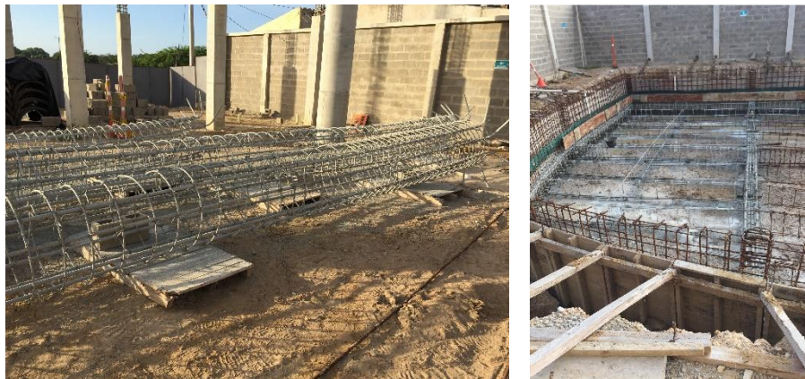
Figura 37. Protección del acero de refuerzo expuesto con agua cemento
