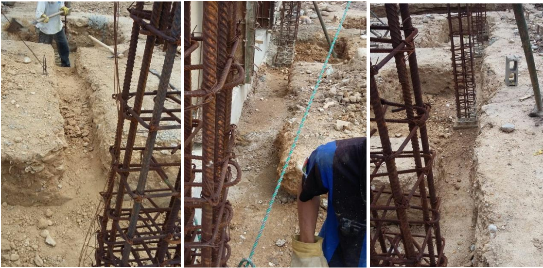
Figura 23. Excavación para vigas de cimentación de modulo de servicios
