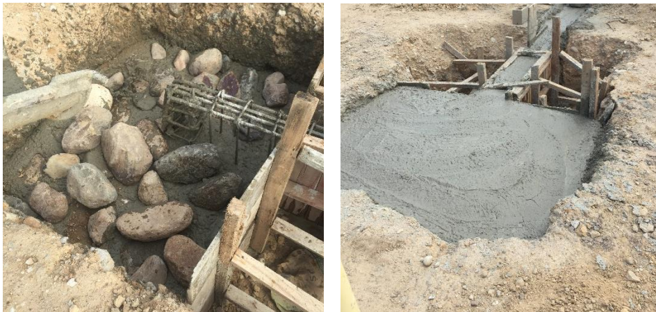
Figura 47. Concreto ciclópeo para contrapesos de polideportivo
