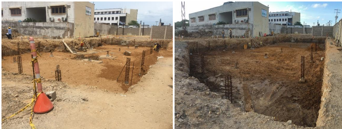
Figura 26. Relleno compactado de piscina de adultos
