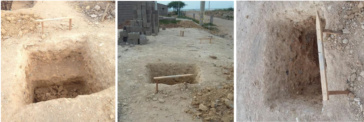
Figura 19. Excavación para zapatas de muro de cerramiento
