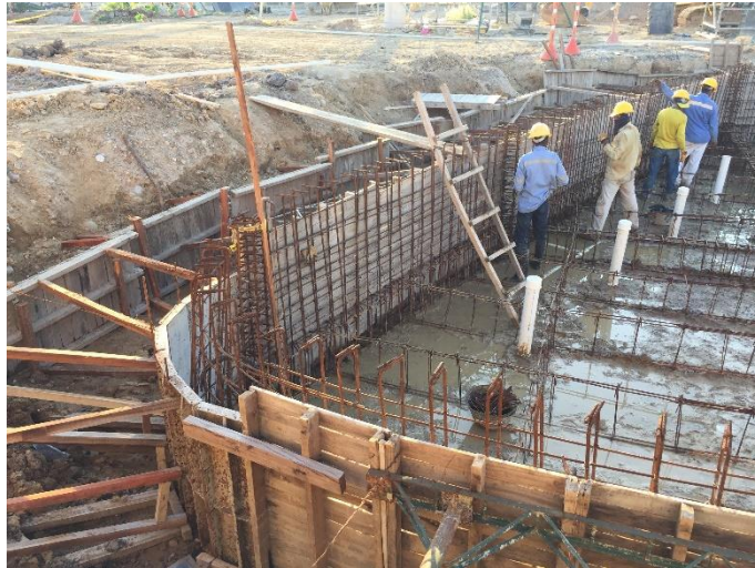
Figura 48. Acero de refuerzo para muro de piscina de adultos
