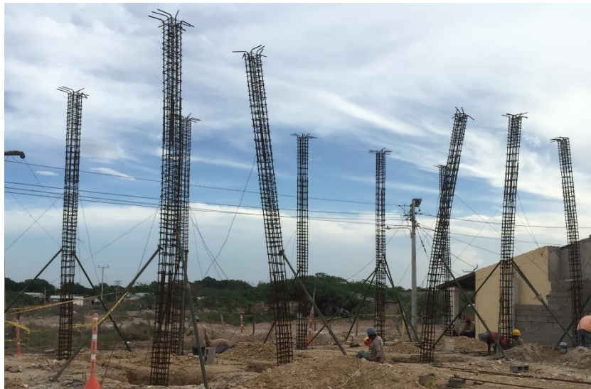
Figura 49. Acero de refuerzo para columnas de módulo de servicios
