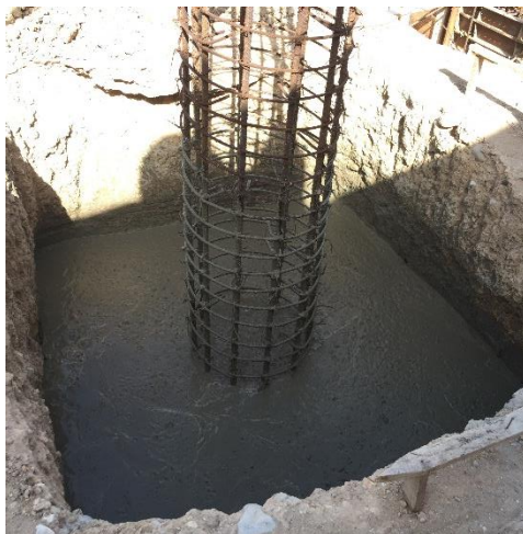
Figura 41. Concreto para zapatas de polideportivo
