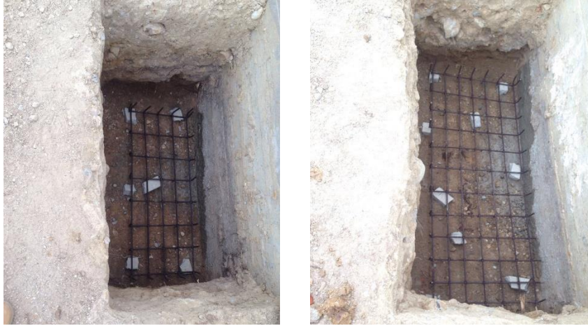
Figura 27. Acero de refuerzo para zapatas de modulo administrativo
