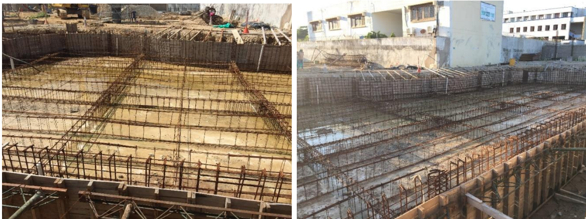
Figura 36. Acero de refuerzo para vigas de cimentación de piscina de adultos
