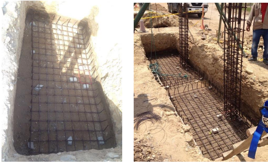
Figura 28. Acero de refuerzo para zapatas de modulo de servicios
