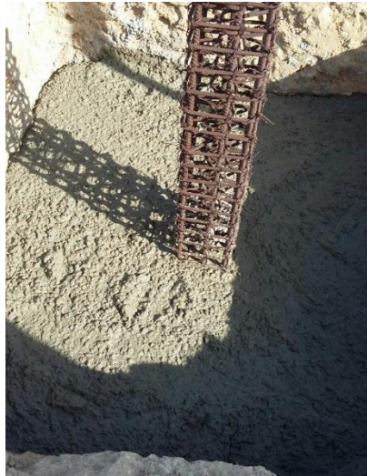
Figura 39. Concreto para zapatas de modulo administrativo
