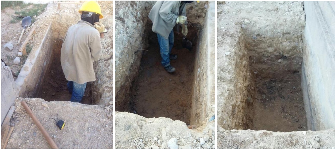
Figura 17. Excavación para zapatas de modulo de servicios
