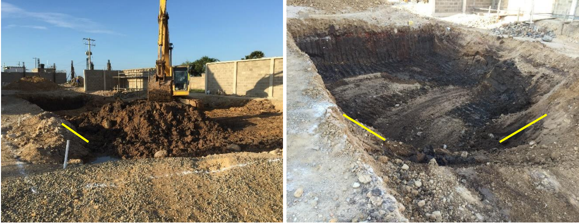
Figura 22. Excavación para piscina de adultos
