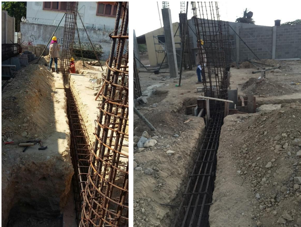
Figura 34. Acero de refuerzo para vigas de cimentacion de polideportivo
