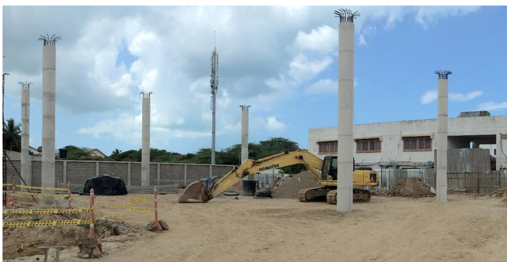
Figura 56. Concreto para columnas de polideportivo
