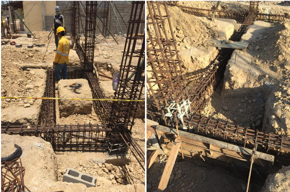
Figura 33. Acero de refuerzo para vigas de cimentación de modulo de servicios
