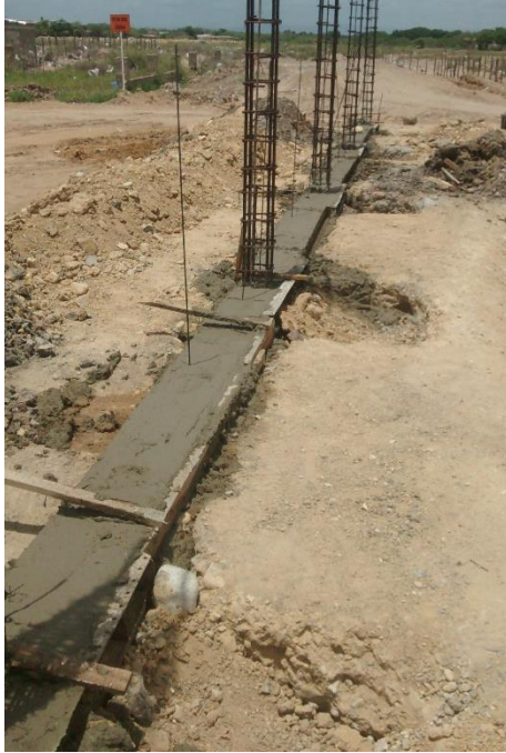
Figura 43. Concreto de para vigas de cimentacion de muro de cerramiento
