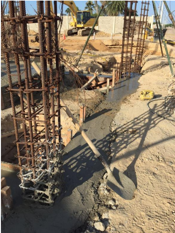
Figura 45. Concreto para vigas de cimentación de modulo de servicios
