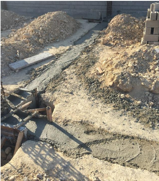
Figura 44. Concreto para vigas de cimentación de modulo administrativo
