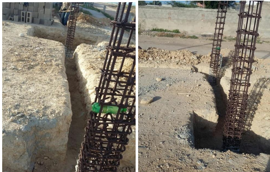
Figura 24. Excavación para vigas de cimentación de modulo administrativo
