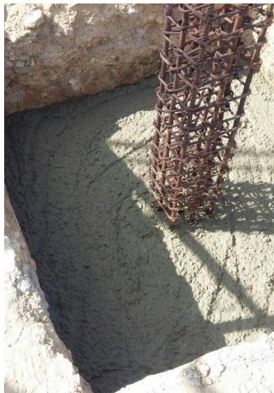
Figura 40. Concreto para zapatas de modulo de servicios
