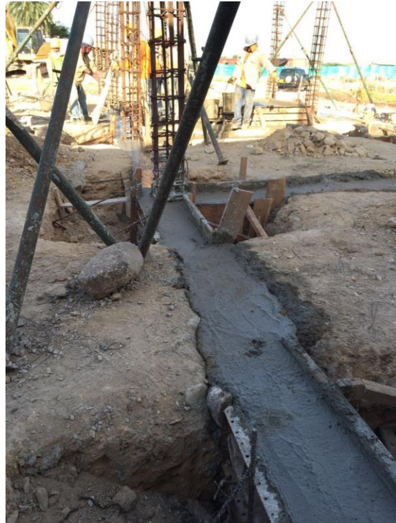
Figura 45. Concreto para vigas de cimentación de modulo de servicios
