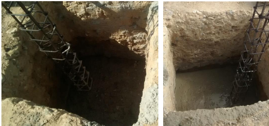
Figura 38. Concreto para zapatas de muro de cerramiento
