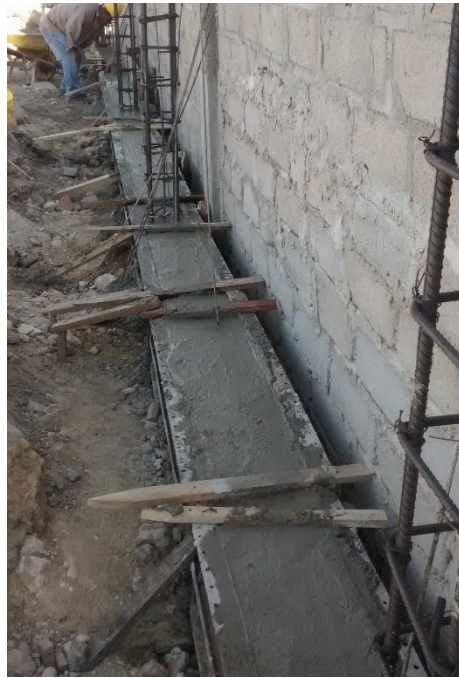
Figura 43. Concreto de para vigas de cimentacion de muro de cerramiento
