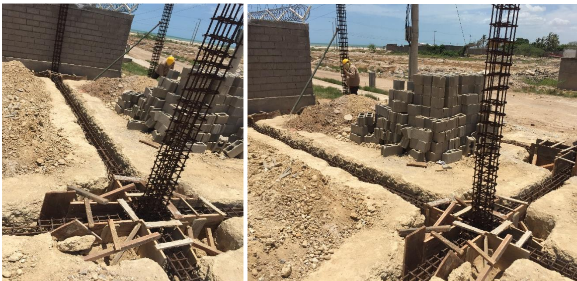
Figura 32. Acero de refuerzo para vigas de cimentación de modulo administrativo
