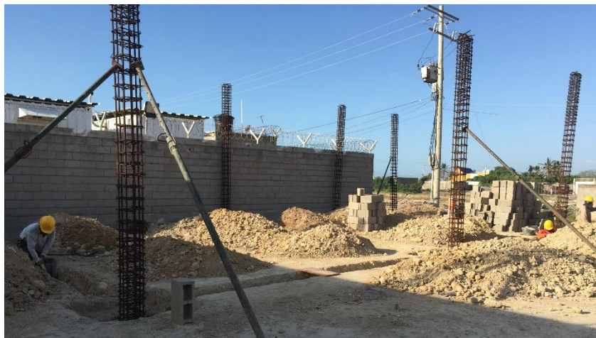
Figura 50. Acero de refuerzo para columnas de modulo administrativo
