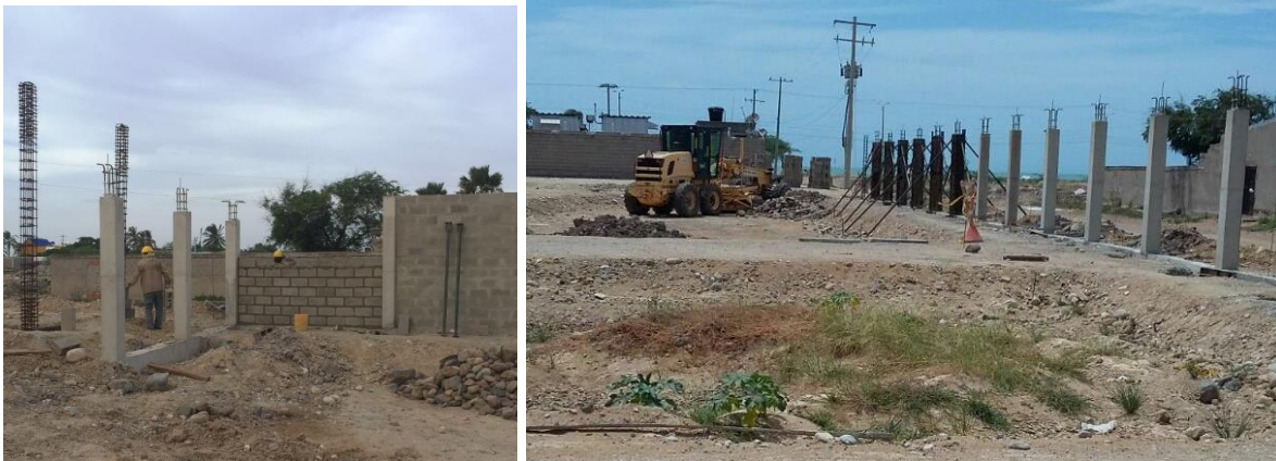
Figura 53. Concreto para columnetas de muro de cerramiento
