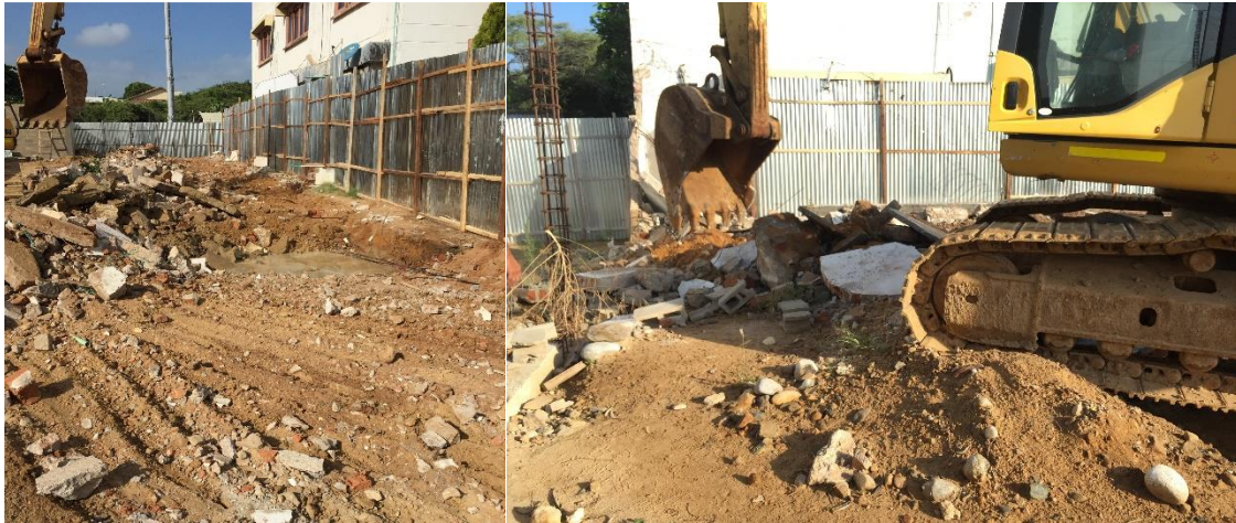
Figura 15. Demolición de muro existente
