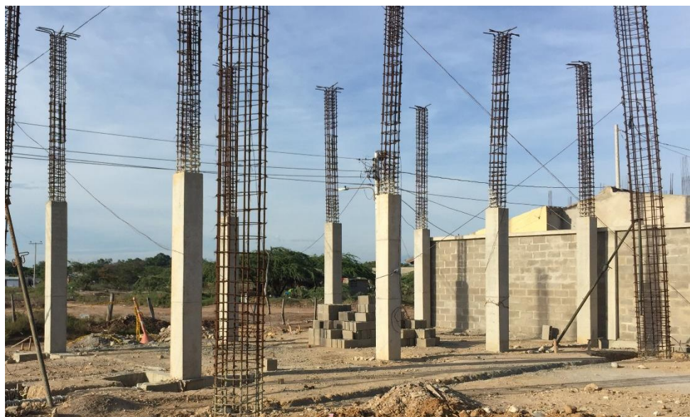
Figura 54. Concreto para columnas de módulo de servicios
