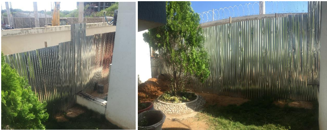
Figura 13. Cerramiento en láminas de zinc.
