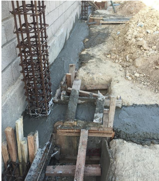
Figura 44. Concreto para vigas de cimentación de modulo administrativo
