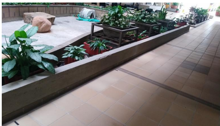
Figura15. Pasillo edificio K.
