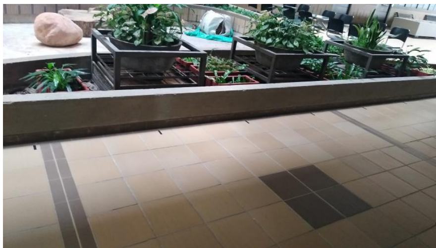
Figura14. Pasillo edificio k.
