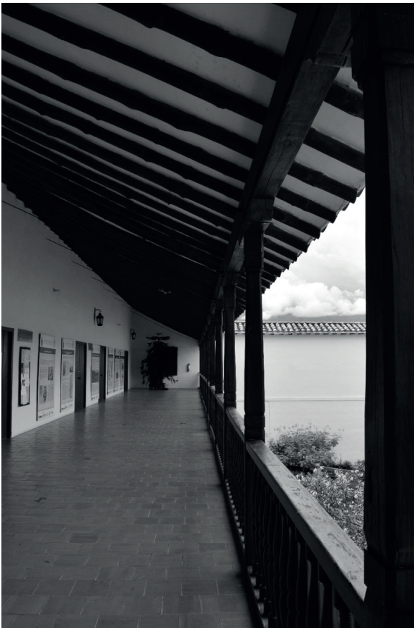
Imagen 6 Reestructuración de usos en edificaciones existentes. Actual alcaldía de Santa Fe de Antioquia, antes cabildo. Elaboración propia
