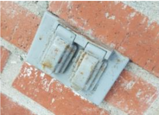
Ilustración 27. Tomacorriente Oxidados y Dañados
