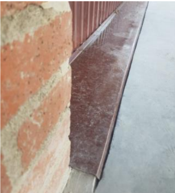
Ilustración 28. Juntas No Selladas en el Piso 2.
