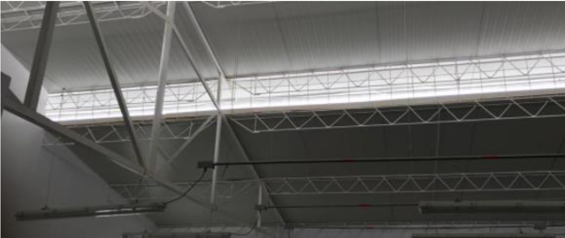
Ilustración 35. Cubierta Ágora Barrio Gaitán.
