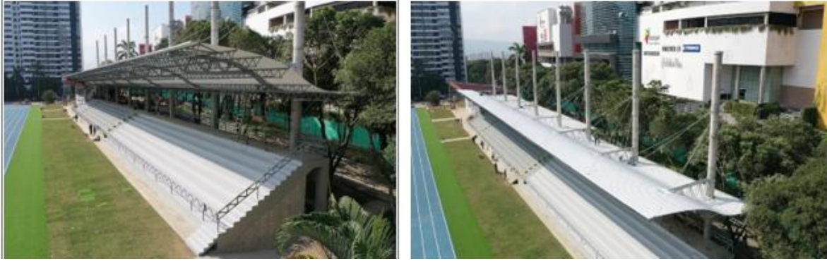
Ilustración 43. Gradería y Cubierta en el Estadio de Atletismo.
