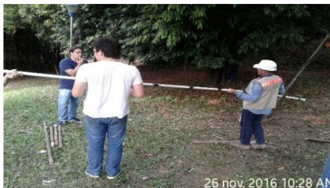
Figura 11 Preparación de la tubería de entrada e instalación de los tubos manguitos
