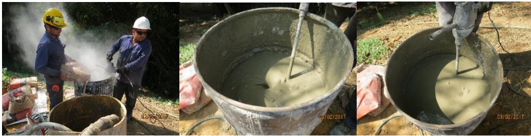
Figura 19 Preparación de la lechada
