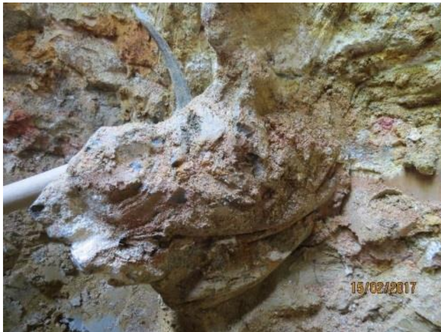
Figura 14 Exposición del suelo después de la aplicación de Fracture Grouting
