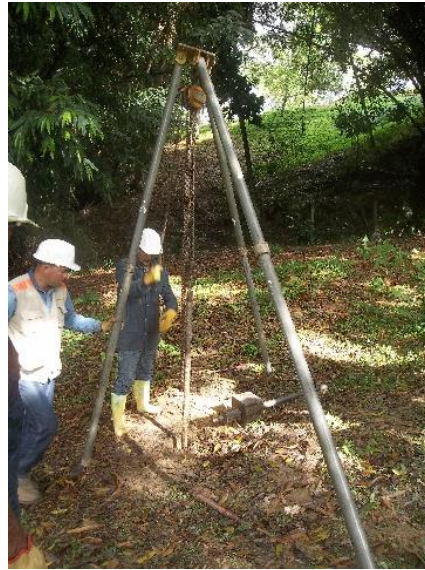
Figura 16 Ensayo de campo SPT antes de la inyección de fractura
