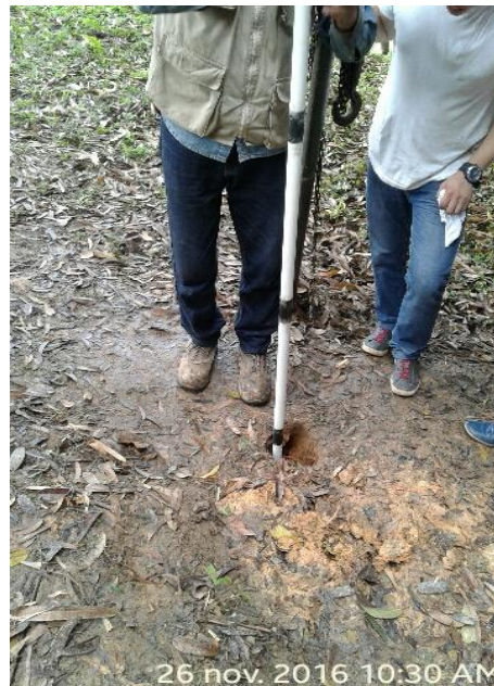
Figura 17 Instalación de la tubería de entrada
