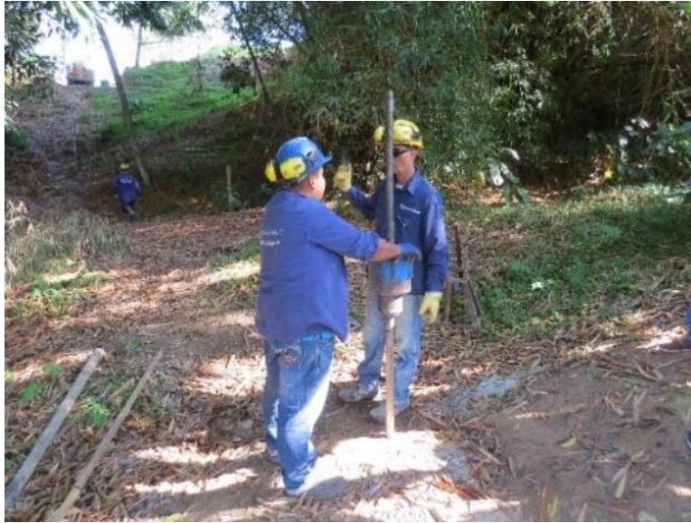
Figura 22 Ensayo de campo SPT post - inyección
