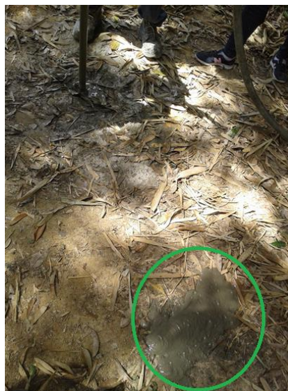
Figura 20 Afloramiento de la lechada
