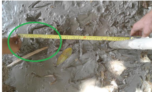
Figura 21 Afloramiento de la lechada después de la fase de fractura
