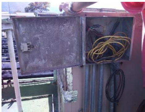
Figura 16: Controlador de Humedad Relativa Honeywell
