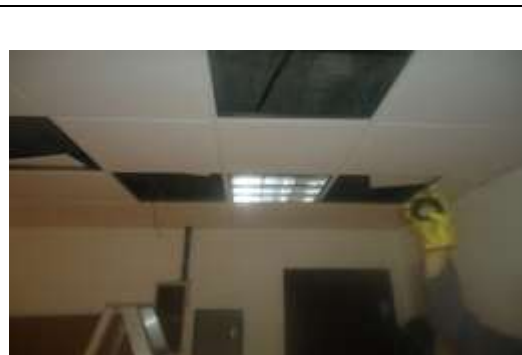
Foto No. 2. DESMONTE DE CIELO RAZO MODULADO
