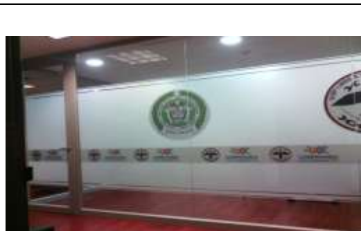
Foto No. 1. DIVISION PISO TECHO EN VIDRIO TEMPLADO
