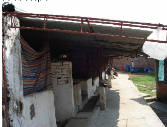
Fotografía 8. Centro de acopio
