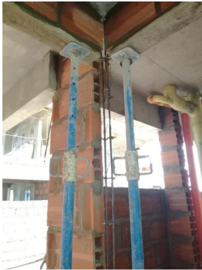
Figura 59. Armado de acero de refuerzo para columnetas
