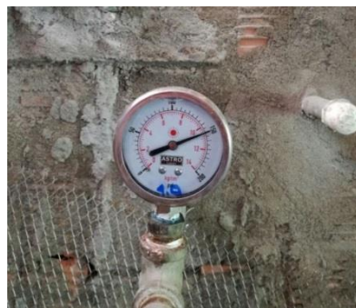
Figura 25. Prueba No. 2 de presión a la tubería hidráulica.
