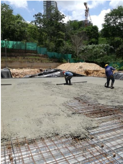
Figura 50. Vaciado y nivelación del concreto
