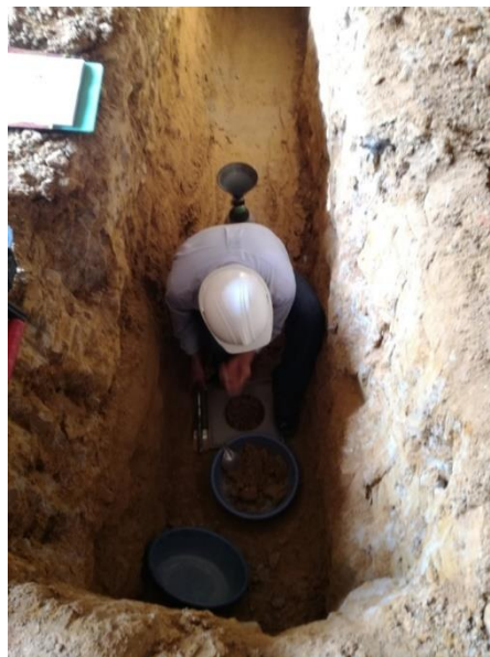
Figura 32. Ensayo de densidad en campo a zanja para tubería sanitaria.
