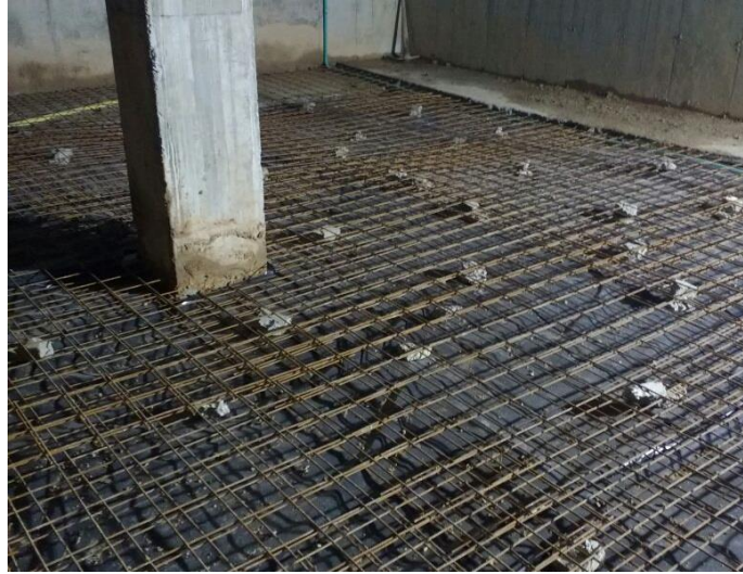
Figura 45. Armado de malla sobre separadores antes de fundir antepiso
