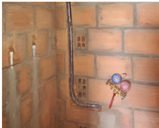
Figura 28. Prueba de presión a la tubería de aire acondicionado.
