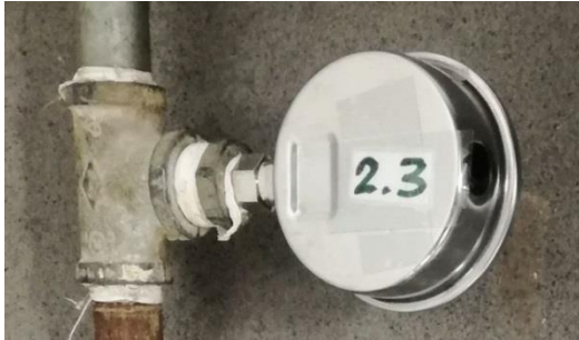
Figura 21. Marca realizada a manómetro calibrado
