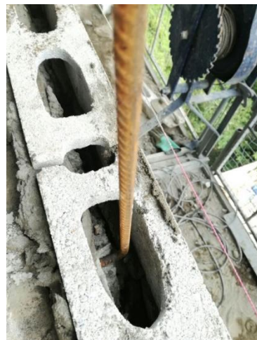
Figura 63. Dovela anclada a la placa en mampostería de fachada.
