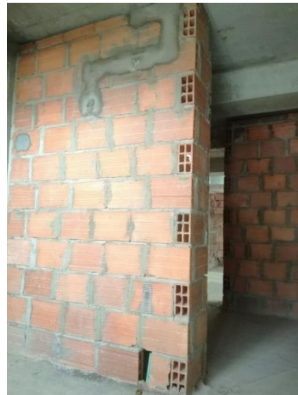
Figura 58. Muros trabados cada 2 hileras
