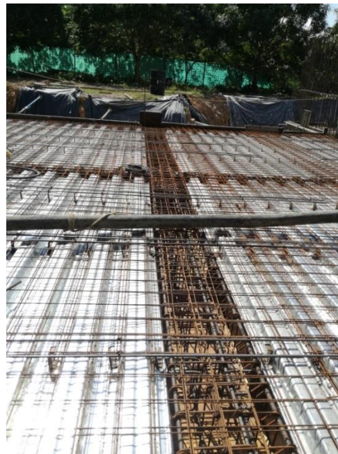
Figura 49. Armado de placa en Steel-Deck antes de vaciar el concreto.
