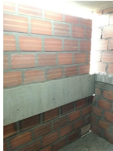
Figura 60. Espacio para realizar columneta y viga cinta.
