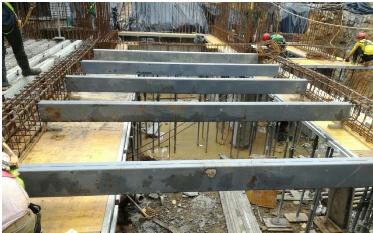
Figura 47. Entramado, armado de acero en vigas y perlines colocados.
