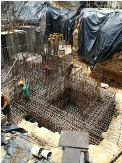
Figura 43. Armado de acero de cimentación.
