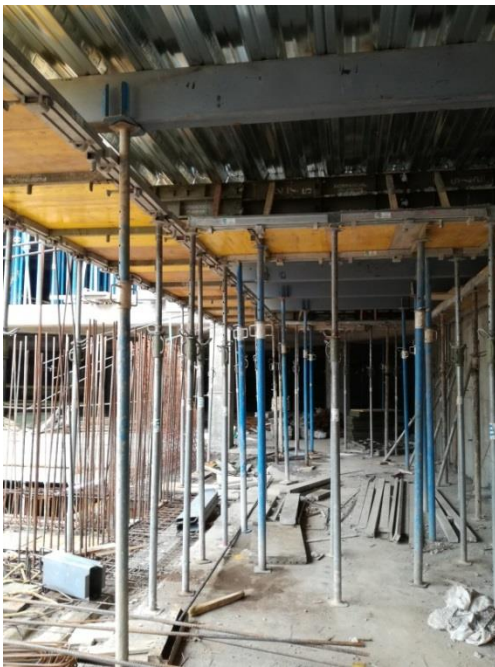
Figura 48. Paraleo, entramado y encofrado en placa.
