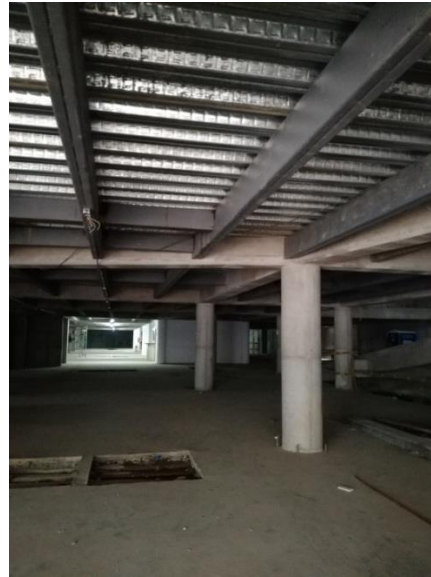
Figura 51. Resultado final de la placa en Steel-Deck, vigas y columnas.
