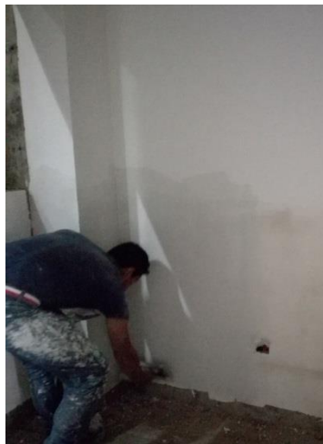
Figura 74. Aplicación de capas de estuco plástico sobre ESTUKA 2.
