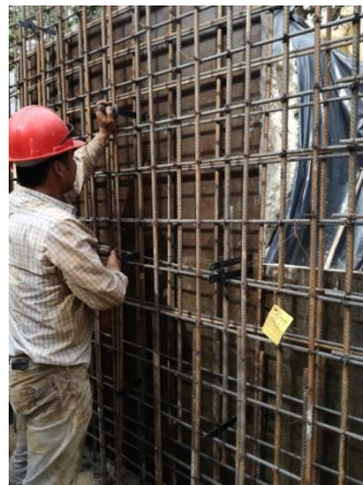
Figura 53. Armado de acero de refuerzo, formaleta con corbata y sellos anti goteros.
