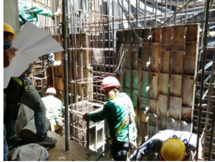
Figura 52. Armado y encofrado de muro de contención a una cara.
