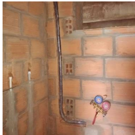
Figura 71. Instalación final de tubería en regatas y prueba de presión.
