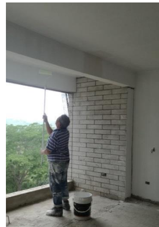
Figura 75. Aplicación de Primera capa de pintura sobre estuco plástico.
