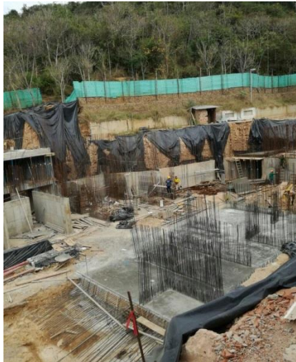
Figura 44. Acabado final después de allanar en la cimentación de la zona 3
