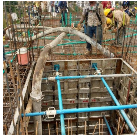
Figura 56. Parales para sostener los muros del foso del ascensor.
