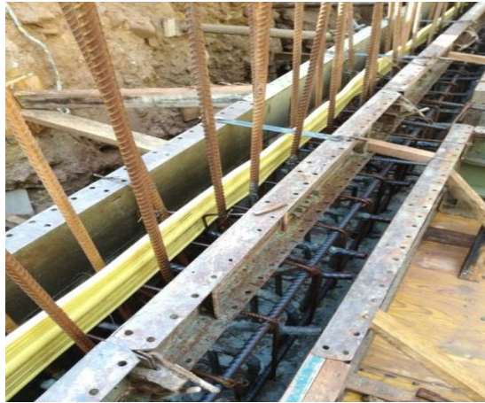
Figura 42. Cinta PVC para sellar juntas del tanque de agua del proyecto.
