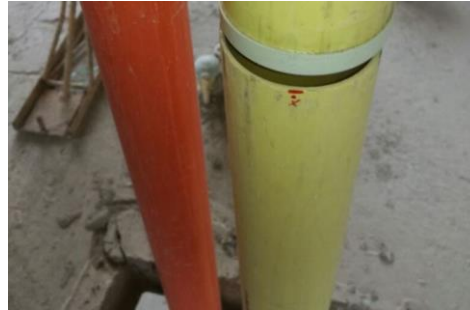
Figura 19. Prueba de estanqueidad en tubería de desagüe.
