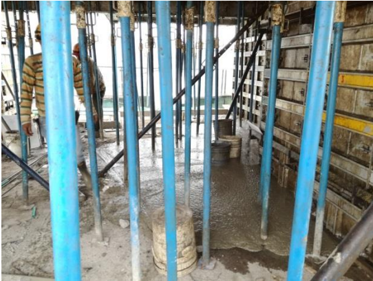
Figura 55. Parales para sostener la placa.
