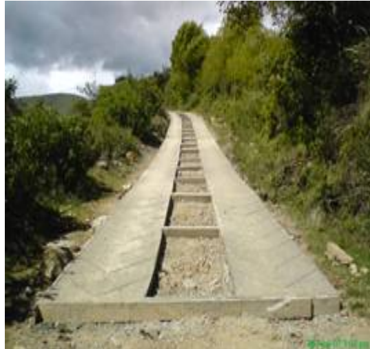
Imagen 26 – Huella Vehicular Terminada 1.
