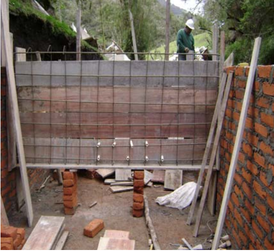
Imagen 22 - Armado de Acero y Formaleta para pantalla.
