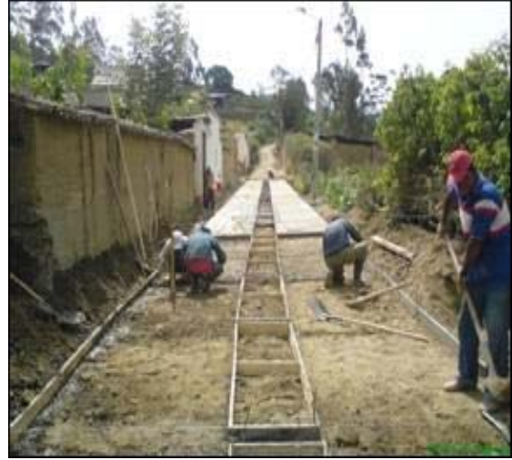
Imagen 30 – Armado del Acero de Refuerzo.
