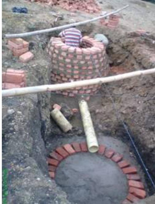
Imagen 17 – Construcción de Pozos.
