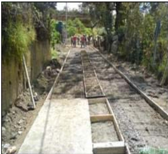
Imagen 31 – Formaleta Armada lista para Fundir.
