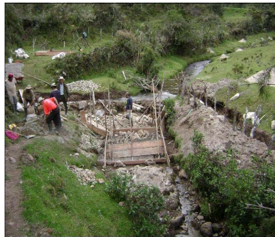
Imagen 19 – Construcción Bocatoma.
