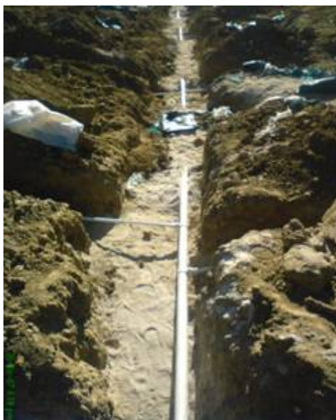
Imagen 15 – Instalación Tubería Agua Potable.
