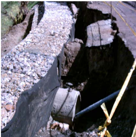
Imagen 13 – Recubrimiento con Geotextil.
