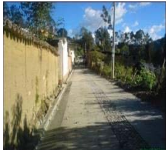
Imagen 32 – Huella Vehicular Terminada.
