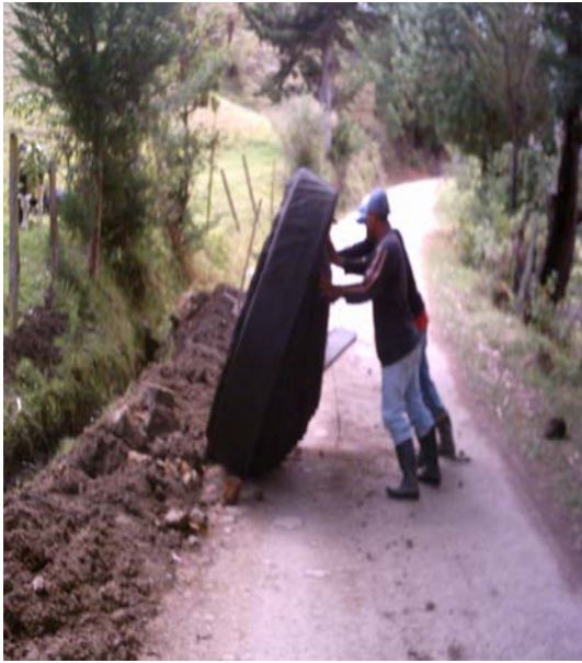
Imagen 7 – Instalación GEODREN ADS.
