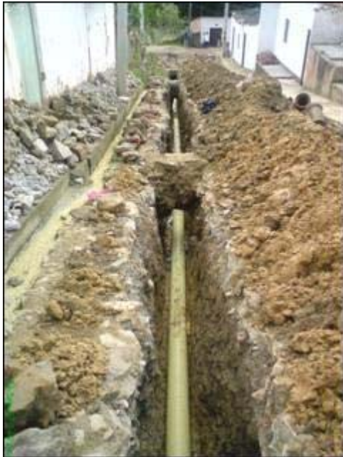
Imagen 3 – Tubería PVC instalada.
