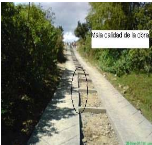
Imagen 27 – Huella Vehicular Terminada 2.
