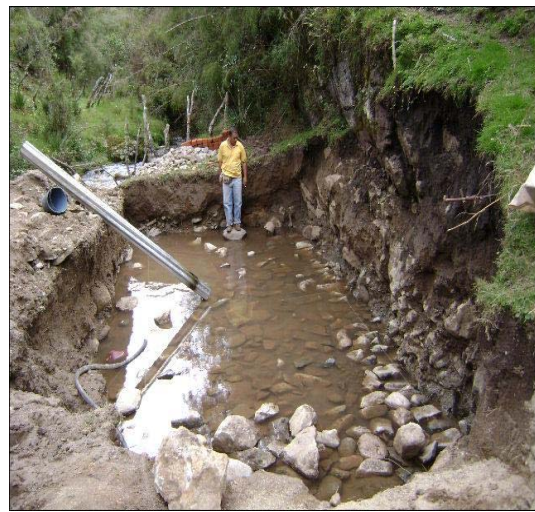
Imagen 21 – Excavación para el Tanque Desarenador.
