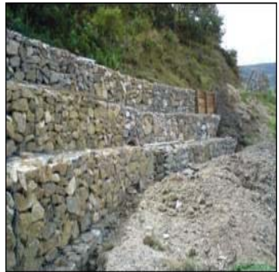
Imagen 14 – Muro de Contención en Gaviones.
