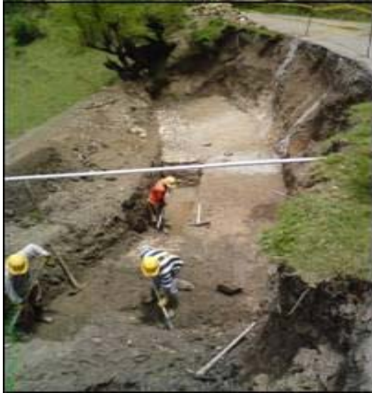
Imagen 11 – Excavación para Gaviones.
