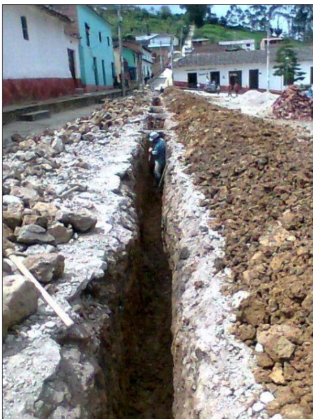
Imagen 1 - Excavación para Alcantarillado.
