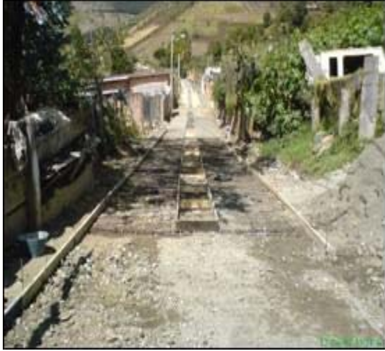
Imagen 29 – Replanteo y Armado Formaleta.
