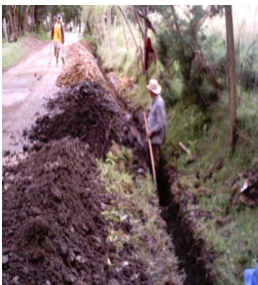
Imagen 5 – Excavaciones para Filtro a
