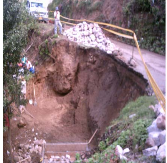
Imagen 12 – Excavación para Gaviones.
