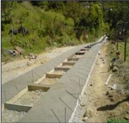
Imagen 25 – Huella Vehicular Recién Fundida.
