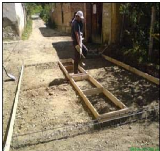
Imagen 28 – Armado de Formaleta Huella Vehicular.
