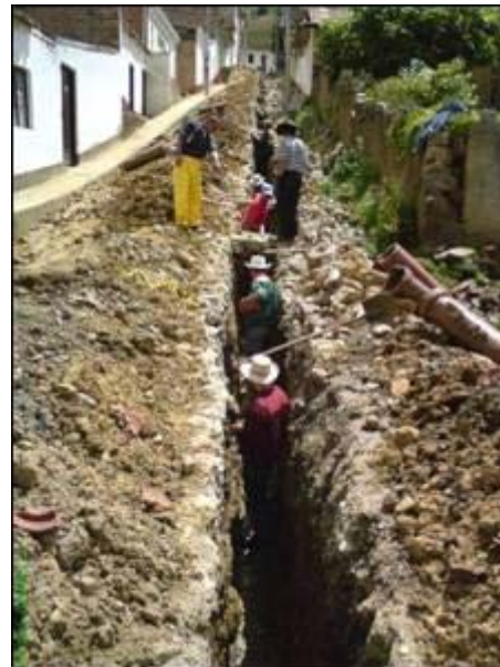
Imagen 2 – Cambio de tubería de Gres.
