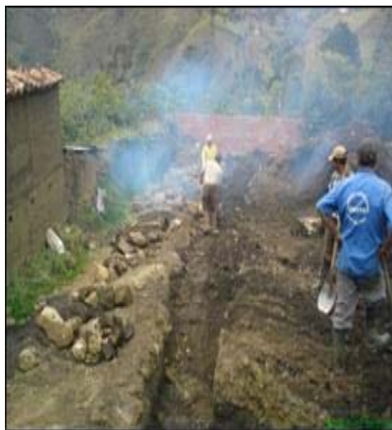
Imagen 16 – Relleno y Compactado con Material Común.
