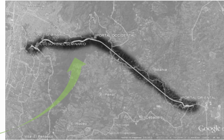
CONEXIÓN ABURRÁ ORIENTE, TÚNEL DEL SEMINARIO Y SANTA ELENA
