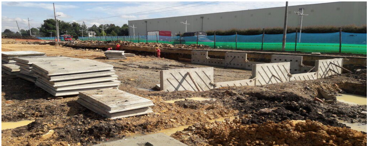
Figura 13: Primera línea de paneles del muro en tierra armada sobre el eje 1. (Autor)
