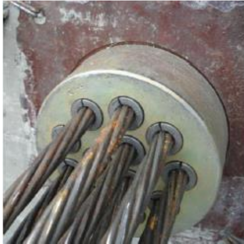
Figura 65: Torones y cuñas enhebradas en el bloque de anclaje. (Autor)
