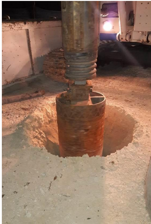
Figura 20: Balde perteneciente a la piloteadora. (Autor)
