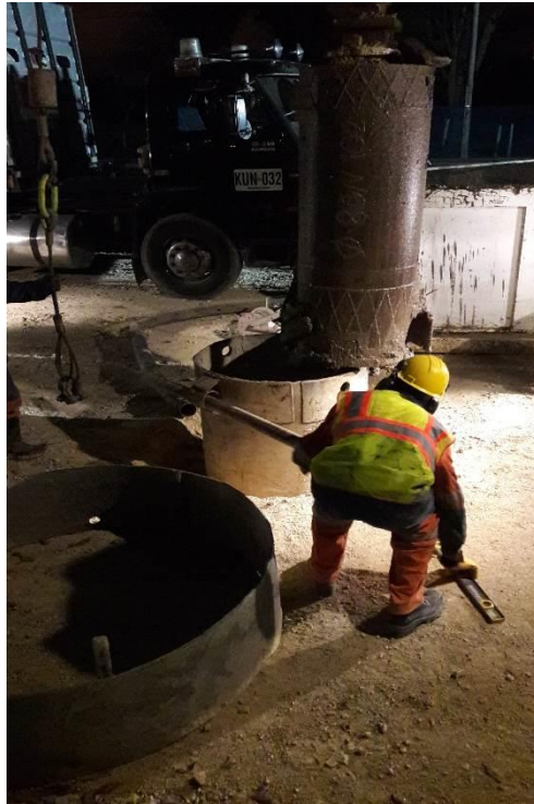
Figura 25: Camisa para la retención de agua con polimero. (Autor)
