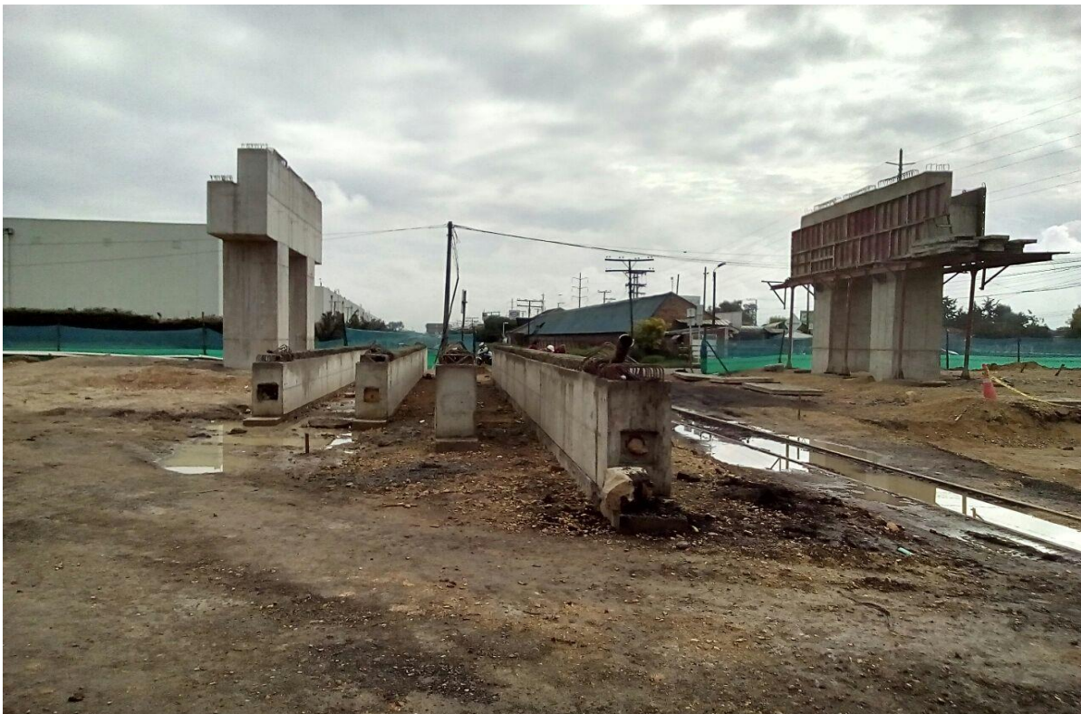
Figura 52: Vigas postensadas de 19.2m listas para izar en las respectivas vigas cabezales. (Autor)
