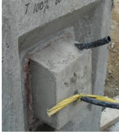
Figura 70: Manguera de polipropileno para inyección de lechada. (Autor)
