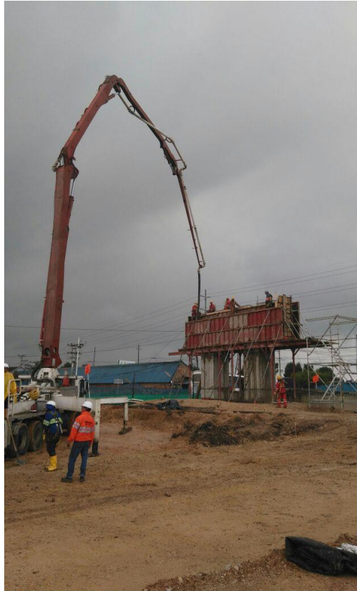
Figura 49: Vaciando concreto con autobomba. (Autor)
