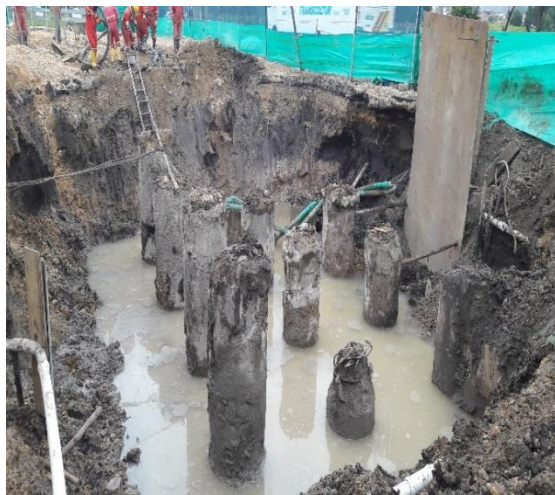
Figura 28: Mejoramiento de los taludes con lámina. (Autor)
