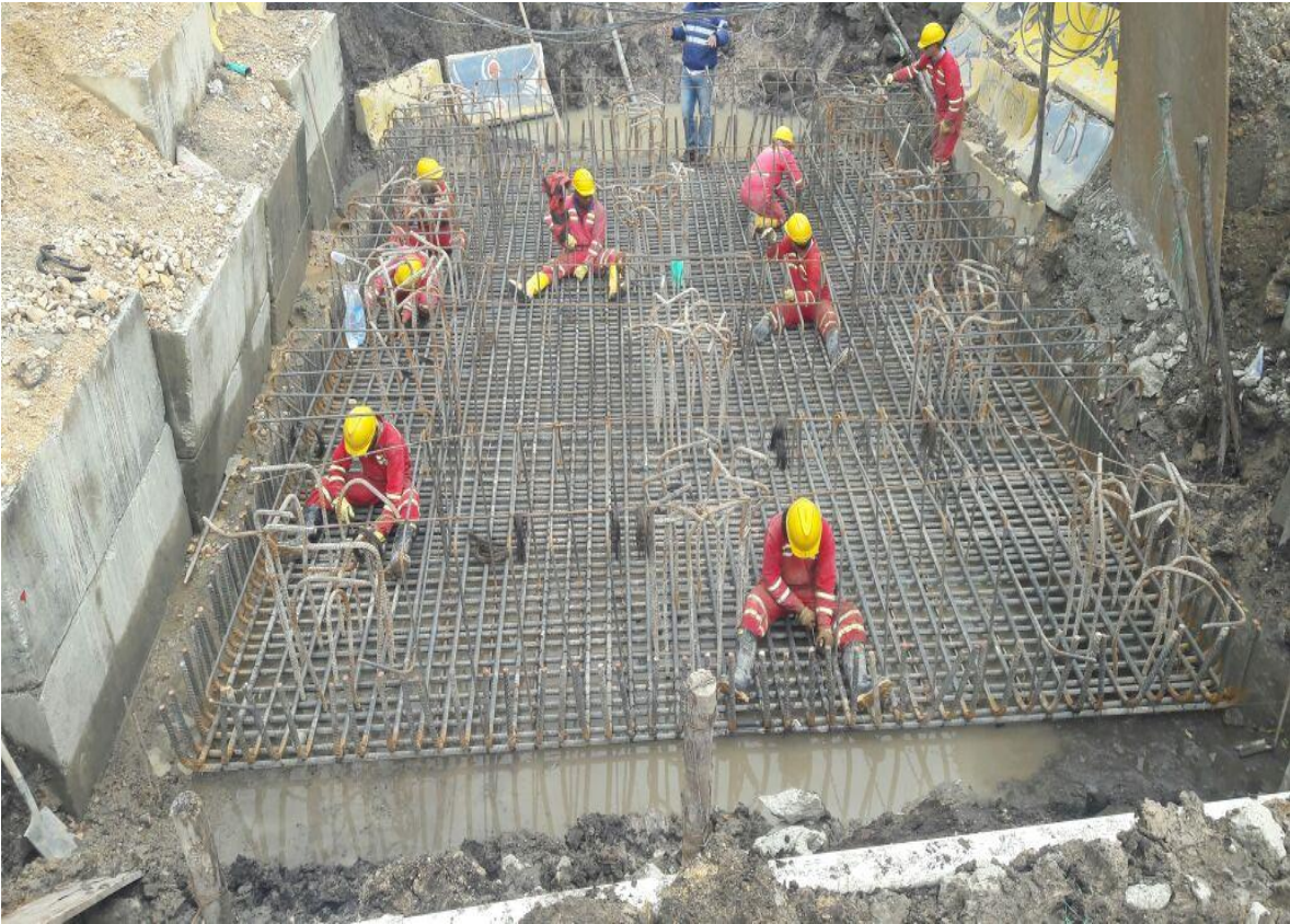
Figura 33: Amarre de refuerzo inferior zapata sobre el eje 4. (Autor)
