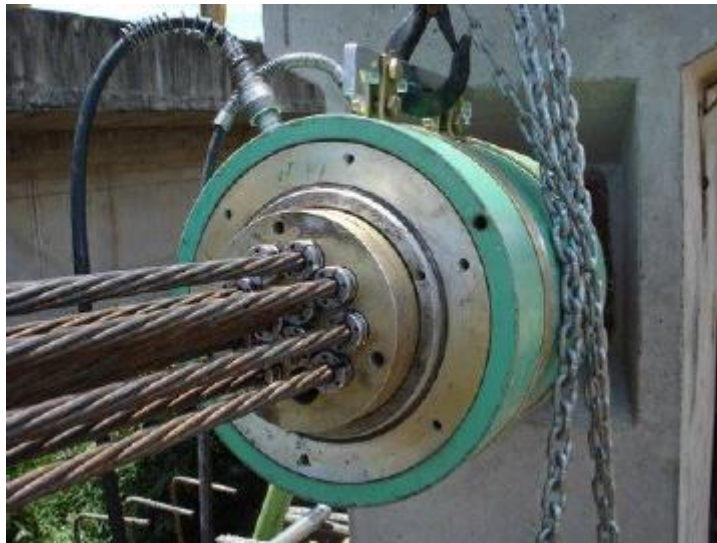
Figura 66: Gato utilizado para tensionamiento. (Autor)
