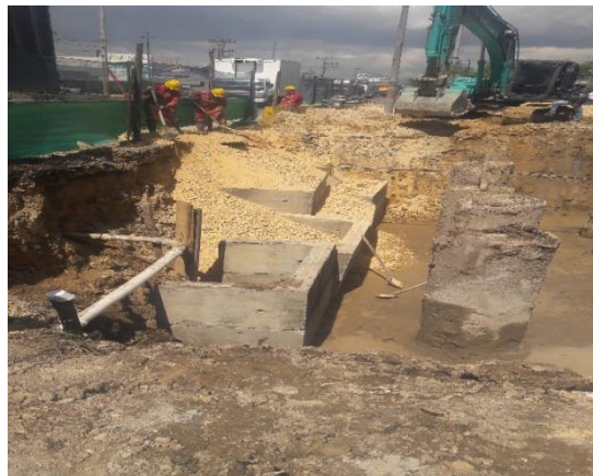
Figura 27: Mejoramiento de los taludes con box coulvert. (Autor)
