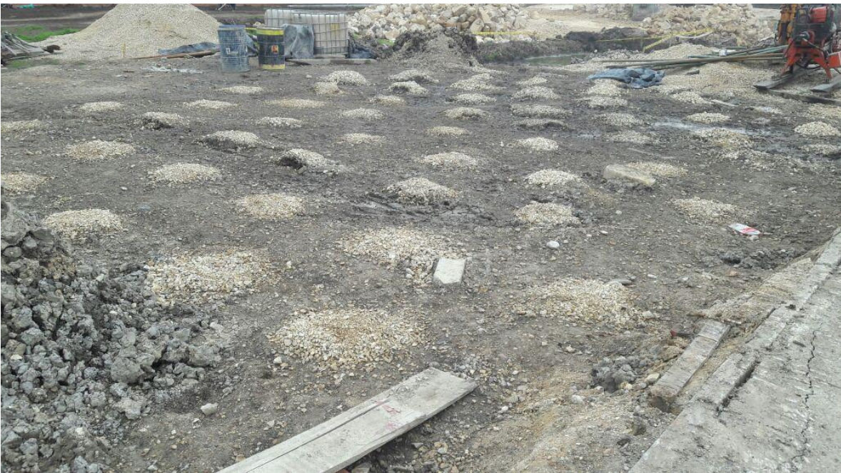
Figura 6: Drenes verticales terminados sobre el eje 1. (Autor)
