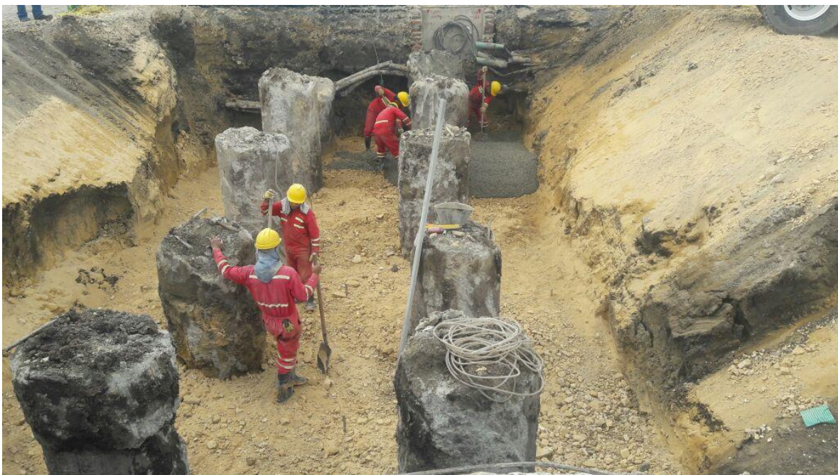
Figura 38: Nivelación de cota de solado. (Autor)
