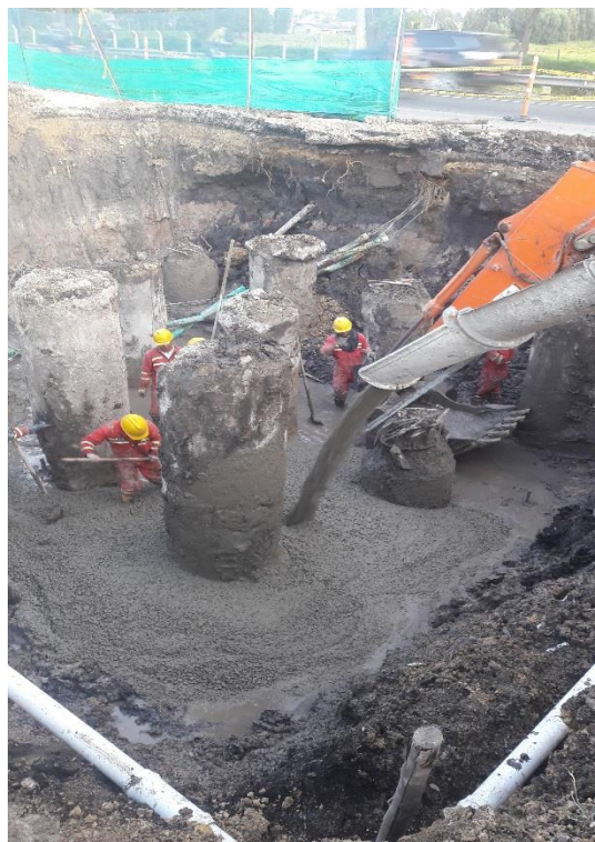
Figura 29: Fundida de solado. (Autor)
