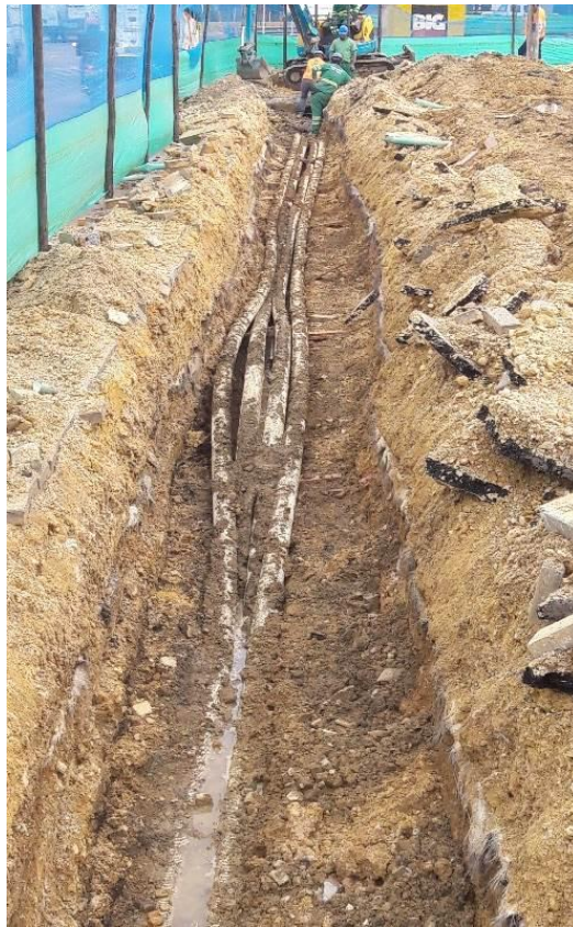
Figura 17: Movimiento de redes sobre el eje 2. (Autor)
