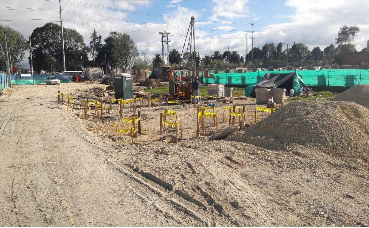
Figura 5: Demarcación topográfica de drenes verticales sobre el eje 1. (Autor)
