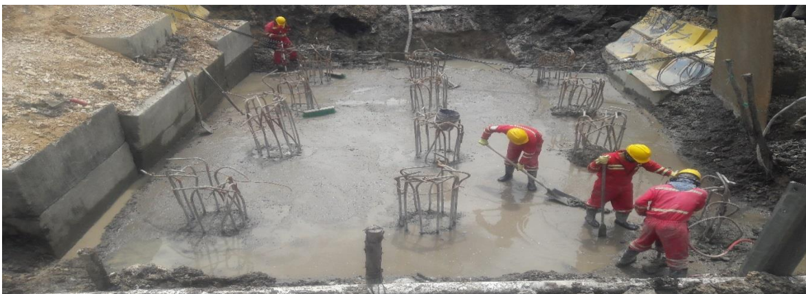
Figura 31: Agregando flejes a los pilotes después del descabece. (Autor)
