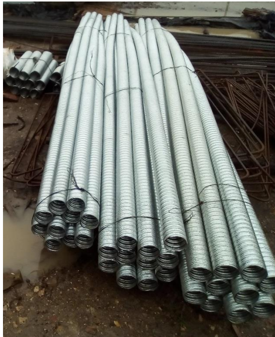
Figura 61: Ductos y acoples de fleje de acero galvanizado. (Autor)
