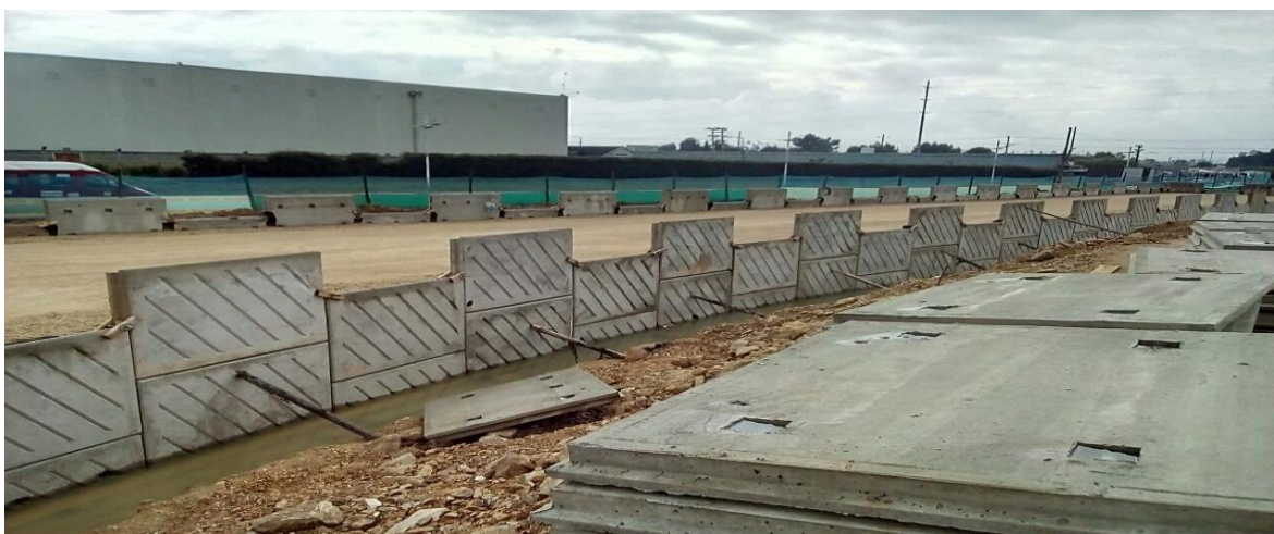
Figura 16: Material compactado y listo para recibir correas en muro sobre el eje 1.
