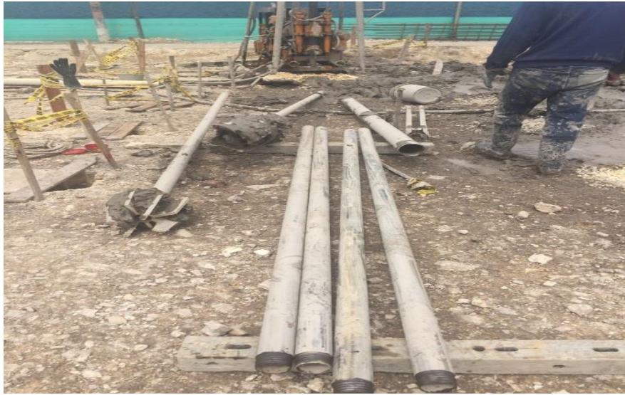
Figura 6: Tubería en secciones de 3 m. (Autor)
