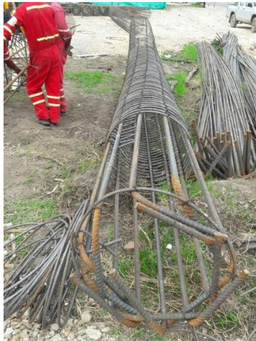
Figura 20: Armadura de pilote bien fabricada. (Autor)
