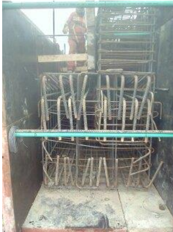
Figura 48: Refuerzo viga cabezal sobre el eje 2 y eje 3. (Autor)
