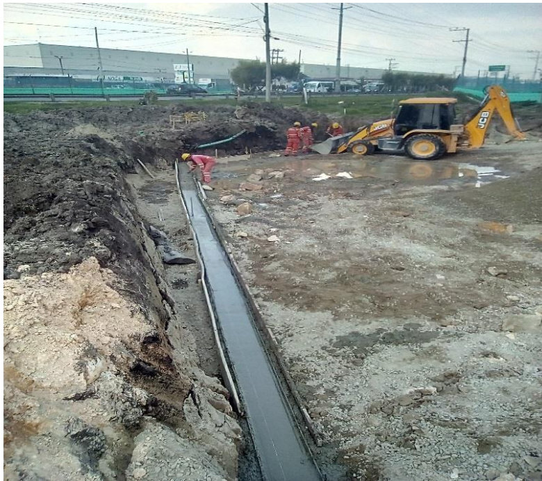
Figura 9: Viga solera muro en tierra armada sobre el eje 5. (Autor)
