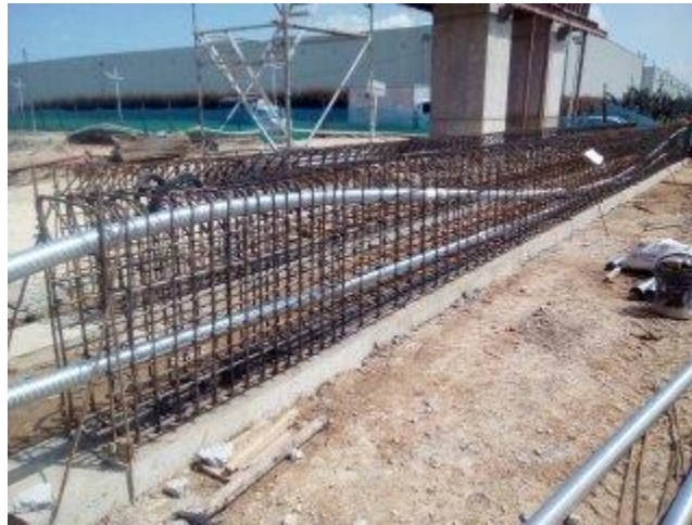
Figura 62: Ductos posicionados por taches. (Autor)
