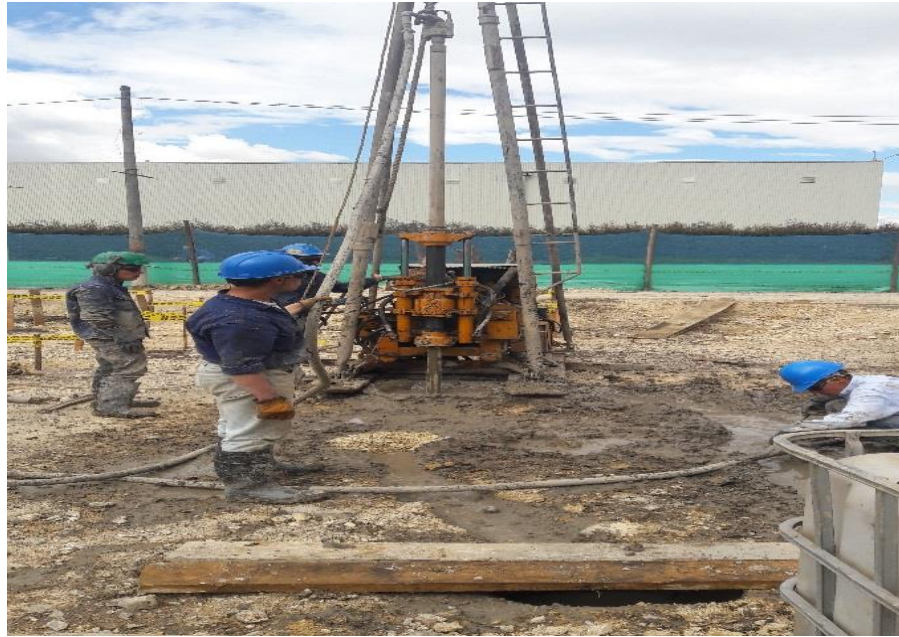
Figura 5:Perforación de drenes verticales sobre el eje 1. (Autor)
