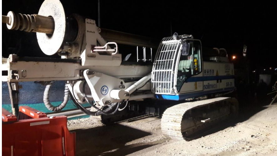
Figura 19: Máquina Piloteadora. (Autor)
