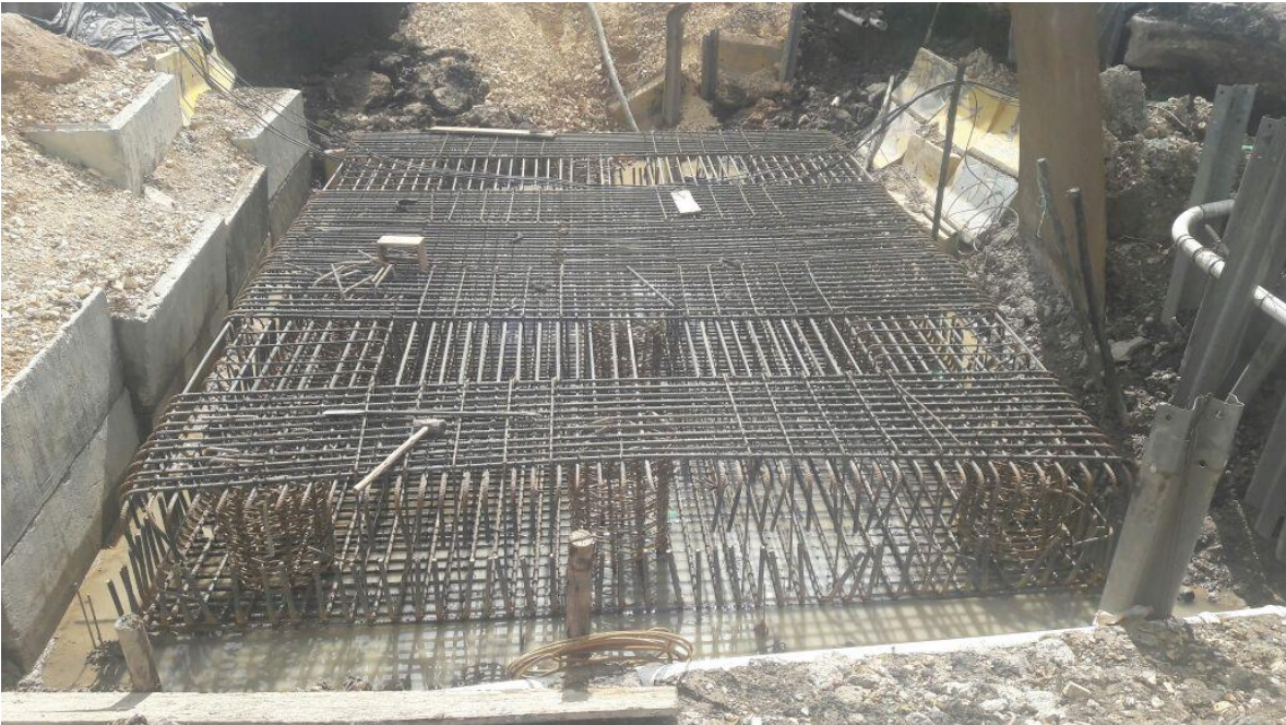
Figura 35: Amarre refuerzo superior zapata sobre el eje 4. (Autor)
