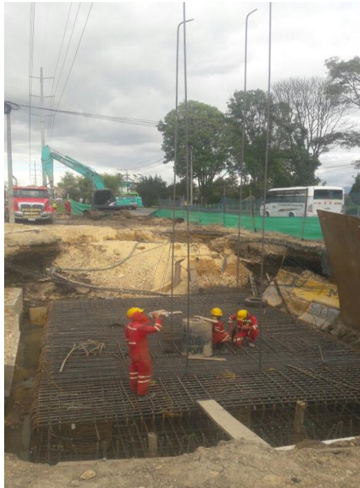
Figura 36: Puesta en sitio acero pilas sobre el eje 4. (Autor)
