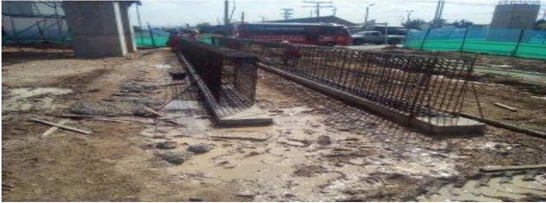
Figura 50: Pista para refuerzo viga postensada 19.2 m. (Autor)
