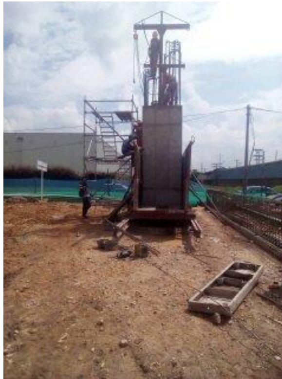
Figura 46: Izaje estructura formaleta para viga cabezal. Autor
