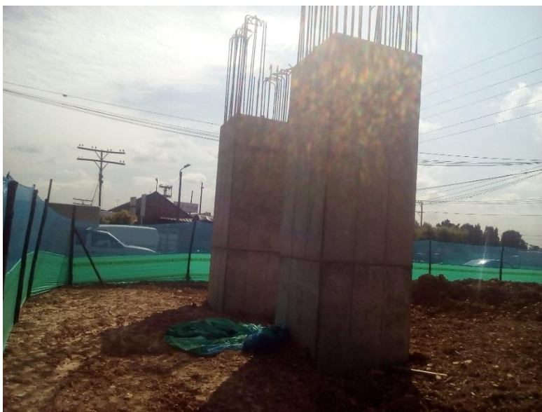
Figura 45: Pilas fundidas. (Autor)
