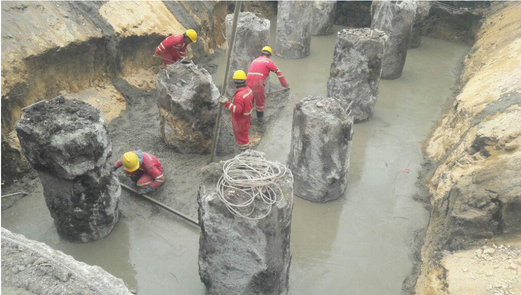
Figura 39: Solado zapata sobre el eje 2 y 3. (Autor)
