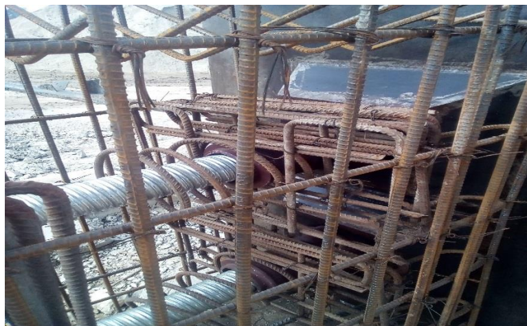
Figura 63: Refuerzo helicoidal o espiral. (Autor)
