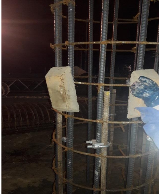
Figura 29: Pannels puestas en sitio. (Autor)
