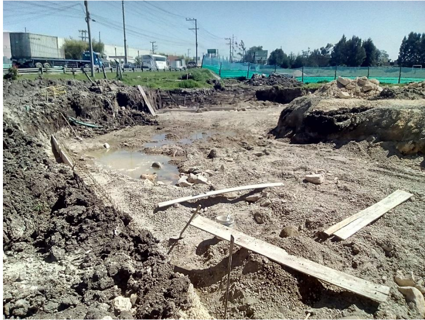
Figura 7: Arena de río, piedra rajón y triturado sobre el eje 5. (Autor)
