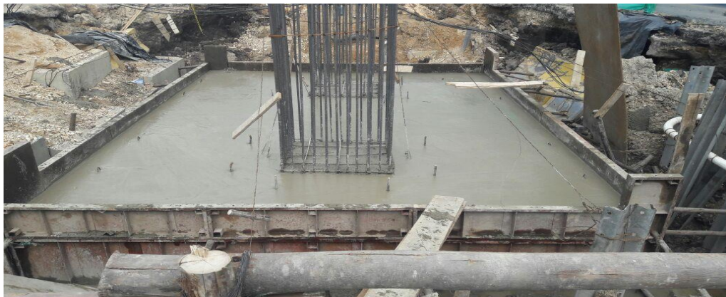
Figura 37: Zapata fundida sobre el eje 4. (Autor)
