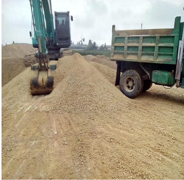
Figura 3: Material seleccionado para tierra armada. (Autor)
