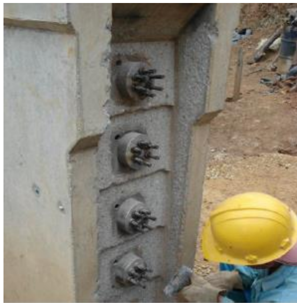
Figura 69: Cables cortados listos para sellar. (Autor)
