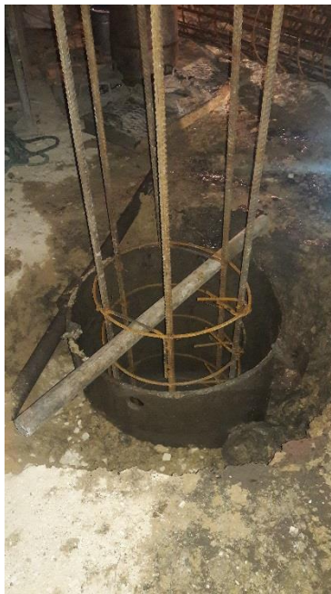
Figura 21: Armadura lista para traslajar. (Autor)
