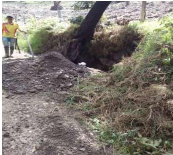
Imagen 6: Limpieza de pontones y Box Couvert, incluye rectificación de descoles con retiro de sobrantes y obstáculos.
