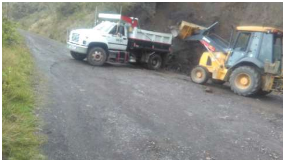
Imagen 5: Transporte de material de afirmado y/o granular.
