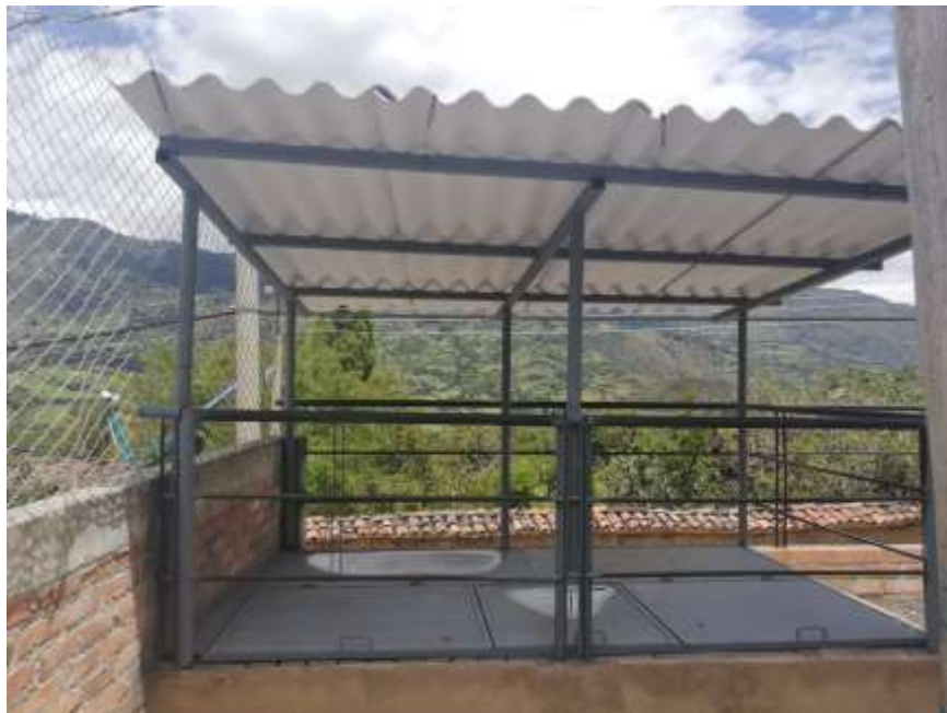
Imagen 12: Instalación cubierta en teja fibrocemento número 8
