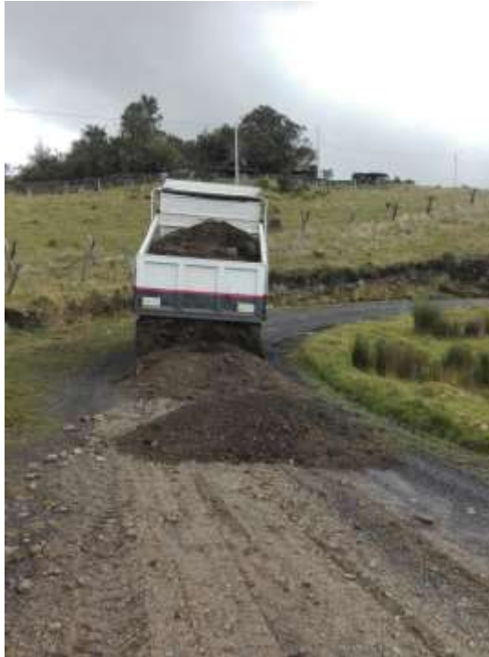
Imagen 4: Transporte de material de afirmado y/o granular.
