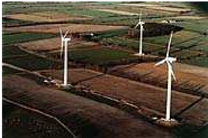
Figura 3 Torres tubulares de acero
