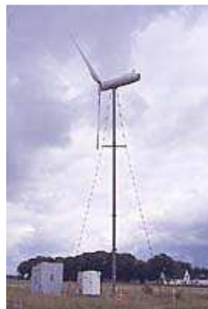
Figura 5 Torre de mástil tensado por cables
