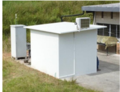
Figura 31: Recinto (container) – Vista lateral
