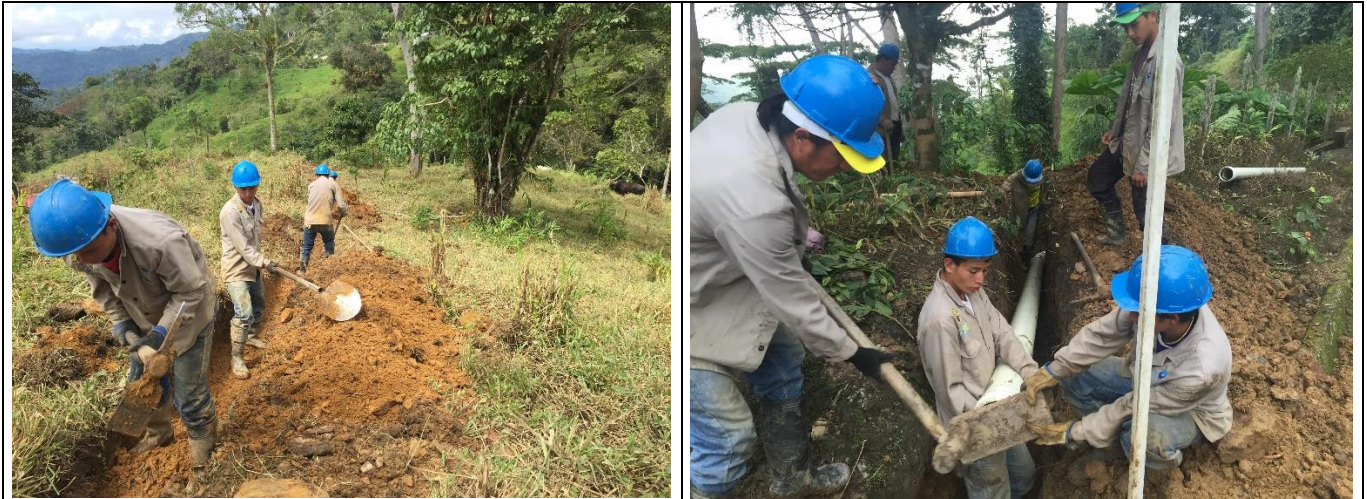
Figura 14: Excavación en tierra e instalación de tubería
