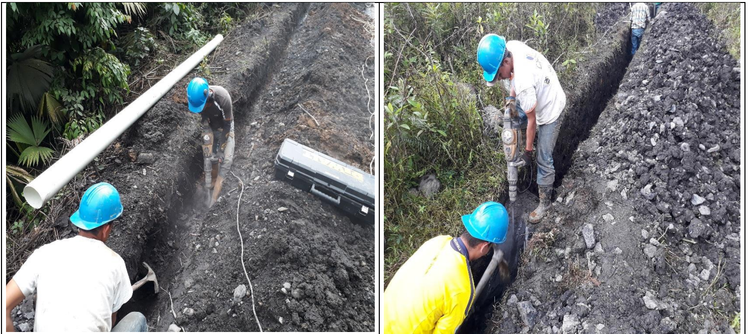
Figura 17: Labores de excavación en roca.
