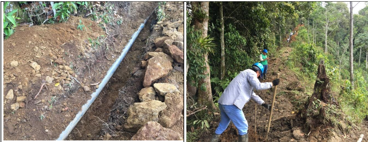
Figura 7: Aparición de tubería acueducto veredal durante excavación y cambio de trazado.
