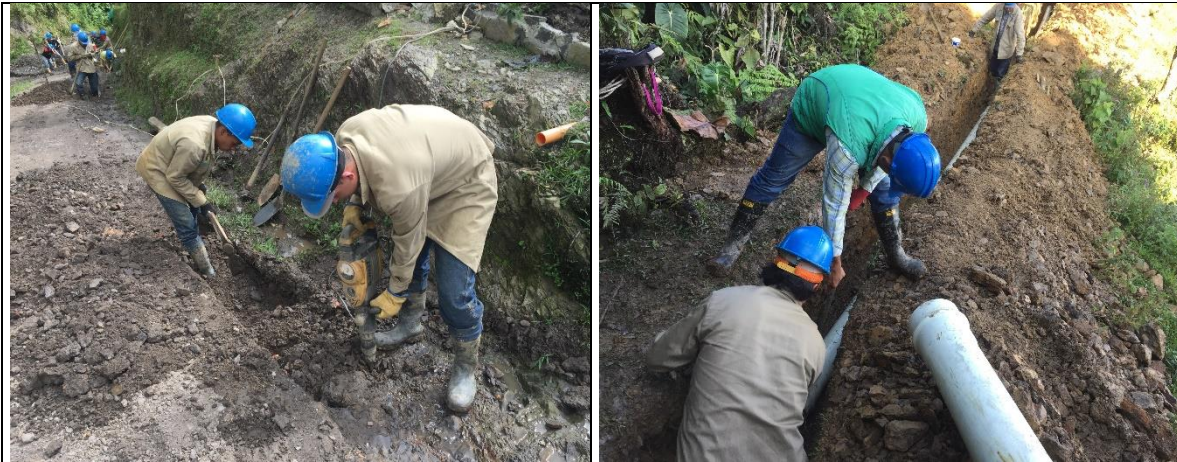
Figura 20: Intervención de vía pública con taladro e instalación de tubería.
