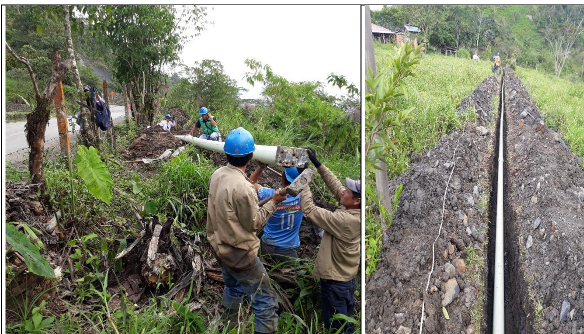
Figura 22: Instalación y detalle de tubería instalada
