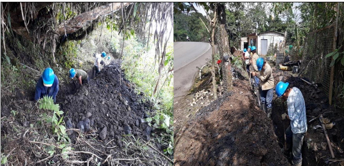
Figura 21: Labores de excavación en tierra.
