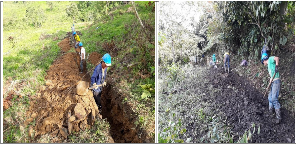
Figura 16: Labores de excavación en tierra.
