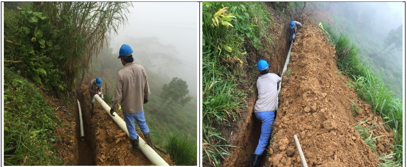
Figura 15: Instalación de tubería usando el lubricante
