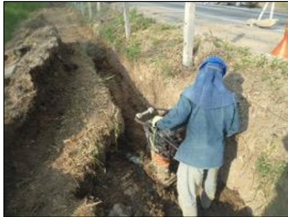
Figura 12. Compactación de relleno
