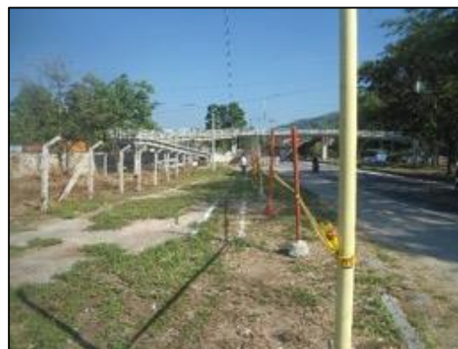
Figura 4. Trazado de líneas de red sobre el terreno
