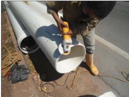
Figura 9. Preparación del tubo
