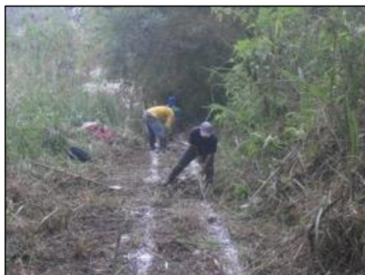
Figura 3. Trazado de líneas de red sobre el terreno
