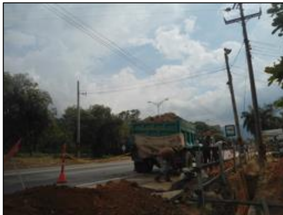
Figura 15. Uso de volqueta para retiro de sobrantes
