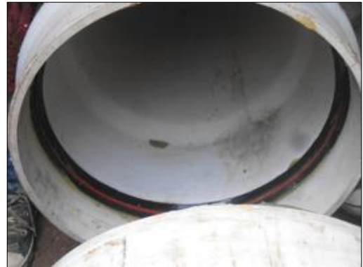
Figura 10. Conexión espiga-campana
