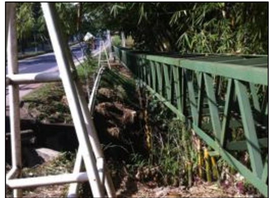
Figura 14. Cercha metálica para conducción de tubería en hierro dúctil
