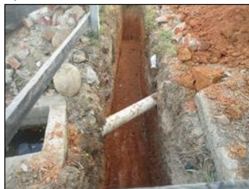
Figura 8. Perfilado de paredes y piso en zanja
