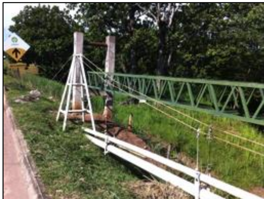
Figura 13. Pórtico de apoyo en concreto reforzado
