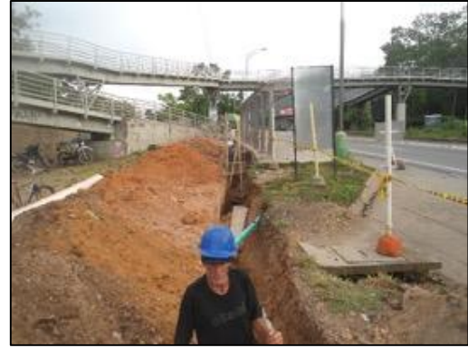
Figura 6. Excavación en zanja
