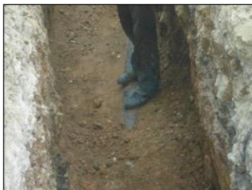
Figura 7. Cama de arena para cimentación de tubería
