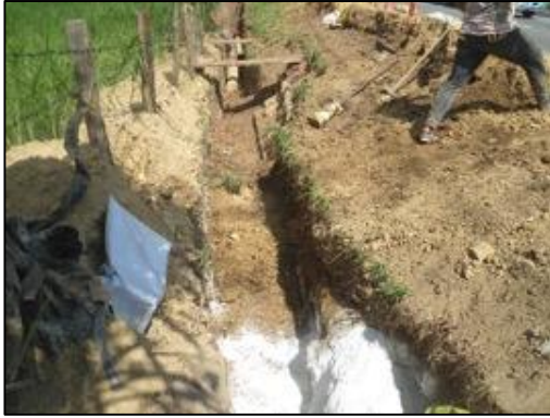
Figura 5. Excavación en zanja
