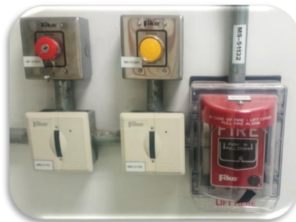
Figura 15. Estación de Descarga(MF Botón Rojo), Estación de Aborto(MA Botón Amarillo), Modulo monitor(MM caja blanca) Estación Manual(MS Manija Roja)
