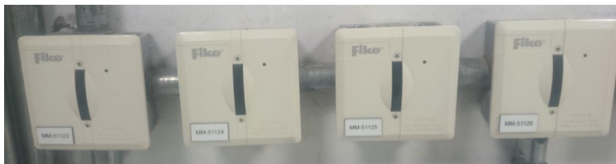
Figura 18. Campana (BS Color Rojo), Modulo de control(MC Caja blanca).
