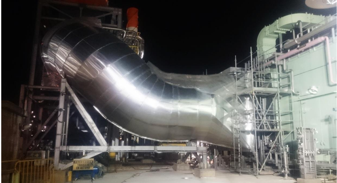
Figura 10. Escape del Turbo Generador
