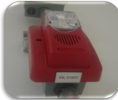
Figura 16. Sirena y Luz Estroboscópica Interior(IHL Caja Roja)
