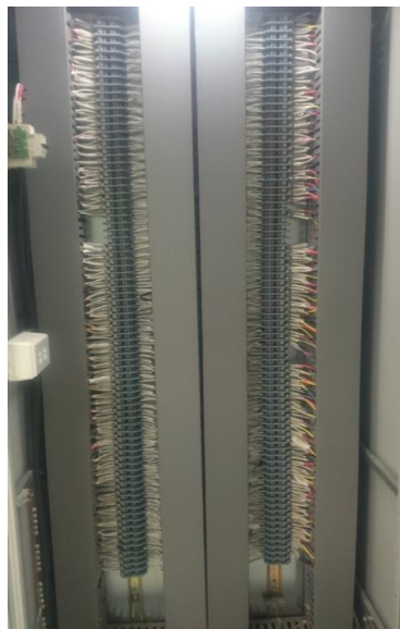
Figura 22. Gabinete de Bornes
