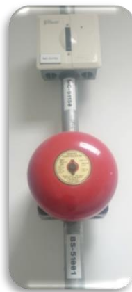
Figura 18. Campana (BS Color Rojo), Modulo de control(MC Caja blanca).
