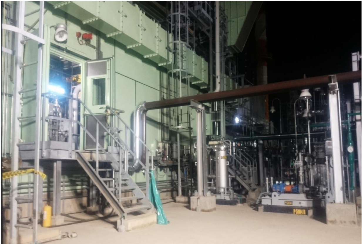
Figura 6. Turbo Generador
