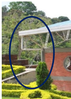
Fotografía 2 Sistema de recolección (Bajantes-sifones)
