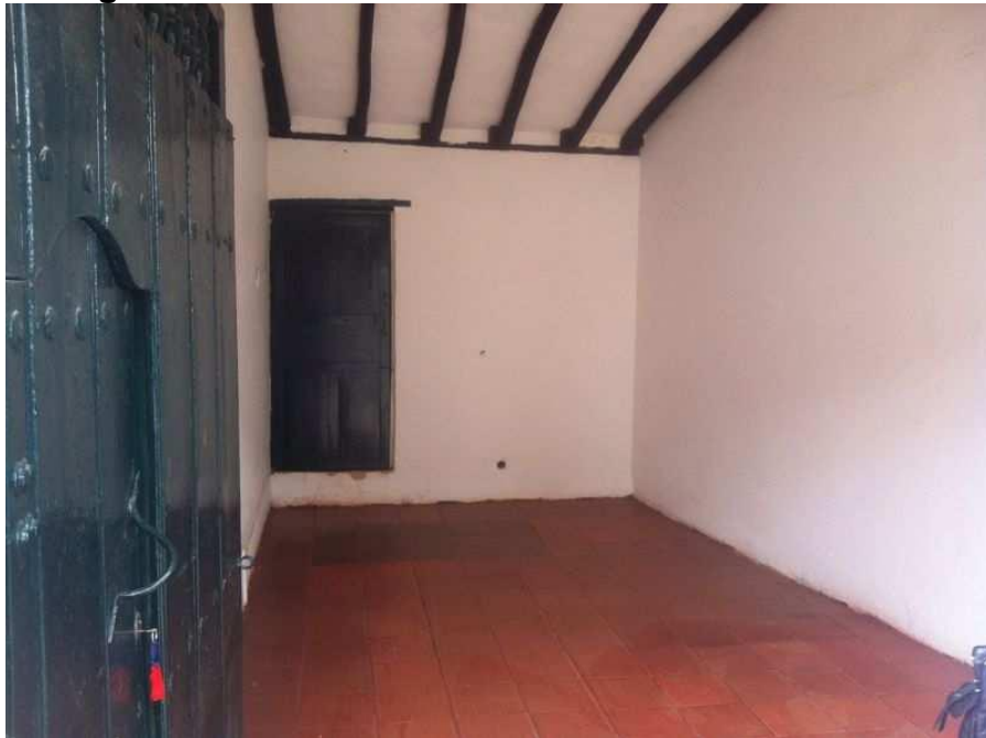
Imagen 6. Fotografía del Establecimiento antes de la adecuación
