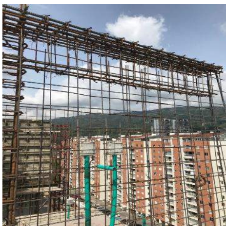
Figura 43. Viga T eje 7 (Ortiz, 2021)
