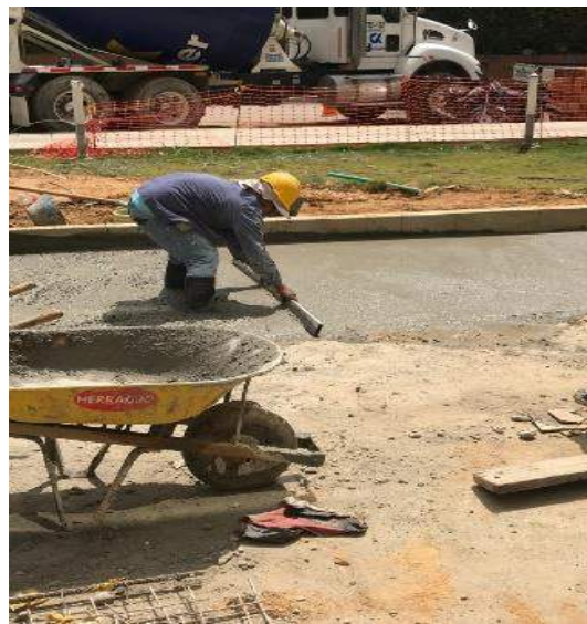
Figura 13. Acabado de concreto (Ortiz,2021)
