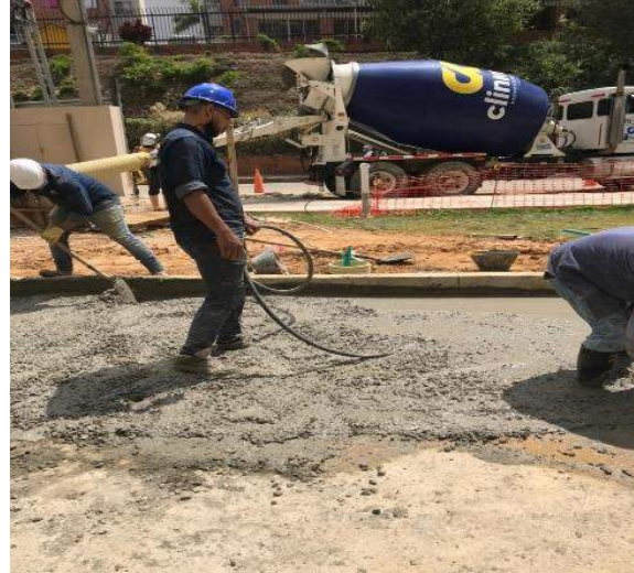
Figura 12. Vibrado del concreto (Ortiz,2021)
