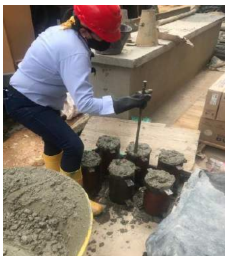
Figura 56. Elaboración cilindros de concreto (Ortiz,2021)
