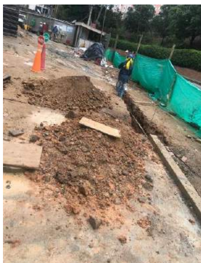
Figura 18. Excavación de sardinel (Ortiz, 2021)
