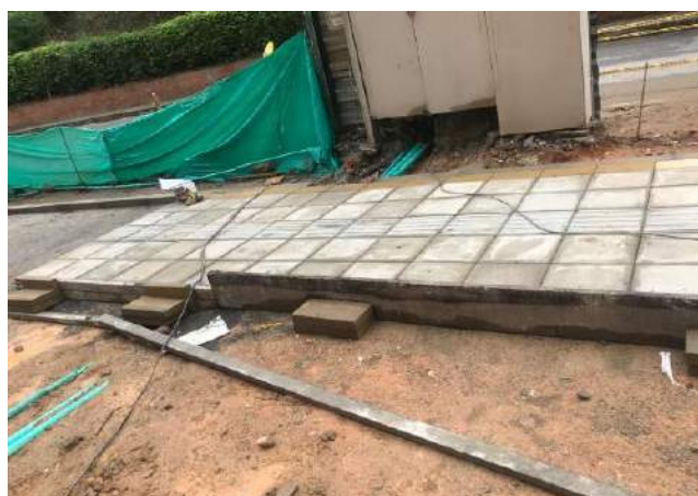
Figura 22. Instalación loseta (Ortiz,2021)
