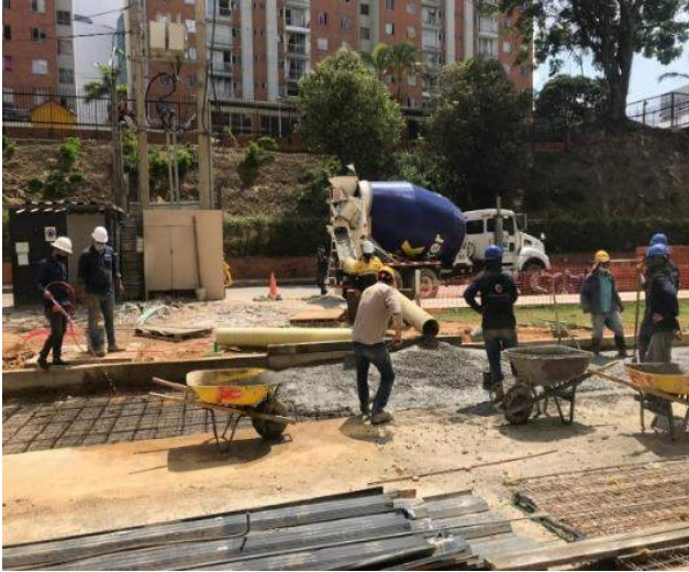
Figura 11. Extensión de concreto (Ortiz,2021)
