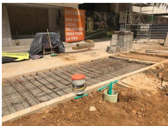
Figura 9. Armado de parrilla de refuerzo (Ortiz, 2021)
