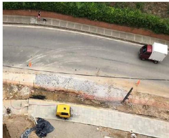
Figura 27. Demolición andén existente(Ortiz,2021)
