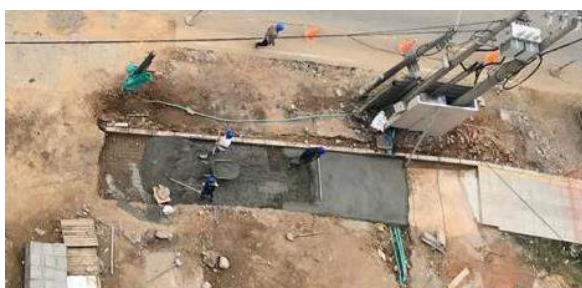
Figura 20. Fundida losa de concreto (Ortiz,2021)
