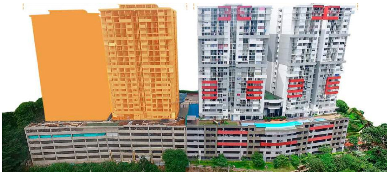
Figura 4. Proyecto cacique plaza (Constructora Valderrama, 2020)
