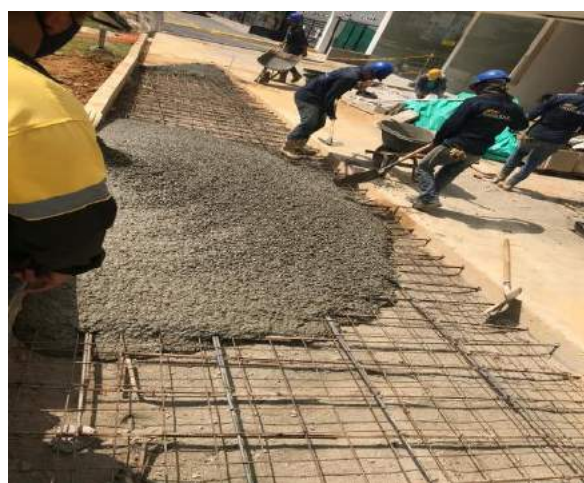
Figura 10. Vaciado de concreto (Ortiz, 2021)
