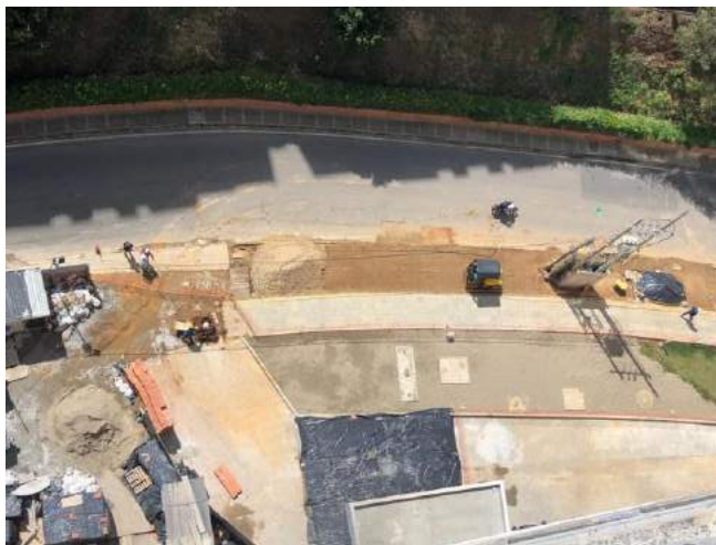
Figura 28. Compactación de bahía (Ortiz,2021)
