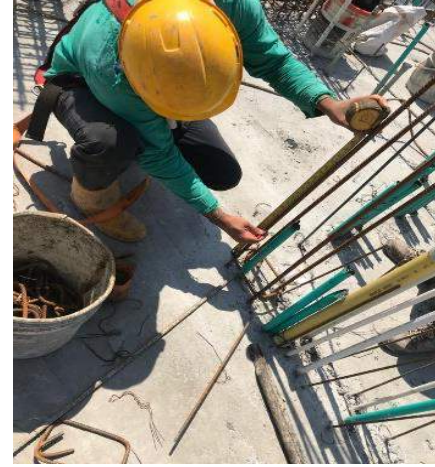
Figura 47. Armado de E.B. (Ortiz, 2021)
