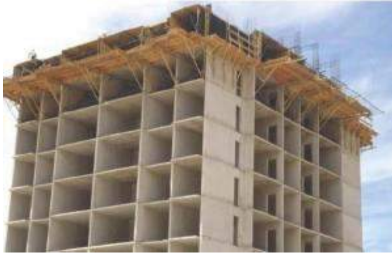
Figura 50. Encofrado tipo túnel (UPV,2021)
