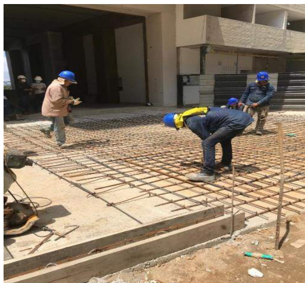
Figura 14. Refuerzo de pompeyano (Ortiz,2021)
