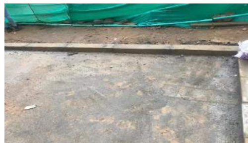
Figura 21. Losa de concreto (Ortiz,2021)
