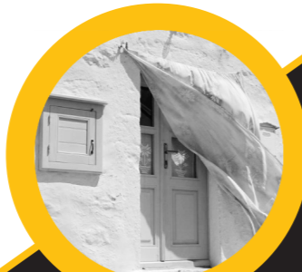
Imagen 8: Composición Fachada: Todo nada. Luis Angel. 2015. México. El habitar la vivienda y expresarla desde su fachada con aspectos arquitectónicos como lo es la profundidad y densidad de elementos como puertas y ventanas.
