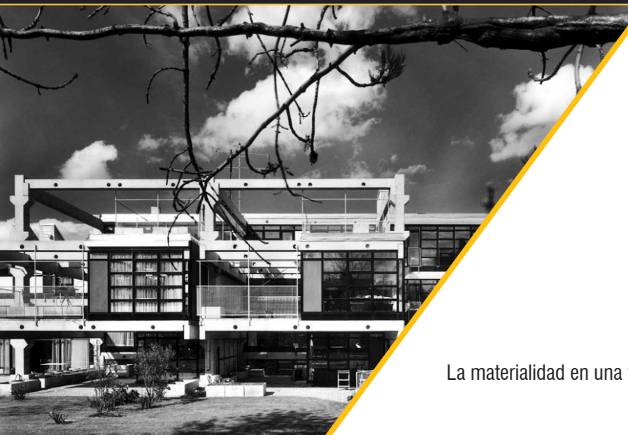
Imagen 14: Estructura delimitante. Wohnanlage Genter Strasse. Otto Steidle and Partner. 1972. En este Proyecto se aplica en un primer plano la estructura para luego tener unas espacialidades interiores limitadas.
