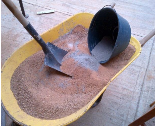
Figura 25. Adición de cemento
