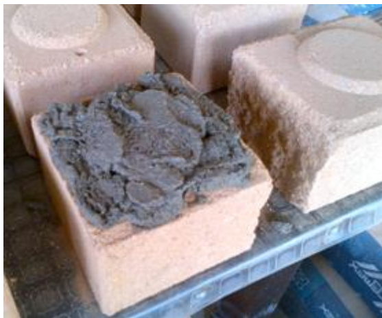
Figura 16. Esparcimiento del mortero de pega
