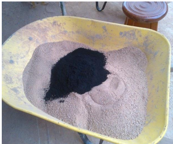
Figura 24. Adición de ceniza
