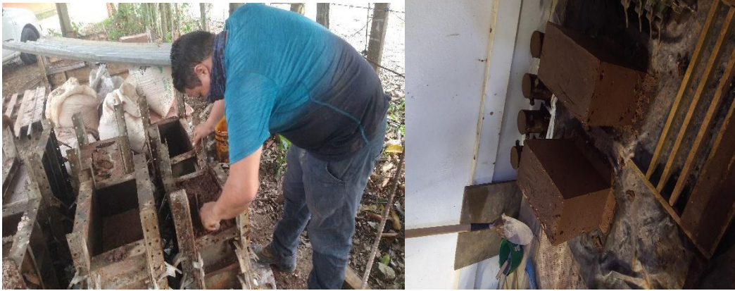
Figura 13. Preparación del vertido (A. vertido, enrazamiento y vibrado del vertido) (B. vertido desencofrado)
