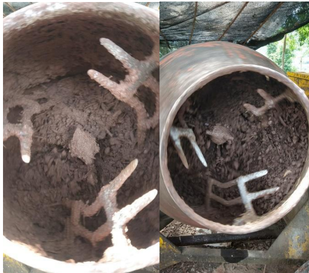
Figura 17. Mezcla de agregados con bagazo (A. mezcla de los agregados vista superior) (B. mezcla de los agregados vista lateral)
