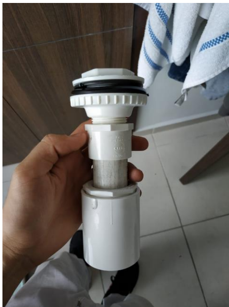
Gráfica 19: Unión de tuberías de descarga
