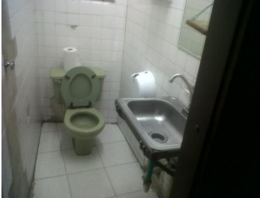
Fotografía 1. Baños del edificio
