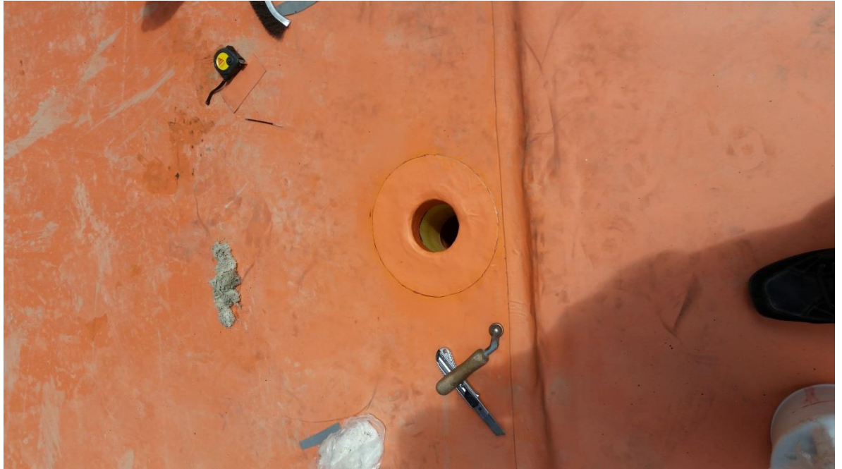
Figura 5. Remate de impermeabilización con membrana de pvc en bajante hidráulico. Fuente propia
