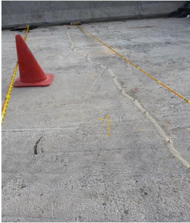
Figura 1. Proceso de inyección epóxica (emboquillado y sello de fisuras). Fuente propia.
