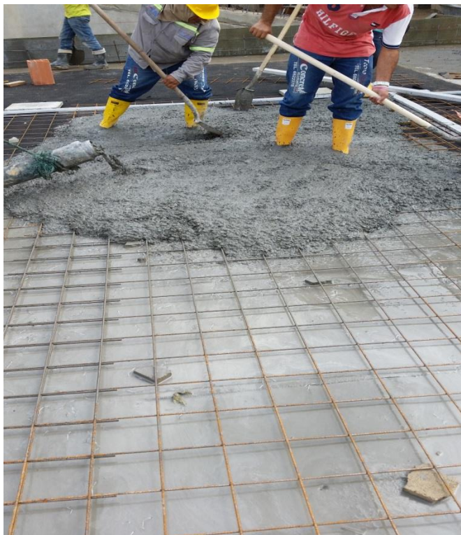
Figura 8. Vaciado de concreto por medio del sistema de manguera. Fuente propia
