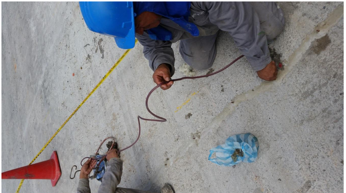
Figura 2. Proceso de inyección epóxica con compresor. Fuente propia.
