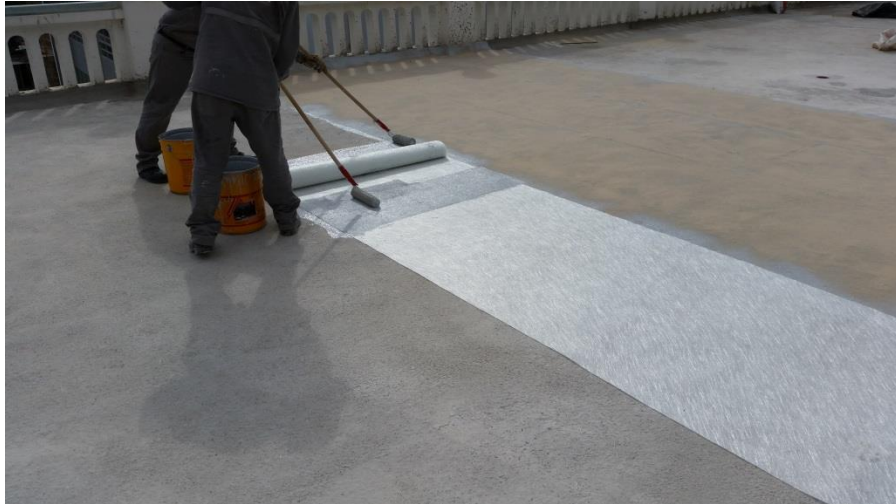
Figura 3. Impermeabilización con Sicalastic 612. fuente propia.
