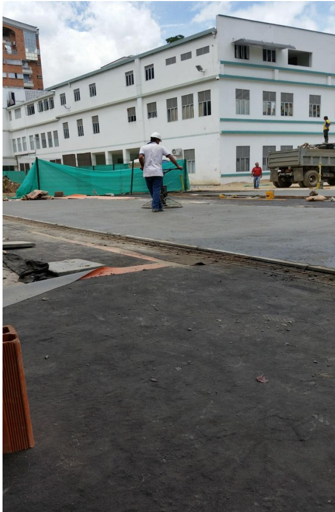
Figura 9. Pulida de concreto con allanadora mecánica. Fuente propia
